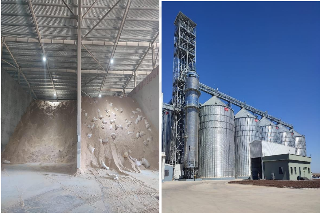
Şekil 2.4: Hammaddenin Depolanması (Yatay depo ve elik silolar)
