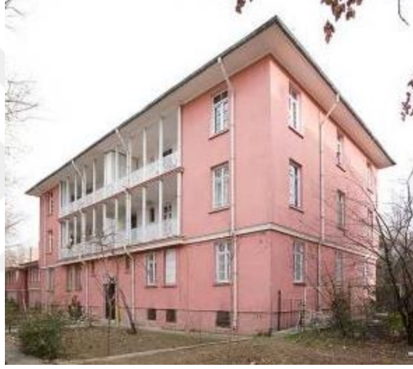
Şekil 6. Saraçoğlu Mahallesi konutları (Merdim, 2013)
