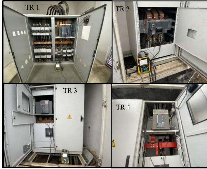
Şekil 3.1. Trafo modüler hücreleri AG panosu harmonik ölçümleri
