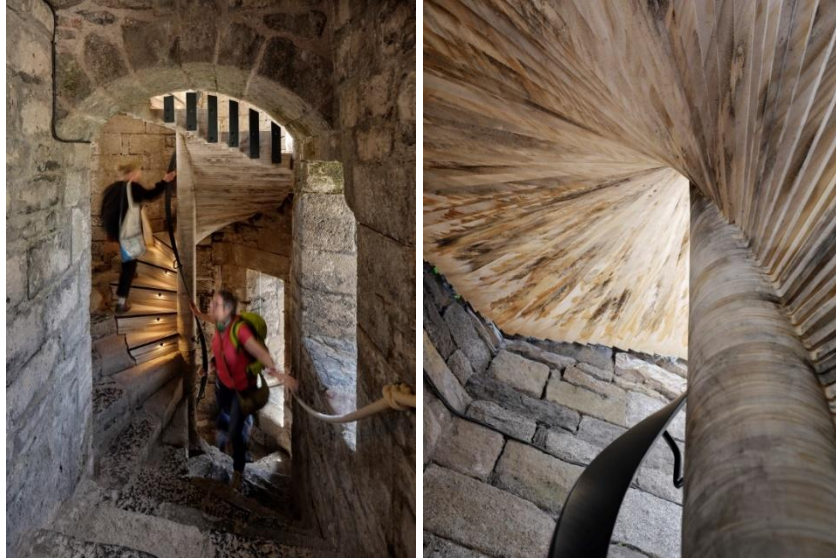
Şekil 3.17. Sağdaki resim: Yeni ahşap spiral merdiven, soldaki resim: Ahşap spiral merdiven, (Pintos, 2024)
