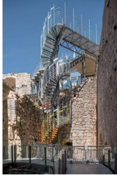
Şekil 3.72. Çelik Merdivenler ve Yürüyüş Yolları (Muñoz, 2018)
