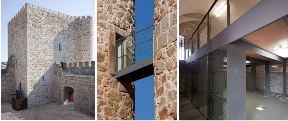
Şekil 4.11. Girişe erişmek için kullanılan soldaki kahverengi merdiven ve kulenin üstüne eklenen parapet geri dönüştürülebilir olmadığından bu örneğin bu kriter açısından 1/5 puan aldığı değerlendirilmiştir. (Carlos De Riaño Lozano, Imagensubliminal (Miguel De Guzmán + Rocío Romero) · La Coracera Kalesi, n.d.)
