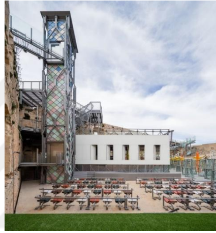
Şekil 3.73. Kalenin Avlusu, Rehabilitasyon Sırasında Yapılan Son Ekleri Gösteriyor (Muñoz, 2018)
