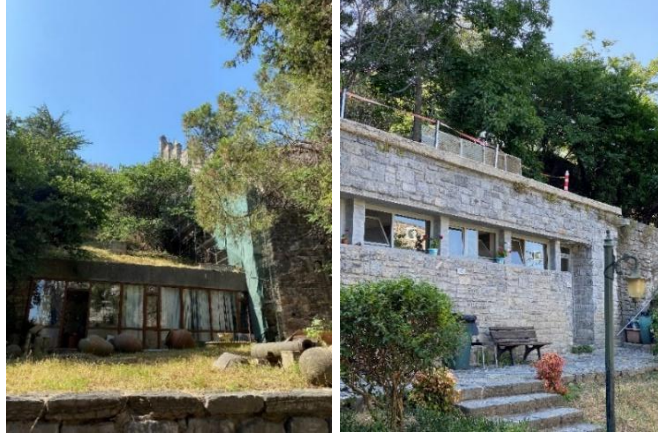
Şekil 3.186. Soldaki resim: Kalenin içinde yeni inşa edilen odalardan biri, Sağdaki resim: Kalenin içinde yeni inşa edilen odalardan biri (WC), (Fotoğraf: Anwaar Anwar Al Mubarak Gharibi, 2023)
