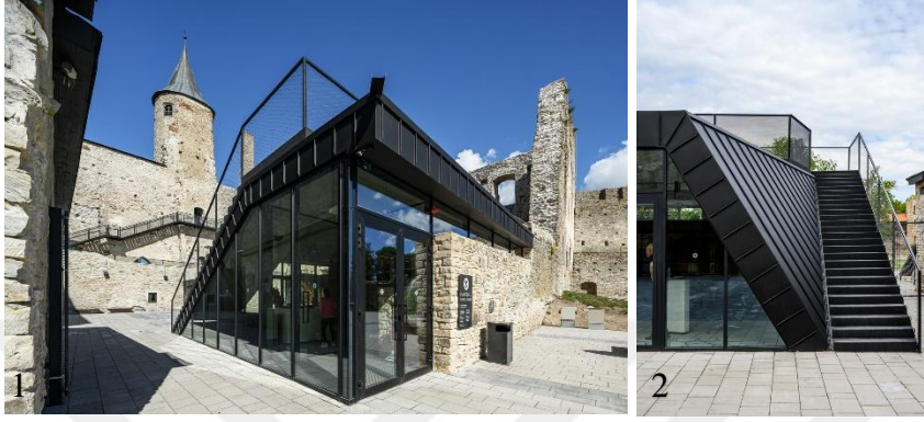
Şekil 3.89. 1,2: Haapsalu Piskoposluk Kalesi Ziyaretçi Merkezi, (Kaos, 2019).
