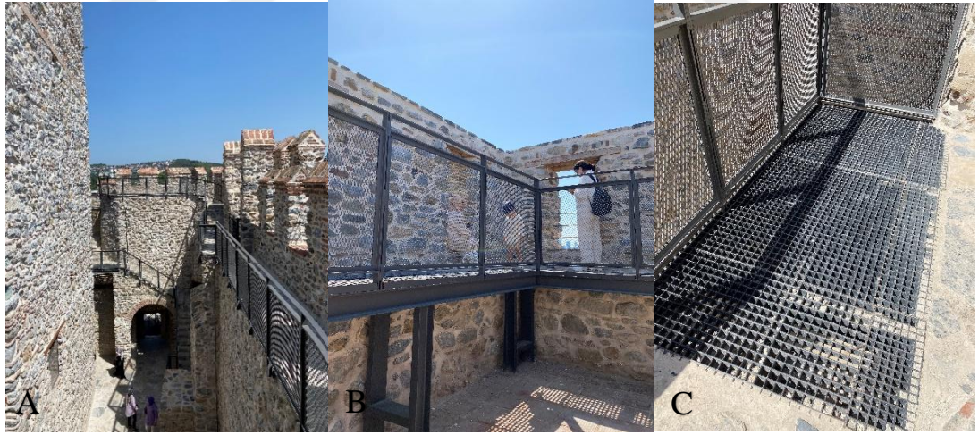
Şekil 3.150. (A)Anadolu Hisarı kaleye eklenen yeni ekler (Çelik Bariyer), (B)Anadolu Hisarı kaleye eklenen yeni ekler (Demir Yürüyüş Yolu ve Bariyer), (C)Anadolu Hisarı kaleye eklenen yeni ekler (Çelik Bariyer ve Zemin), (Fotoğraf: Anwaar Anwar Al Mubarak Gharibi, 2023)
