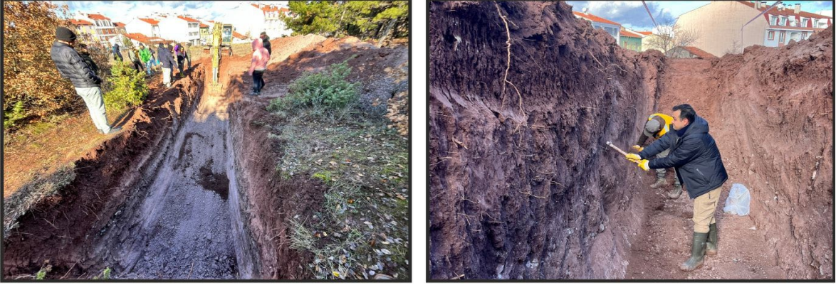
Şekil 4.10. Orman1 hendeği açılması, hendek içi çalışmaları gösteren fotoğraflar.
