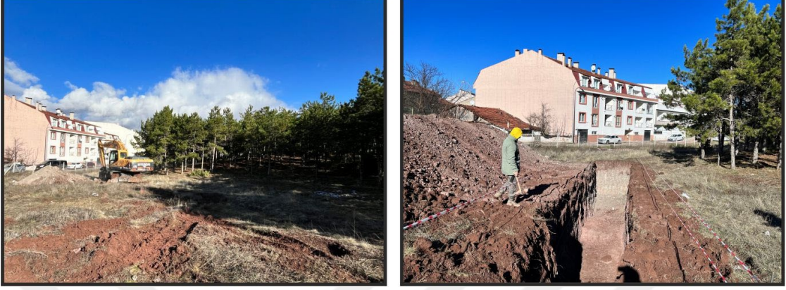
Şekil 4.13. Orman2 hendeği açılması, hendek içi çalışmaları gösteren fotoğraflar.
