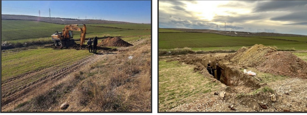
Şekil 4.24. Varol hendeği açılması, hendek içi çalışmaları gösteren fotoğraflar.
