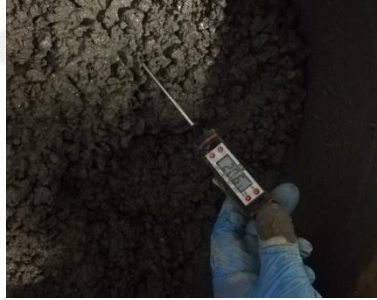
Şekil 3.11. Beton sıcaklığının termometre ile ölçülmesi.
