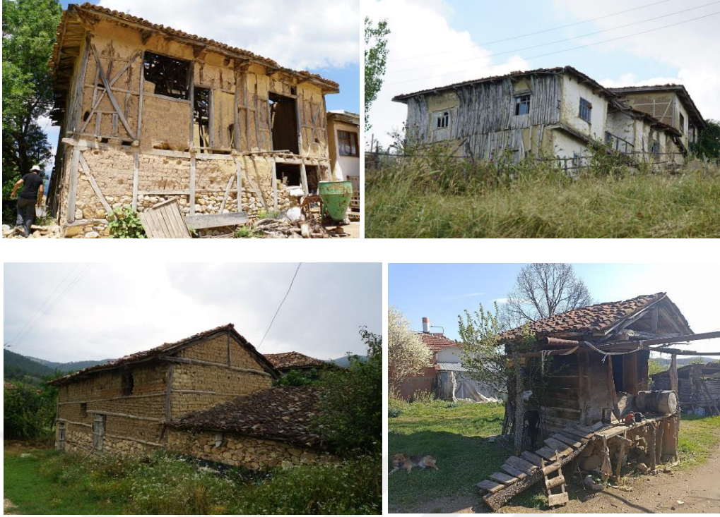
Şekil 3.17 Osmaniye yöresel mimarisinde geleneksel yapı malzemesi kullanımı
