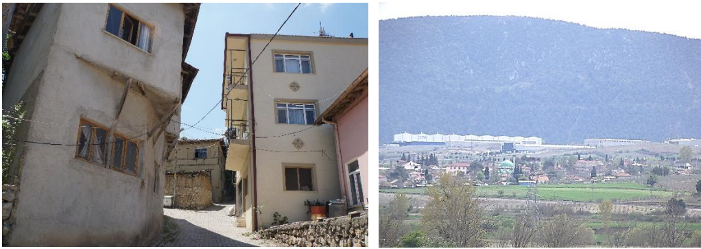
Şekil 5.9 Medetli Köyünde köy karakteri ile uyumsuz apartman (sol) ve Selimiye Köyü ve yakınında gelişen sanayi tesisleri (sağ)
