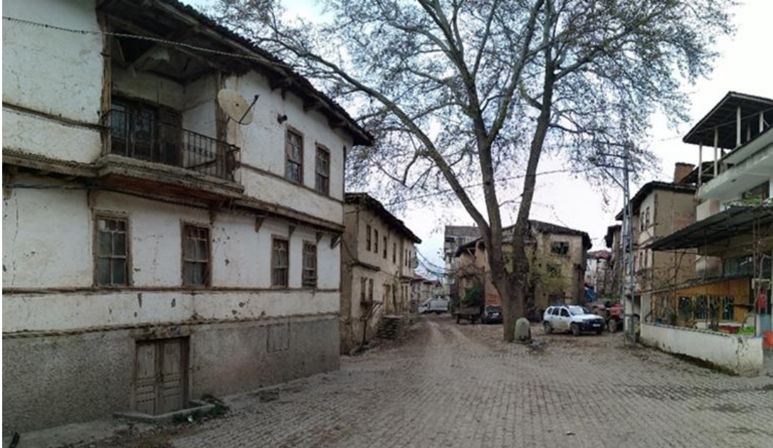
Şekil 3.41 Soğucakpınar Köyü'nde geleneksel köy evinin köy meydanı ile olan ikişksi (187 ada/4 parsel)
