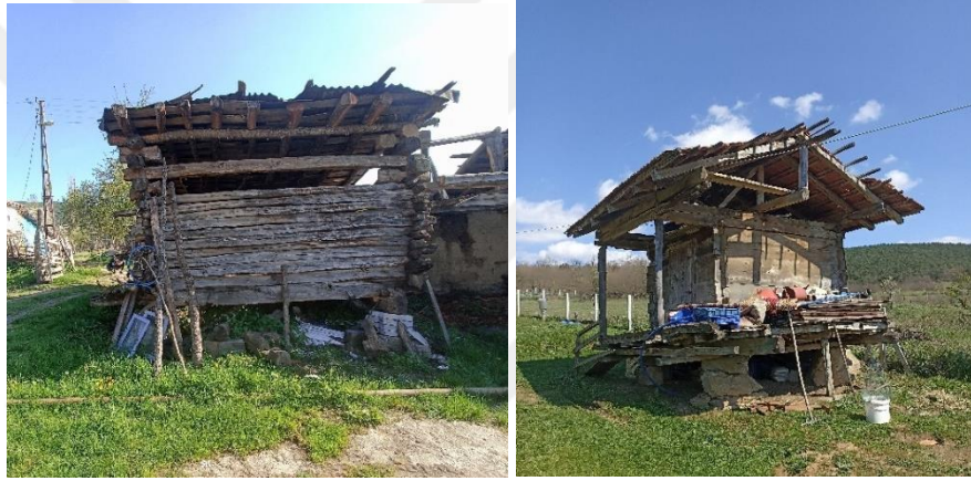
Şekil 3.14 Çantı yapı ahşap birleşimleri (Tuna, 2008).
