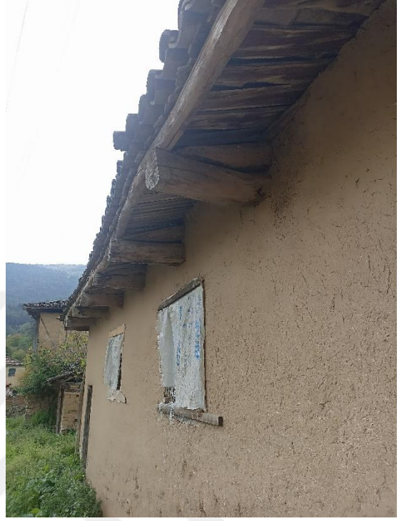
Dereyörük Köyünde samanlık yapısının giriş ve yan cephesi (solda), saçak detayı (sağda).
