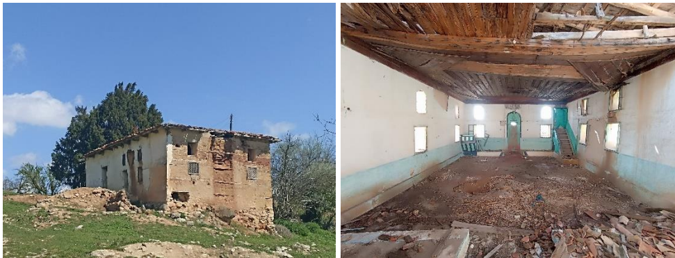
Şekil 3.42 Güneybatı köşesinden ve Son cemaat kısmından çekilen Akçapınar Köy Mescidi fotoğrafları.
