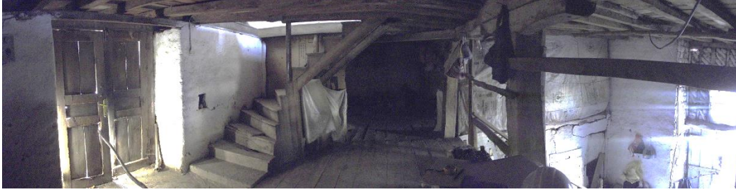
Şekil 3.34 Soğucakpınar Köyü 187 ada/1 parselde bulunan geleneksel konutun ara kat fotoğrafı (ardiyeye).
