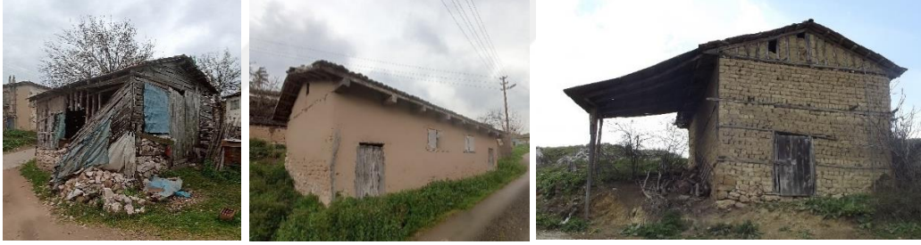
Şekil 3.49 Hımiş ve kerpiç samanlıklar
