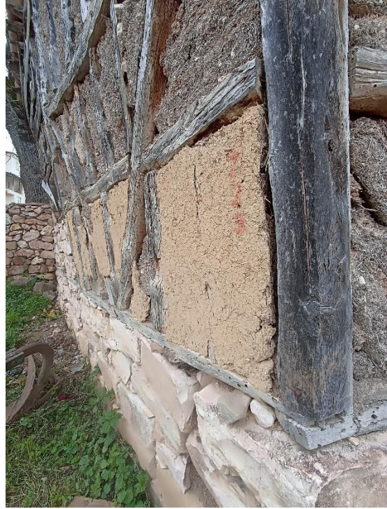
Balçıkhisar Köyünde samanlık yapısının iç mekânı (solda) ve Ahşap karkas – subasman birleşimi.
