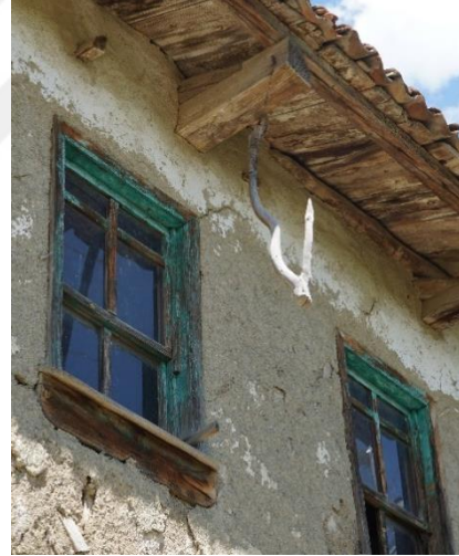
Şekil 3.19 Konutlardaki çiçeklik ve dal askı detayları
