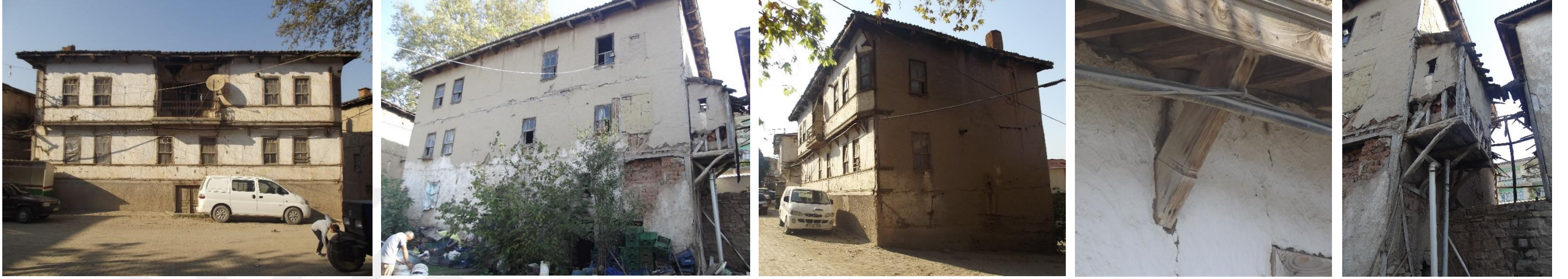
Yapı cepheleri: Giriş cephesi (solda), güneybatı cephesi (ortada), fırın (sağda)
