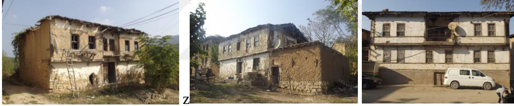
Şekil 3.28 Soldan sağa doğru Kızılöz köyünde 144 ada 6 ve 7 ile Soğucakpınar köyünde 187 ada 4 parsellerdeki yapıların fotoğrafları.
