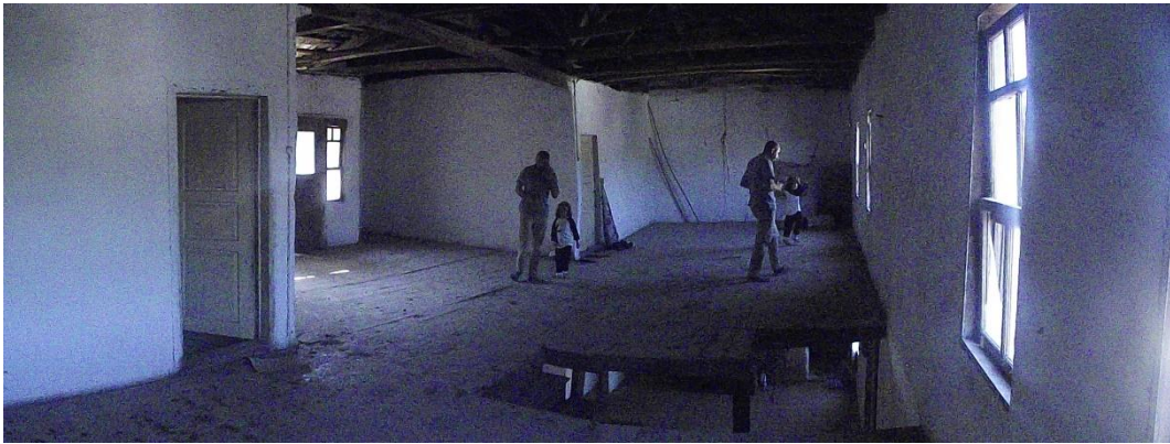
Şekil 3.36 Soğucakpınar Köyü 187 ada/1 parselde bulunan geleneksel konutun ikinci kat fotoğrafı (hayat).
