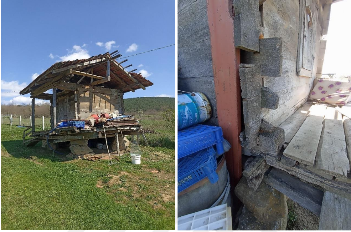
Adliye Köyünde serende yapısının giriş ve yan cephesi (solda), çantı yapım tekniği (sağda).
