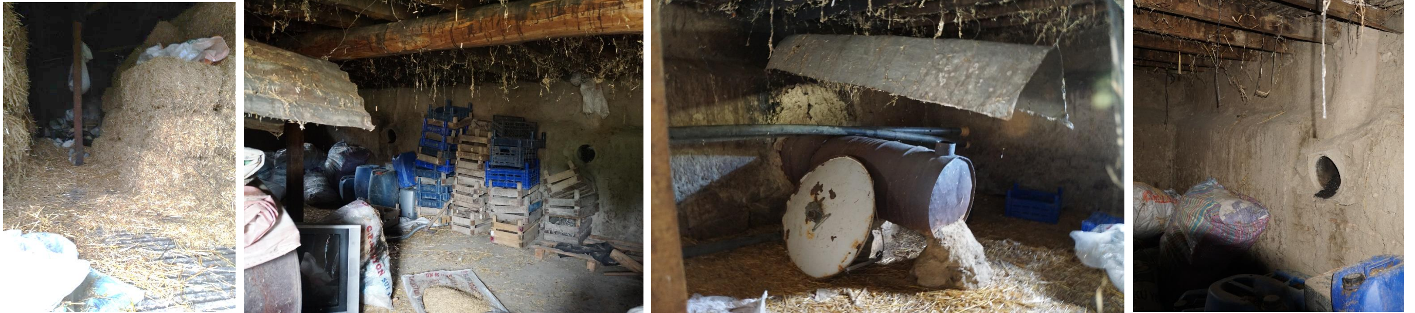
Soldan sağa sırasıyla; Biber kurutma katı (samanlık olarak kullanılmakta), Fırın katı, fırın katındaki fırın kazanları, fırın katındaki baca çıkış delikleri.
