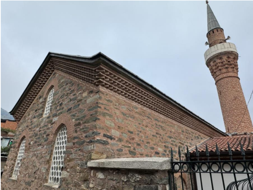
Resim 26. Bursa Molla Fenari Camii Kirpi Saçak Detayı (Yaman, 2024)
