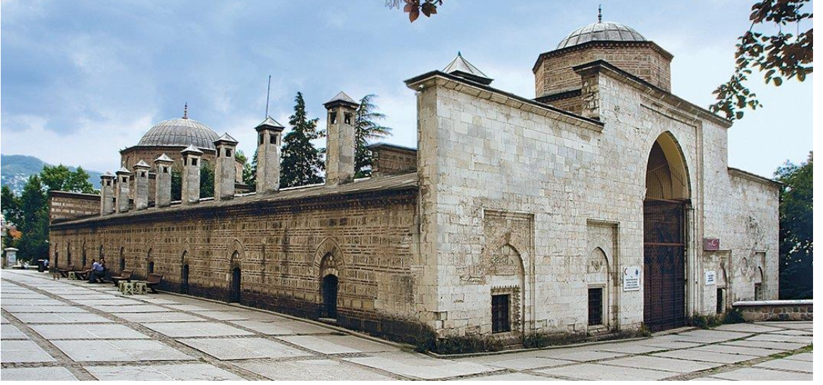
Resim 35. Bursa Yıldırım Medresesi Genel Görünüşü (Bursa Uludağ Üniversitesi, 2022)
