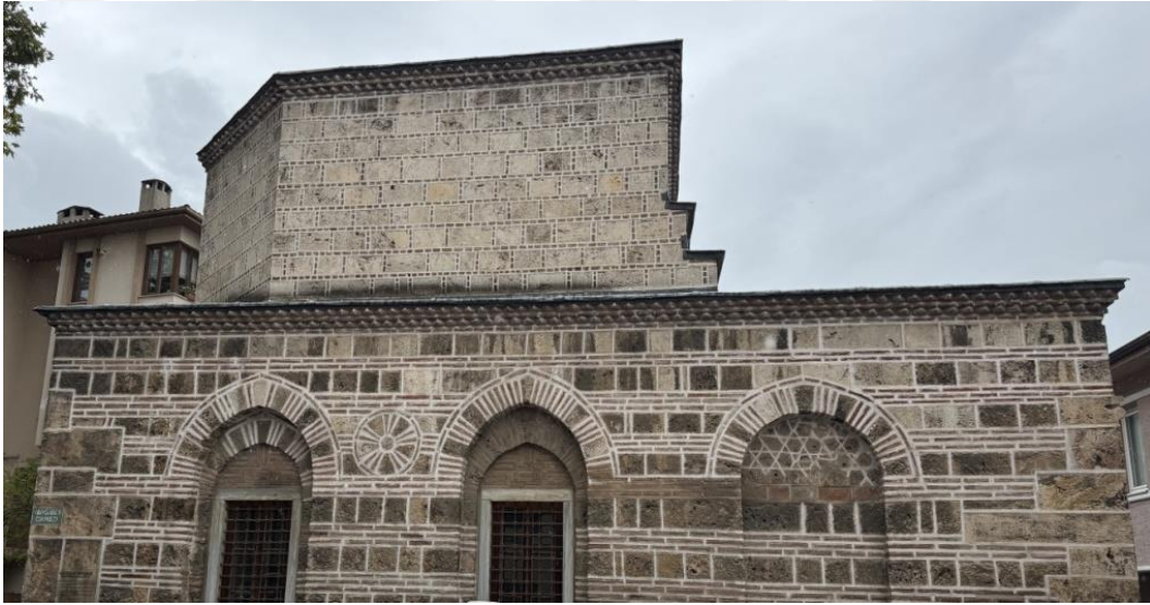
Resim 18. Bursa Gülçiçek Hatun Türbesi Yan Cephe Görünüşü (Yaman, 2024)
