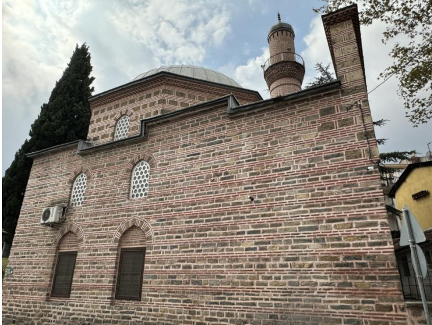
Resim 1. Bursa Bedrettin Camii Almaşık Duvar Örneği (Yaman, 2024)
