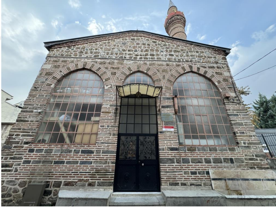
Resim 2. Bursa Arap Mehmet Camii Ön Cephesi (Yaman, 2024)
