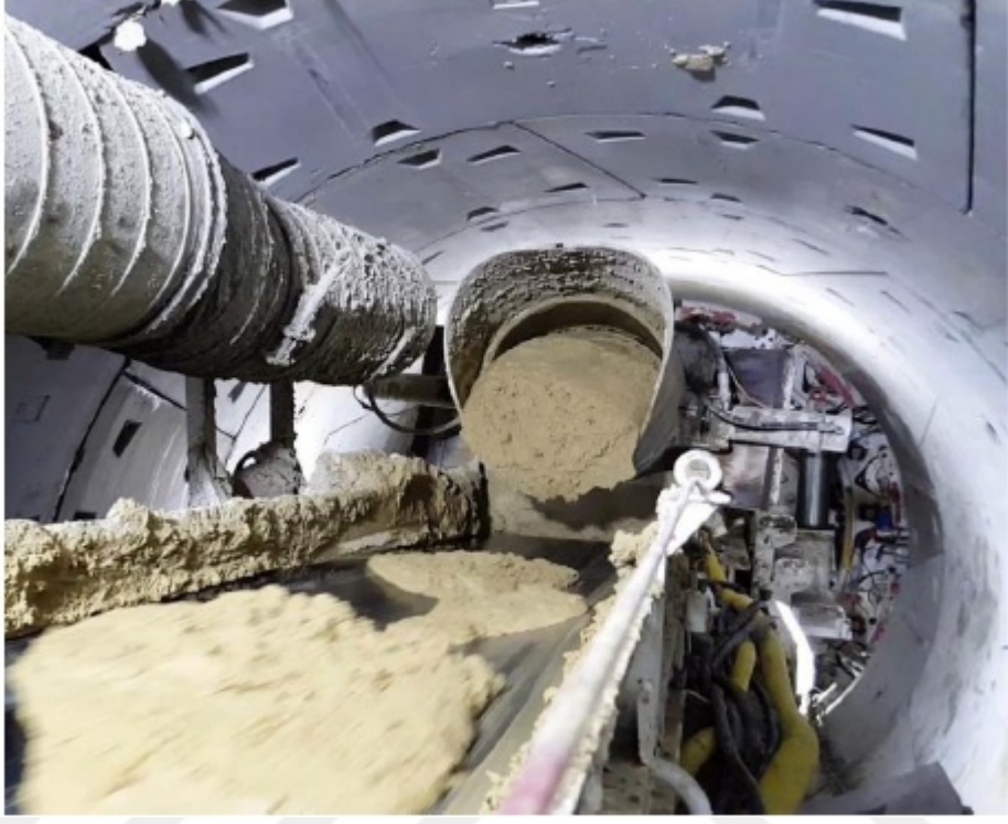
Şekil 5. 8 Çalışma sahasında uygulanmakta olan EPB yöntemi (Avunduk ve Çopur, 2018).
