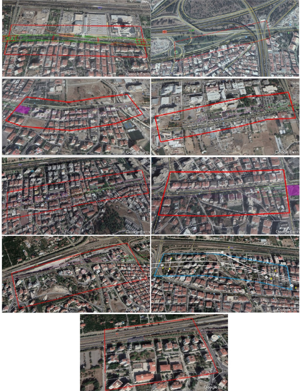
řekil 8. 1 Tnel gzergahı boyunca etki alanına giren yapılar
