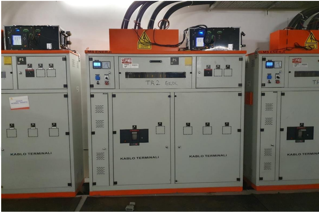
Şekil 3.3. Enerji kalite ölçüm cihazının saha çalışmasında kullanılması (2)
