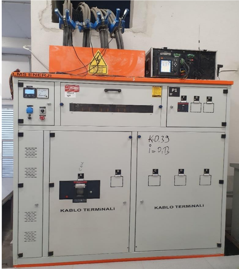
Şekil 3.2. Enerji kalite ölçüm cihazının saha çalışmasında kullanılması (1)
