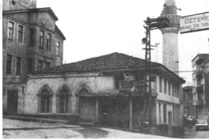
Şekil 32. Gözaçan Cami'sinin yıkılmadan önceki durumu (Karpuz, 1994).
