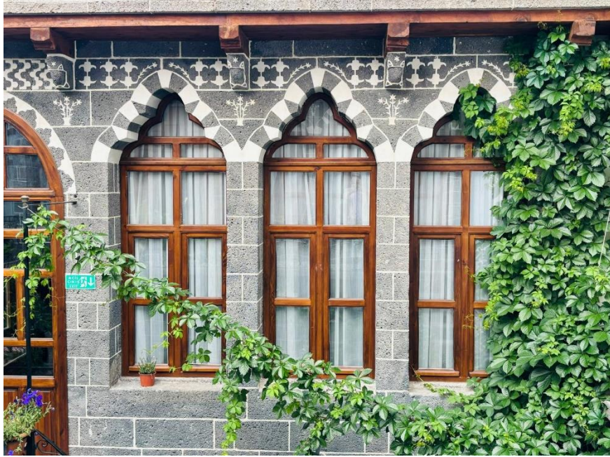
Fotoğraf 287. Konut 28'in Güney Cephedeki pencere süslemeleri
