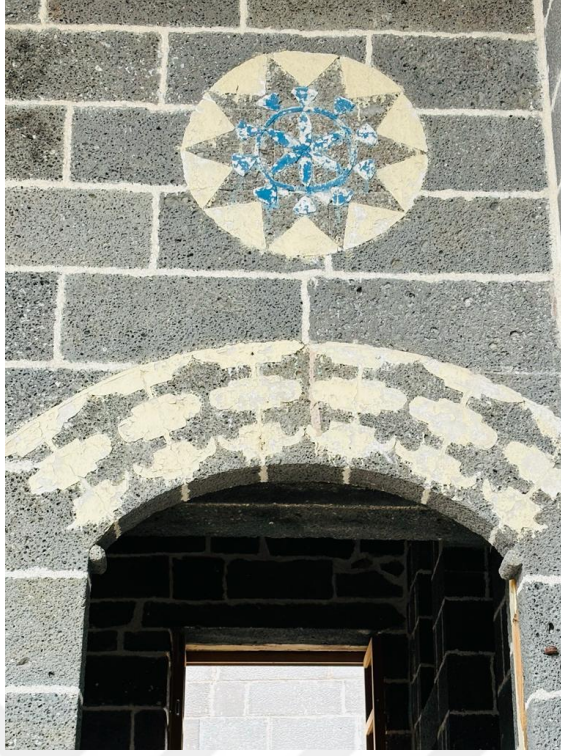
Fotoğraf 83. Konut 11'in Güney Cephesindeki Odanın Basık Kemerli Kapısı
