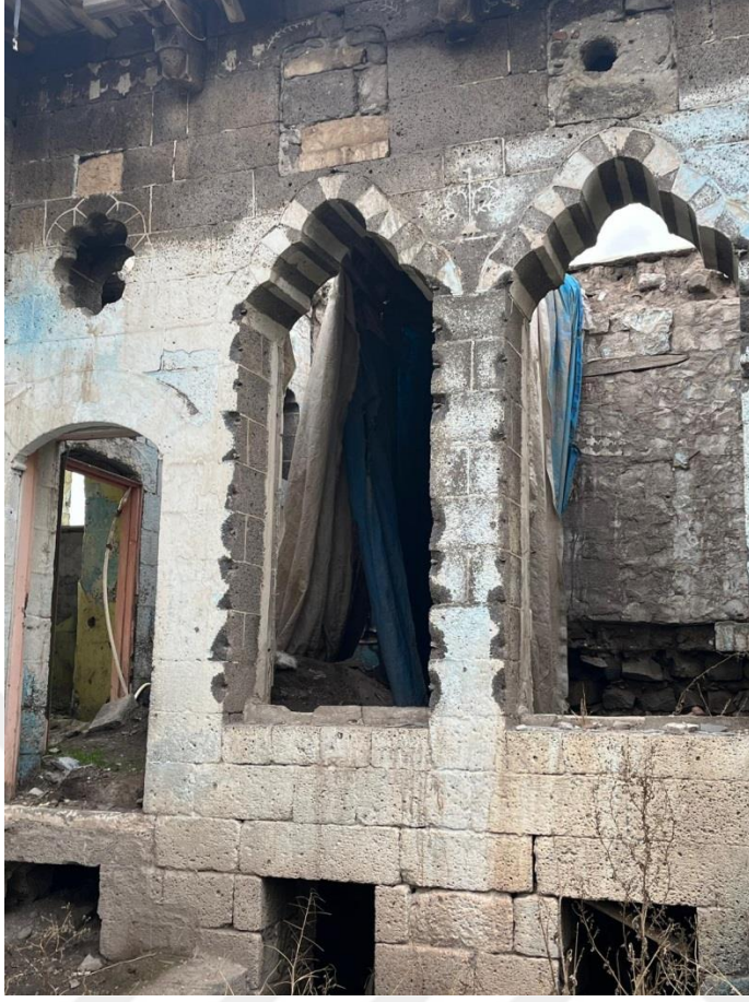
Fotoğraf 136. Konut 16'nın Kuzey cephesindeki Dilimli Pencere Nişleri ve Kapı Detayı
