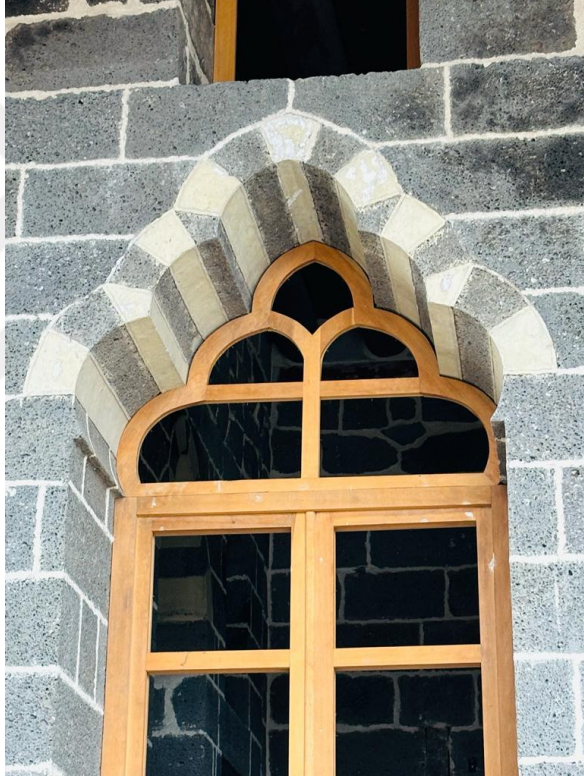
Fotoğraf 82. Konut 11'in Güney Cephesindeki Odanın 5 Dilimli Pencere Nişi
