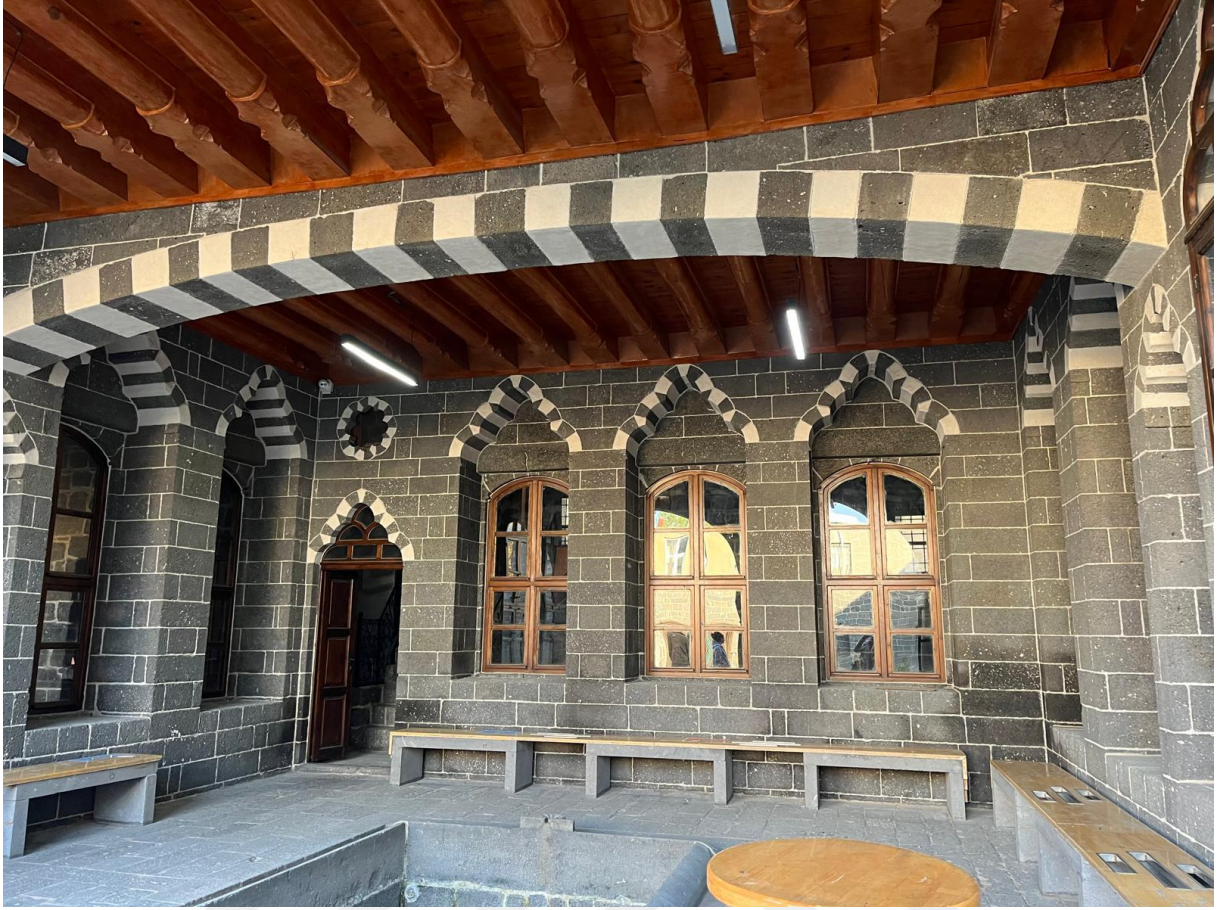
Fotoğraf 183. Konut 21'in Selamlık Bölümündeki Eyvandan Bir Görünüm
