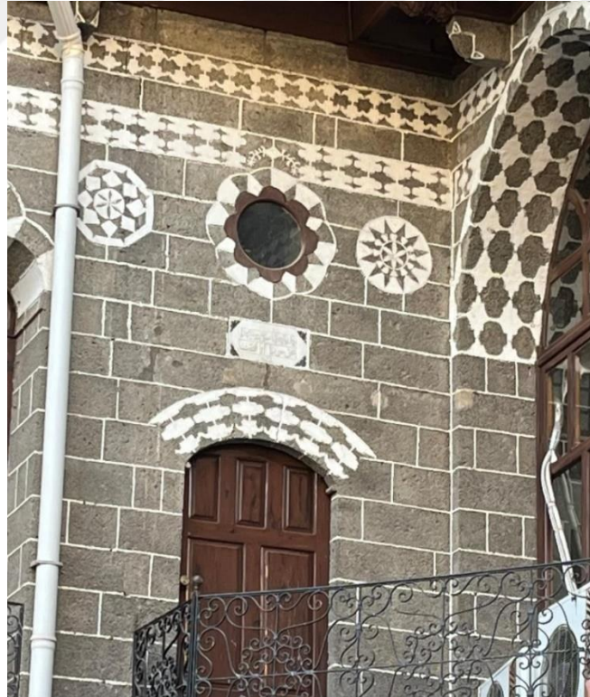
Fotoğraf 303. Konut 29'un Güney Cephesindeki 1. Kattaki Pencere Nişleri ve Batı Cephesiyle Bağlantılı Balkon Saçaklardaki Süslemeler ve 8 Dilimli Yuvarlak Pencere Nişi
