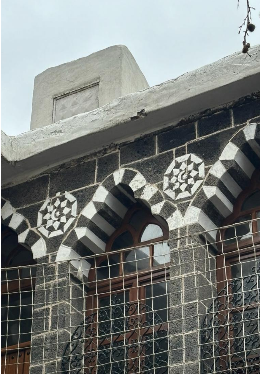
Fotoğraf 164. Konut 19'un Güney Cephesindeki 5 Dilimli Pencere Nişi ve Ay Yıldızlı Rozet Süsleme Detayı 2
