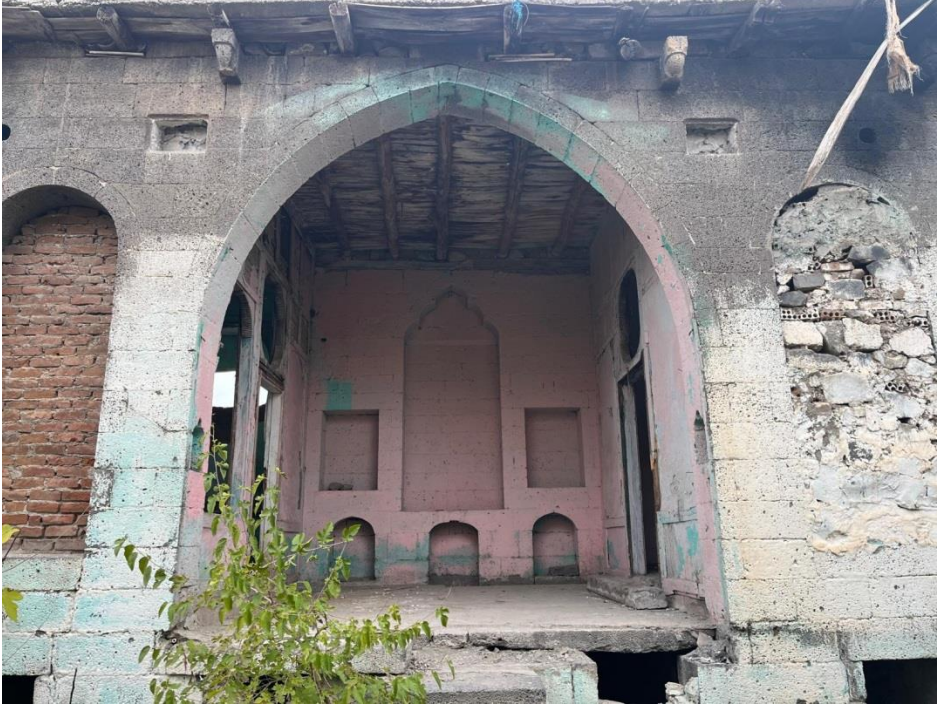
Fotoğraf 135. Konut 16'nın Batı Cephesinden Bir Görünüm
