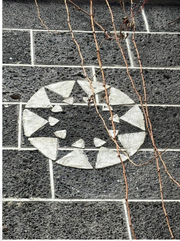
Fotoğraf 359. Konut 34'ün Batı Cephesindeki Sivri Kemerli nişin Duvar Yüzeyindeki Rozet Detayı
