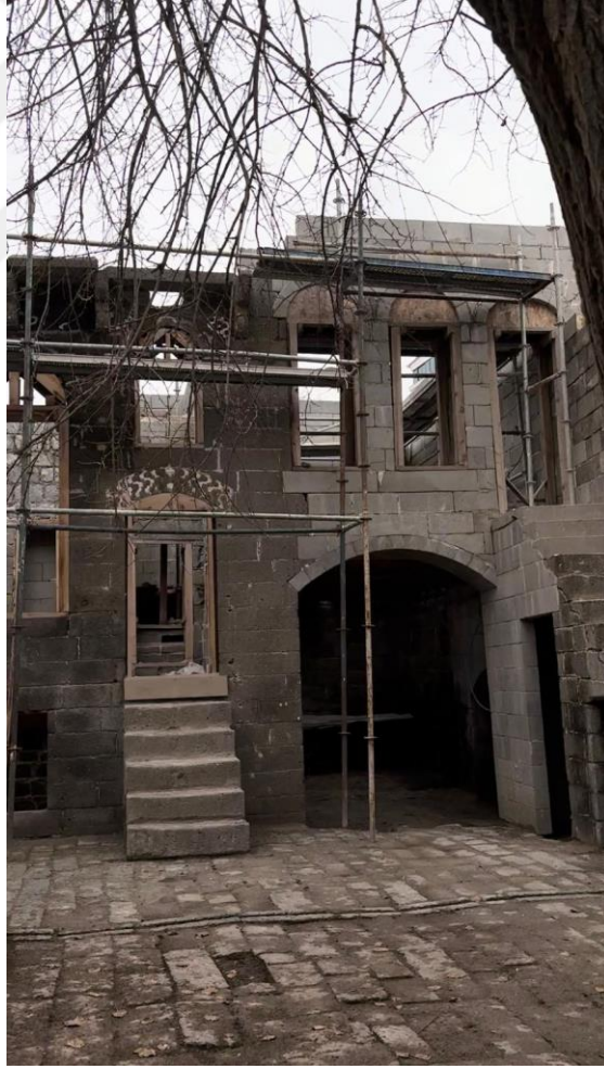
Fotoğraf 342. Konut 33'ün Güney Cephesindeki Oda Kapısı ve Yanındaki Eyvan
