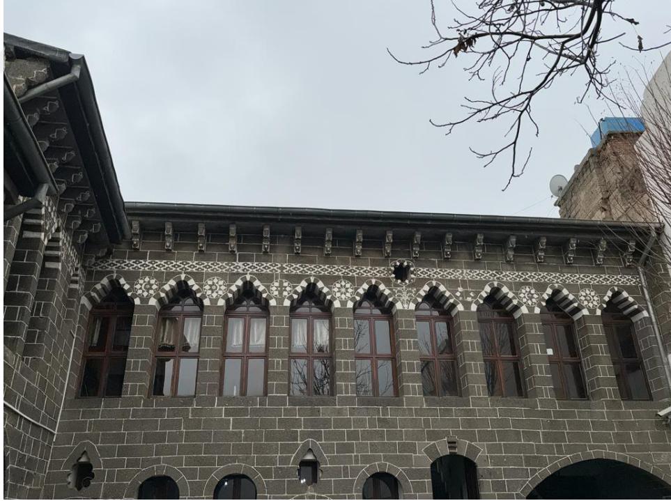
Fotoğraf 151. Konut 18'in Güney Cephesinde 1. Katta Yer Alan Pencere Düzeni
