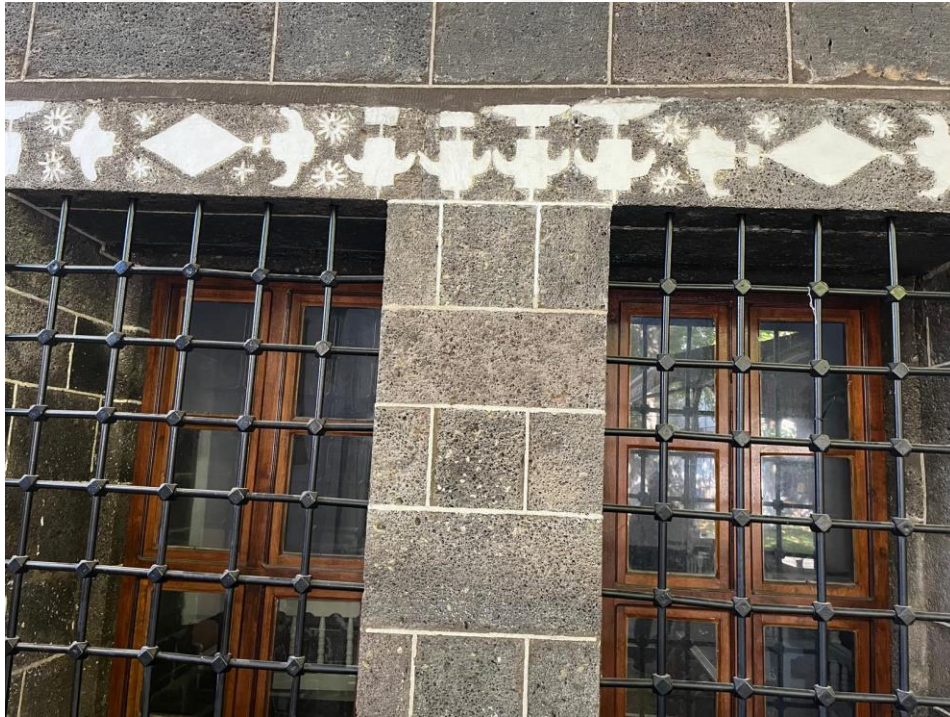
Fotoğraf 274. Konut 27'nin Güney Cephesinde Pencere Üzerinde Palmet, Geometrik Formda Süsleme Detayı
