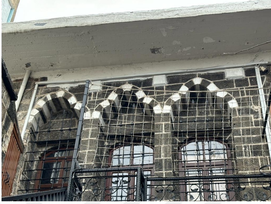
Fotoğraf 162. Konut 19'un Doğu Cephesindeki Pencere Nişleri
