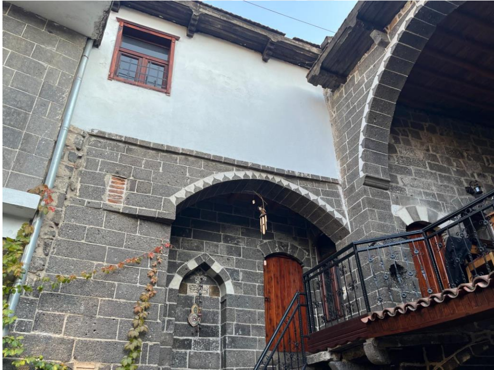
Fotoğraf 317. Konut 30'un Kuzeydeki Üst Kata Geçişi Sağlayan Merdiven ve Batısında Kemer Detayı, Kemer Detayın İçerinde İse Sivri Kemerli Niş Detayı
