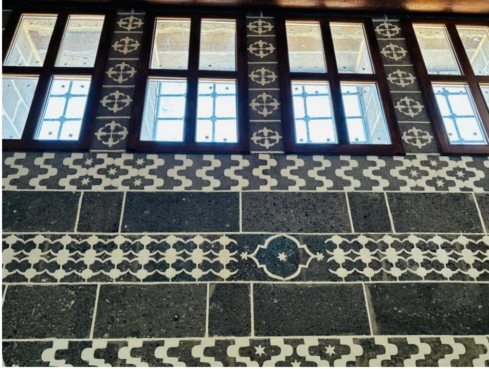
Fotoğraf 174. Konut 20'nin Odanın İç Cephe Duvarında Süsleme Detayları
