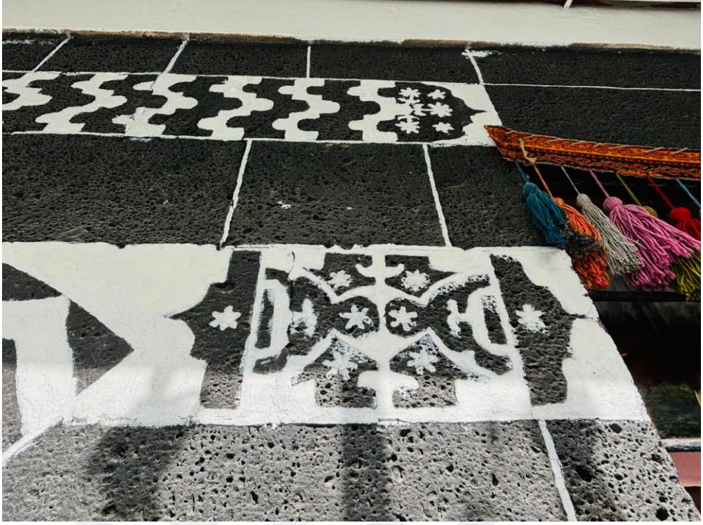
Fotoğraf 324. Konut 31'in Doğu Cephesinde Pencere Duvarındaki S ve C Kıvrımlı Süsleme Detayı
