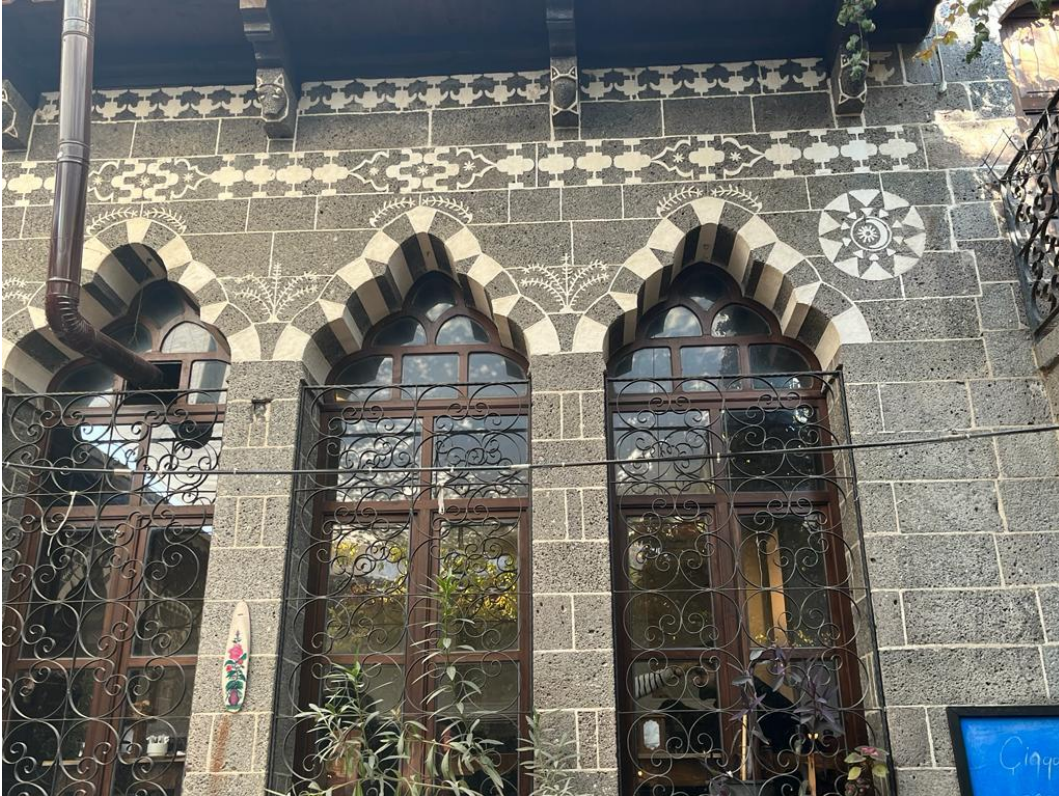
Fotoğraf 112. Konut 14'ün Kuzey Cephesinde Pencere Nişlerinin Görünümü
