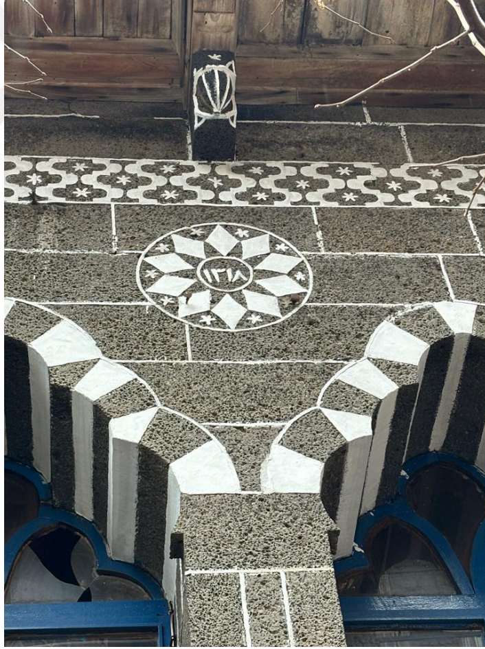
Fotoğraf 263. Konut 26'nın Güney Cephesindeki Tarih Detayı Veren Çiçek ve Geometrik Bezemeli Rozet Süsleme Detayı
