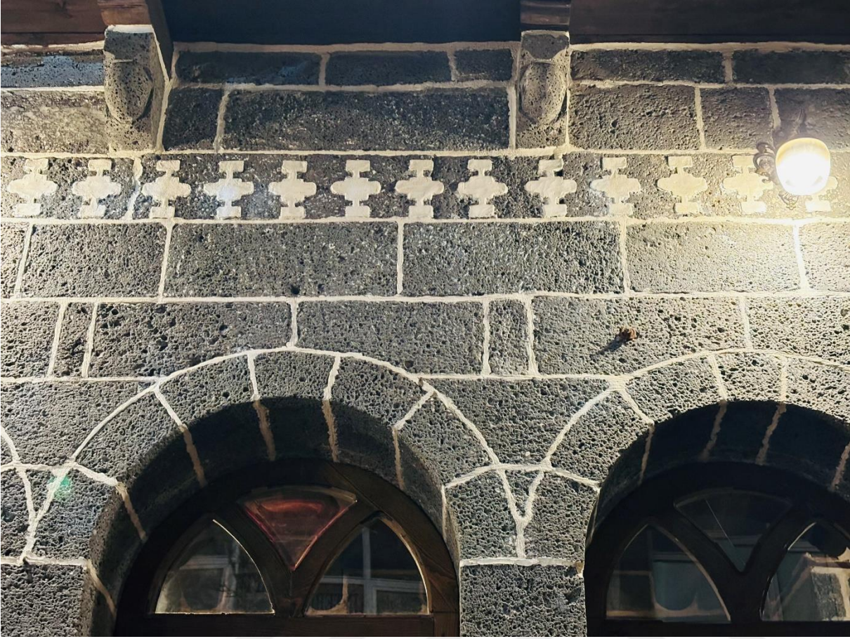
Fotoğraf 230. Konut 23'ün Güney Cephesindeki Yarım Daire Kemerli Pencere Nişleri ve Saçaklarda Haçvari Süsleme Detayı
