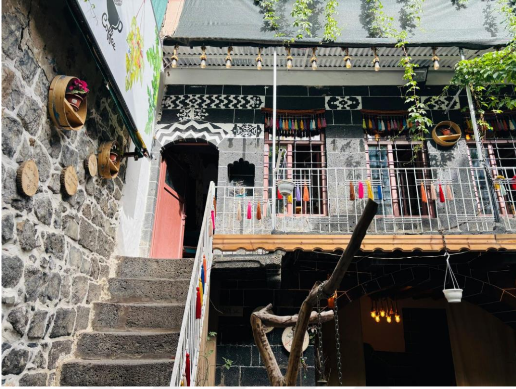
Fotoğraf 320. Konut 31'in Doğu Cephesinden Bir Görünüm
