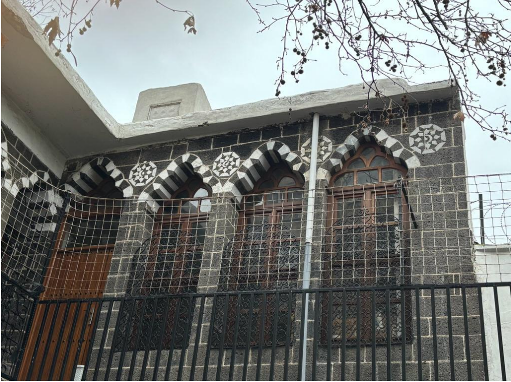
Fotoğraf 161. Konut 19'un Güney Cephesindeki 5 Dilimli Pencere Nişi
