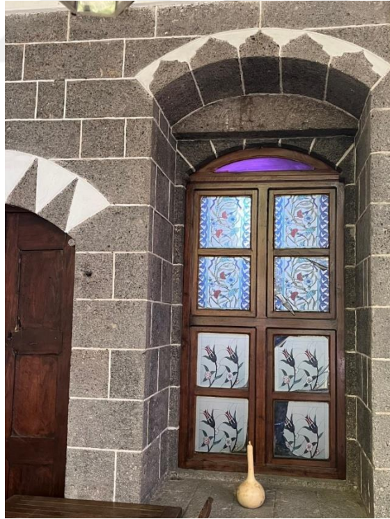
Fotoğraf 281. Konut 27'nin Batı Cephesindeki Eyvanda Yer Alan Batıdaki Başka Bir Odaya Açılan Pencere Detayı
