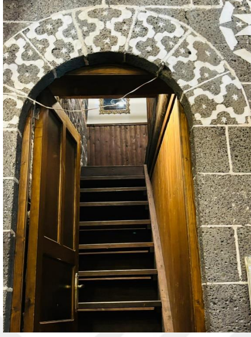
Fotoğraf 218. Konut 23'ün Doğu Cephesinde Yarım Daire Kemerli S ve C Kıvrımlı Süsleme Kapı
