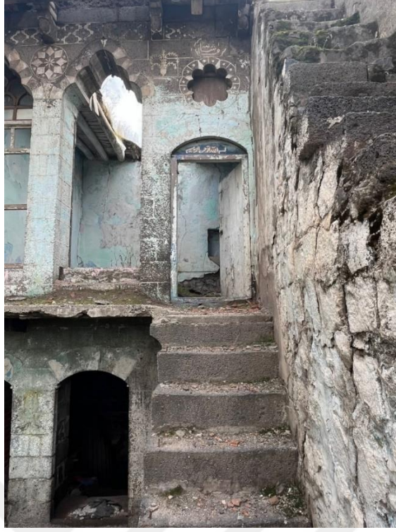
Fotoğraf 253. Konut 25'in Güney Cephesindeki Üst Kata Geçişi Sağlayan Merdiven
