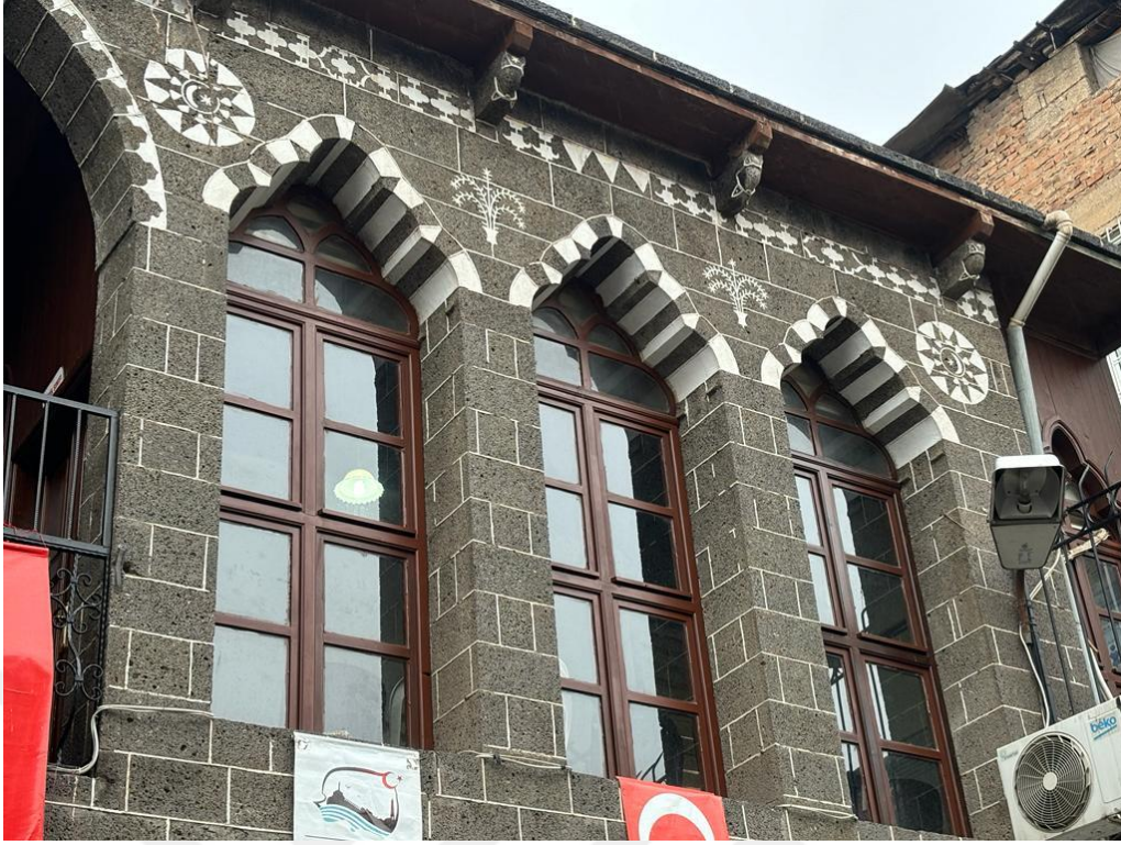
Fotoğraf 240. Konut 24'ün Güneybatısındaki Odanın Pencere Nişleri Detayı
