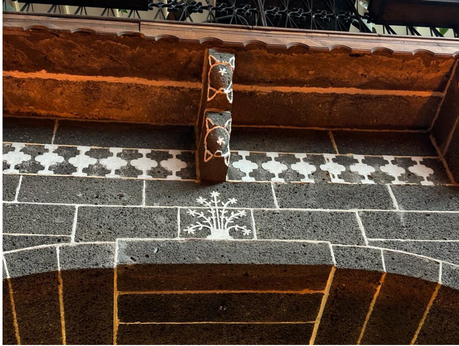
Fotoğraf 86. Konut 12'nin Kuzey Cephesinden Basık Kemerli Eyvan ve Süsleme Detayı
