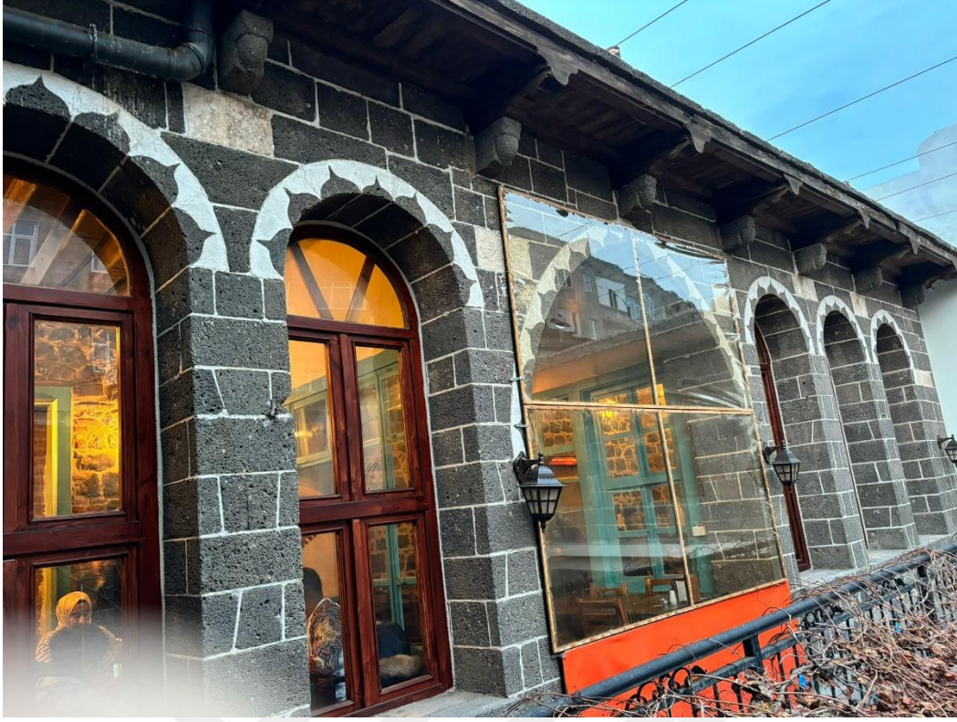
Fotoğraf 313. Konut 30'un Güney Cephesindeki Yarım Yuvarlak, Yarım Şems Bezemeli Pencere Nişleri ve Sivri Kemerli Eyvan Detayı
