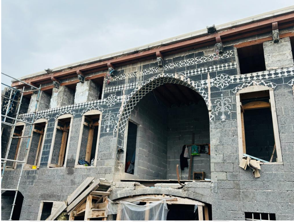
Fotoğraf 43. Konut 7'nin Zemin + 1 Kat planlı Güney Cephesi
