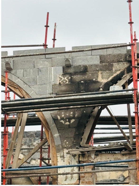
Fotoğraf 130. Konut 15'in Güney Cephesindeki Eyvan Kemer
