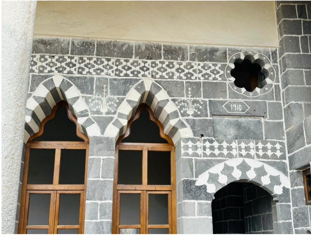
Fotoğraf 142. Konut 17'nin Doğu Cephesinde Eyvanda Geçilen Kapı ve Pencere Nişleri
