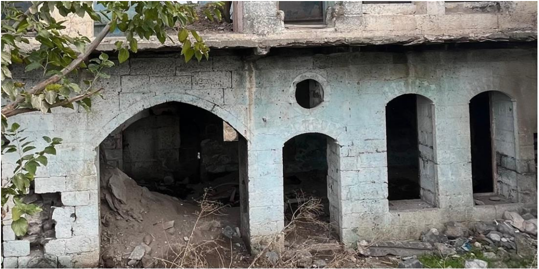
Fotoğraf 252 . Konut 25'in Batı Cephesinin Zemin Kattaki Bölümü
