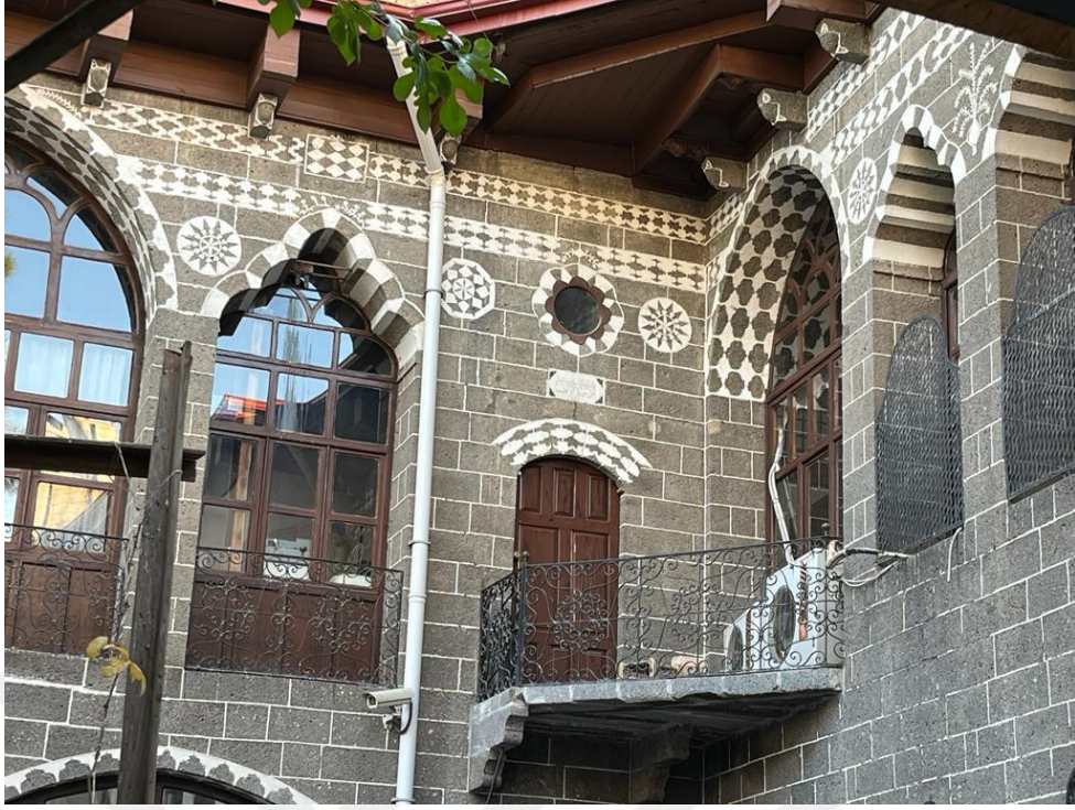
Fotoğraf 302. Konut 29'un Güney Cephesindeki 1. Kattaki Pencere Nişleri ve Batı Cephesiyle Bağlantılı Balkon Detayı
