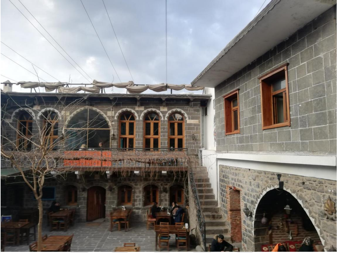
Fotoğraf 311. Konut 30'un Güneydeki Cephesinden Bir Görünüm
