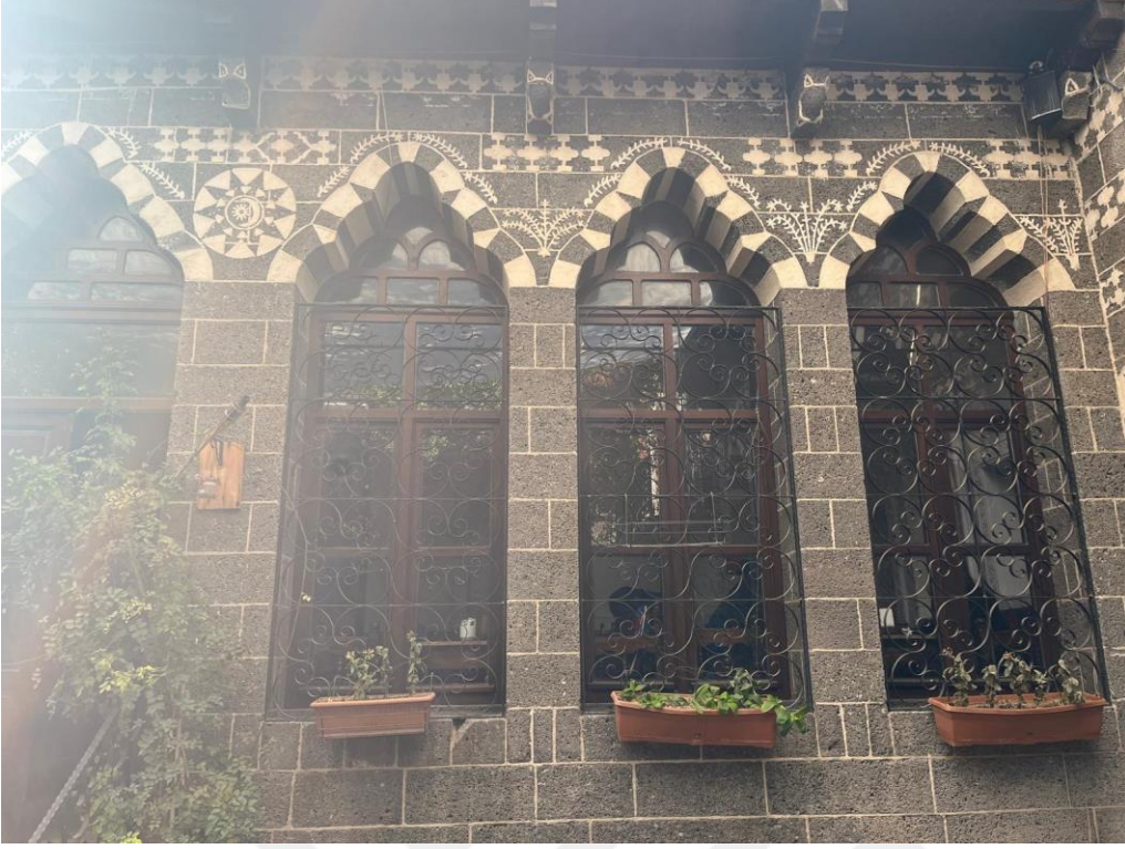
Fotoğraf 111. Konut 14'ün Kuzeybatıda Kalan Odanın Avluya Bakan Pencere Nişleri
