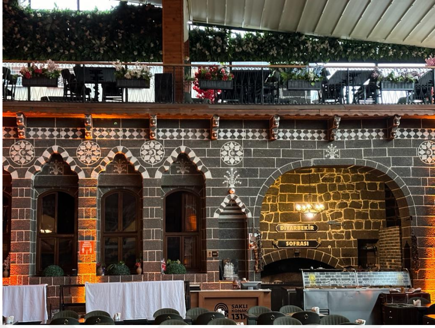
Fotoğraf 85. Konut 12'nin Kuzey Cephesinden Görünüm
