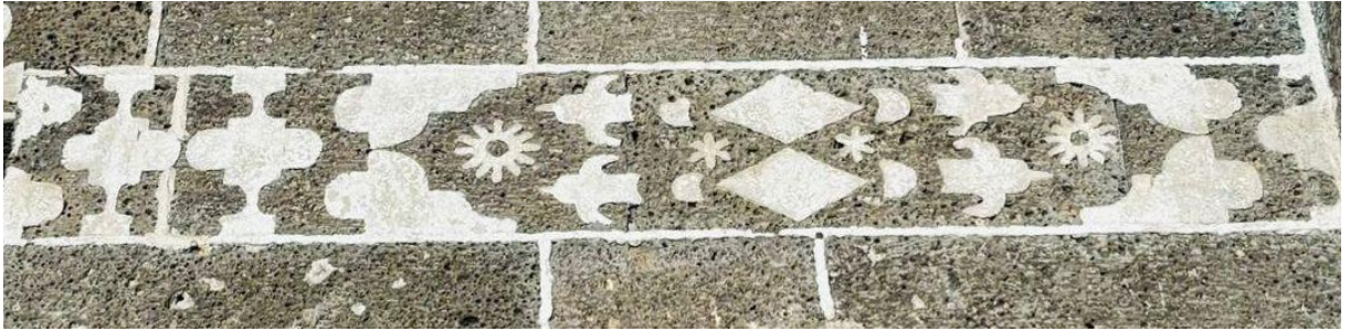
Fotoğraf 211. Konut 22'nin Güneydeki Duvar Yüzeyindeki Geometrik, Çarkıfelek, Yıldız Şemselerin Süsleme Detayı
