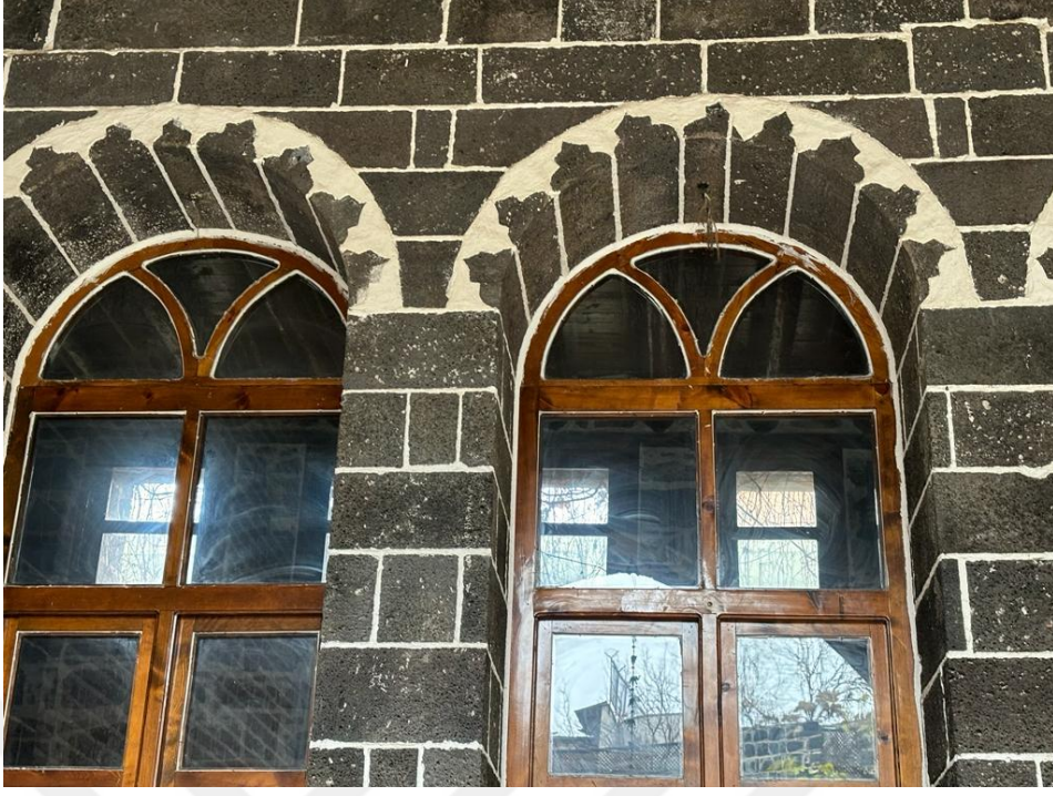
Fotoğraf 338 . Konut 32'nin Güney Cephesinde Yer Alan Yuvarlak Formda Pencere Nişleri
