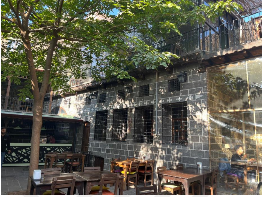
Fotoğraf 352. Konut 34'ün Güney Cephesinden Görünüm
