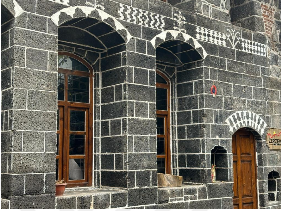
Fotoğraf 332. Konut 32'nin Doğu Cephesindeki Basık Kemerli Pencere Nişleri ve Kapı Detayı
