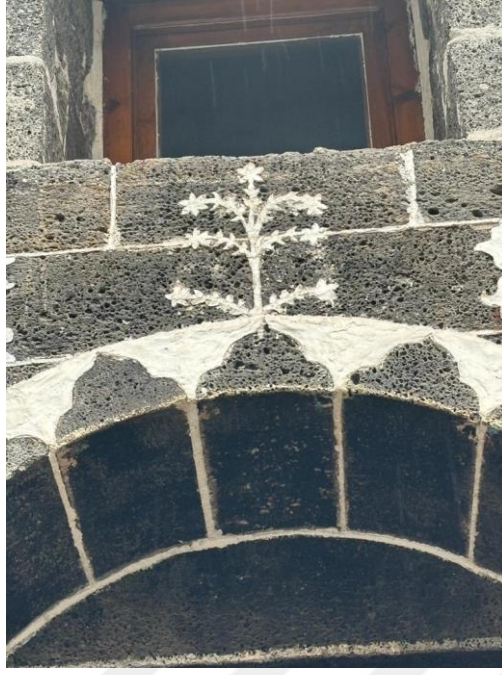
Fotoğraf 334. Konut 32'nin Doğu Cephesindeki Basık Kemerli Pencere Nişi ve Üzerinde Bitkisel Süsleme Motifi
