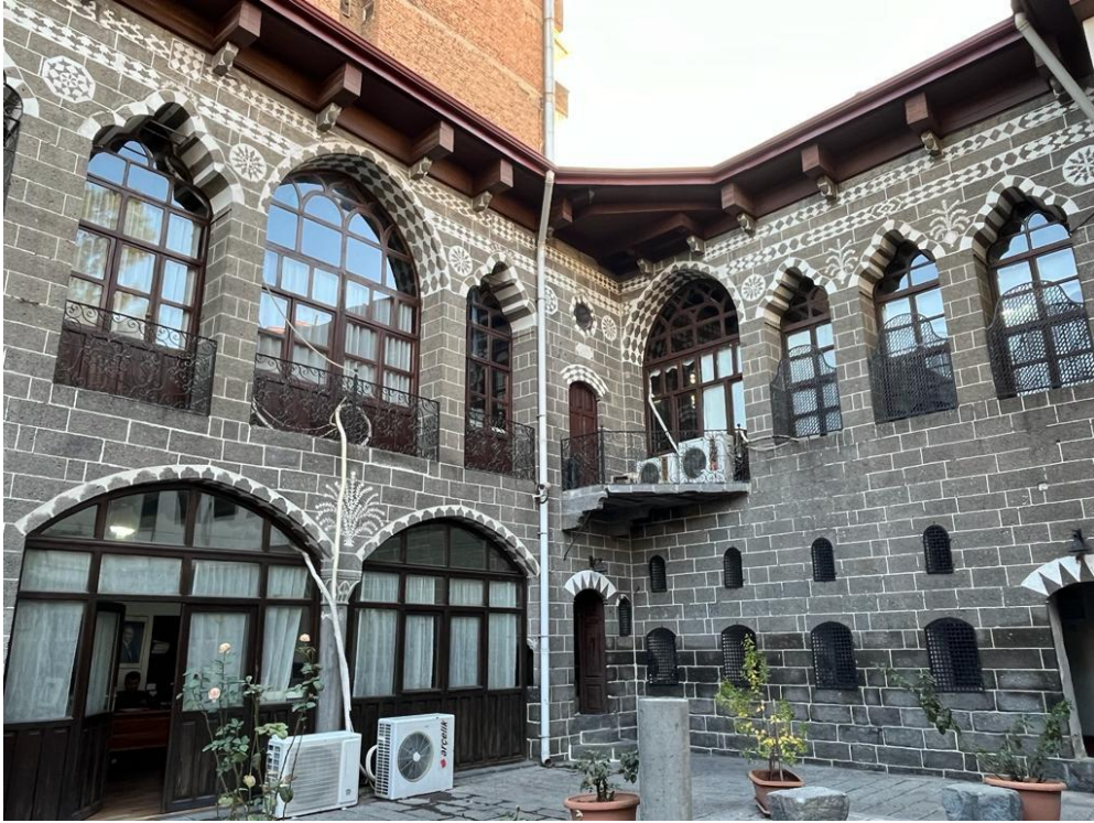
Fotoğraf 298. Konut 29'un Güney Cephesi ve Batı Cephesinden Bir Görünüm
