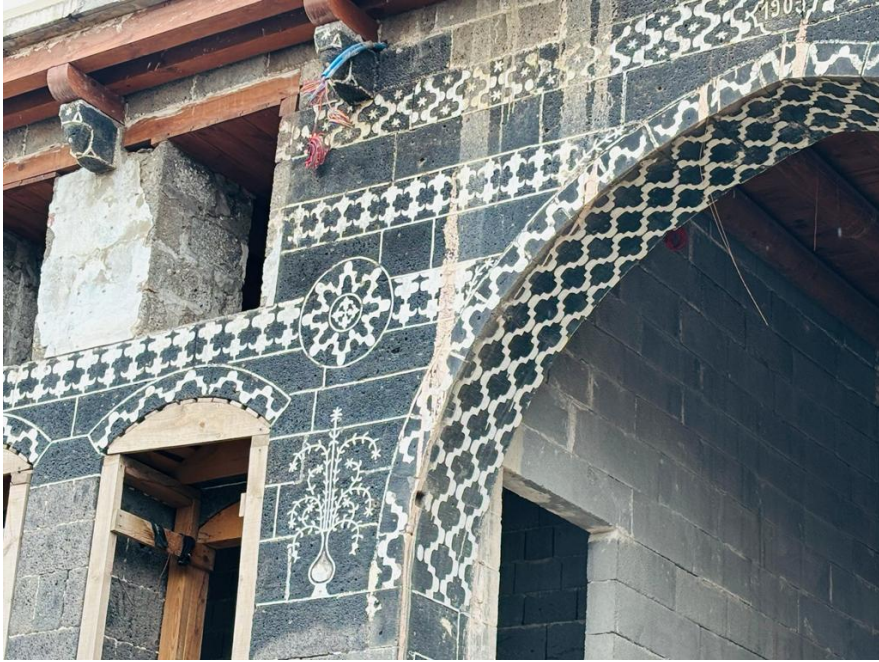
Fotoğraf 46. Konut 7'nin Güney Cephesi Eyvan Kemer Detayı
