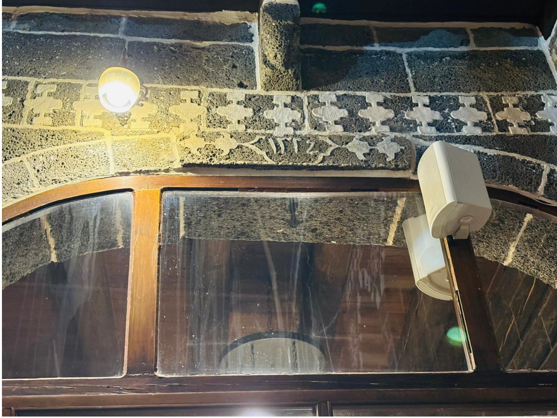
Fotoğraf 229. Konut 23'ün Güney Cephesindeki Eyvan Kapısı ve 1 Üzerindeki Tarih ve Saçaklardaki Haçvari Süsleme Detayı
