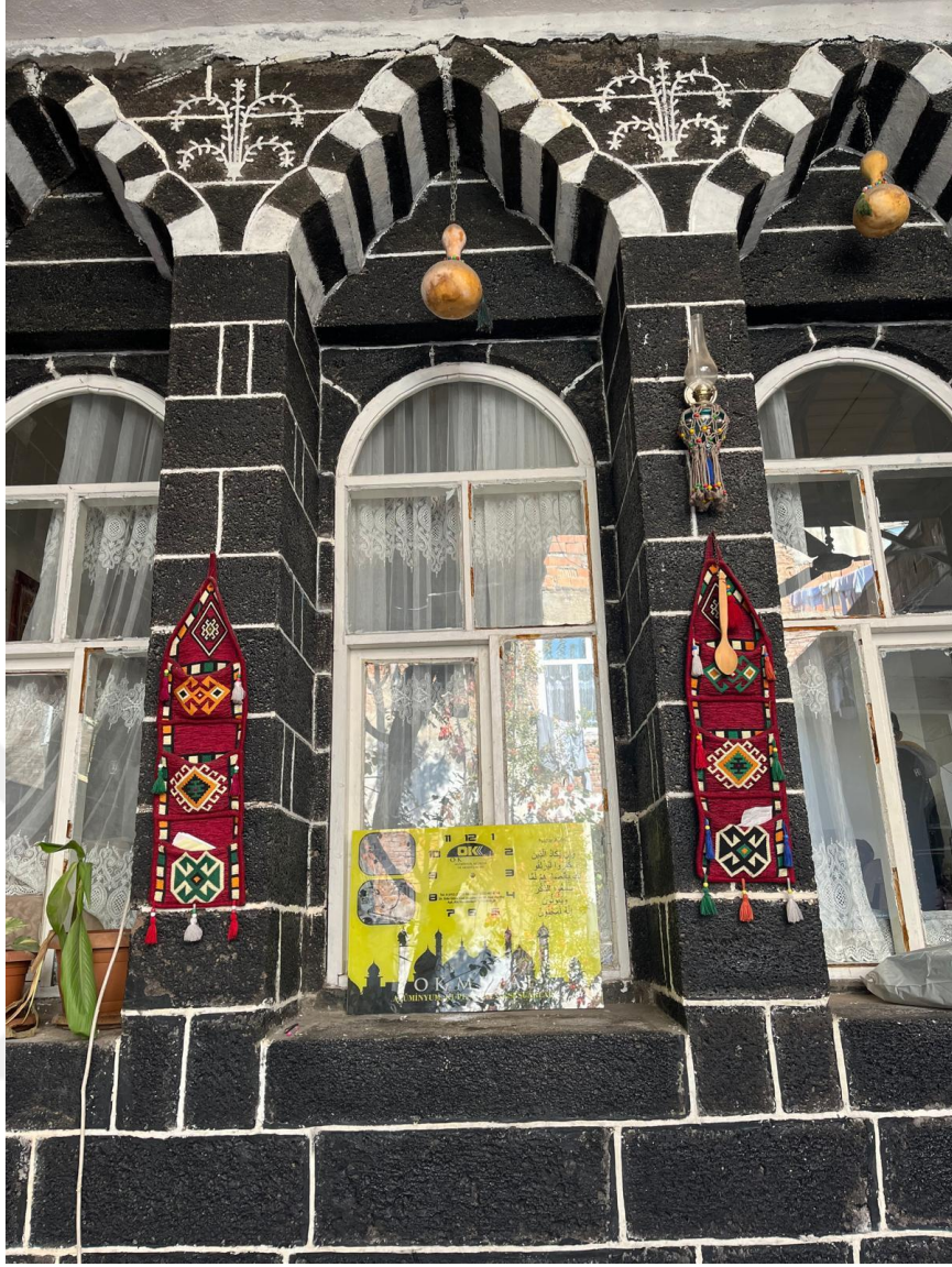
Fotoğraf 42. Konut 6'nın Güney Cephe Duvarındaki 5 Dilimli Pencere Nişleri
