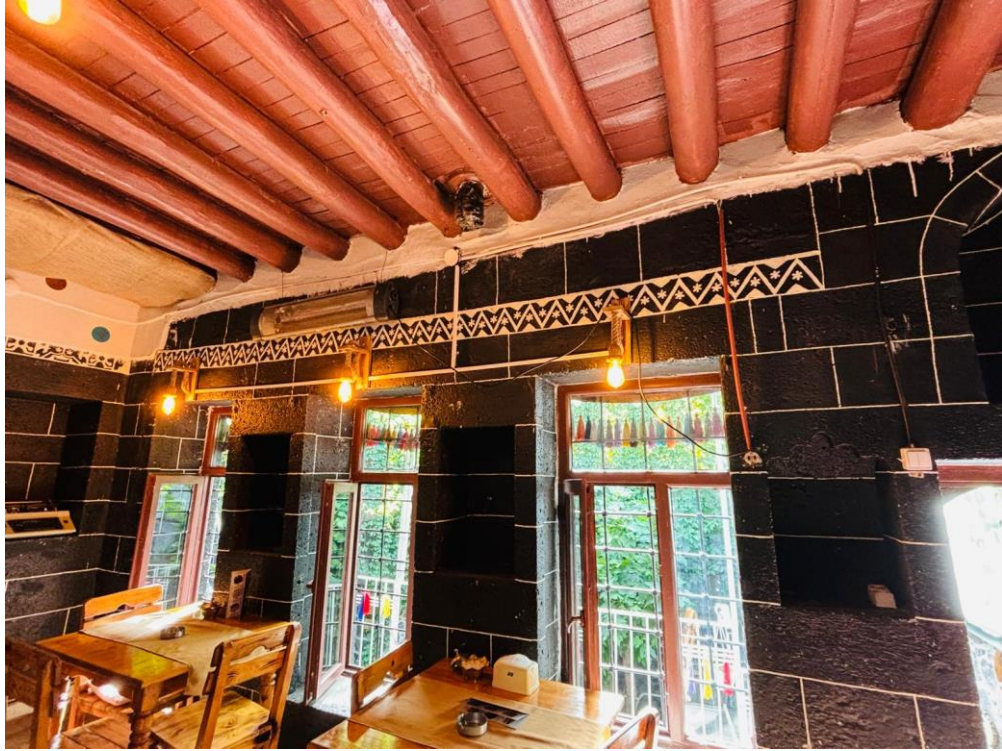
Fotoğraf 326. Konut 31'in Doğu Cephesindeki Oda İçinden Bir Görünüm
