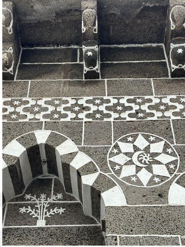
Fotoğraf 155. Konut 18'in Doğu Cephesindeki 5 Dilimli Pencere Nişi, Çarkıfelek, Ay Yıldızlı Rozet Süsleme, S ve C Kıvrımlı Süsleme Detayı
