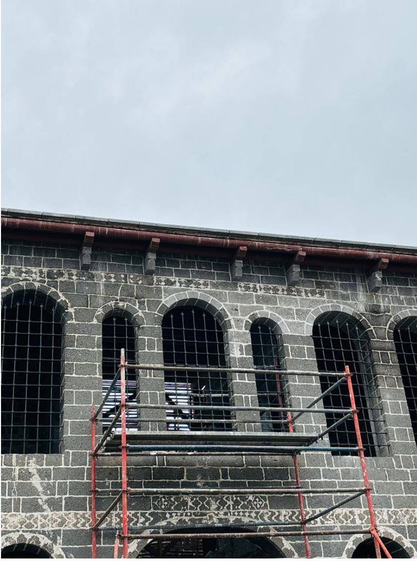
Fotoğraf 126. Konut 15'in Kuzeydeki Avluya Bakan Cephesi
