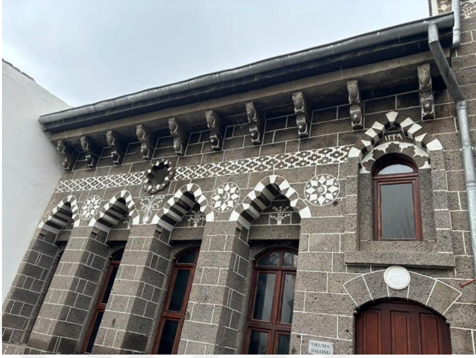
Fotoğraf 152. Konut 18'in Doğu Cephesindeki Odanın Kapı ve Pencere Nişleri Detayı
