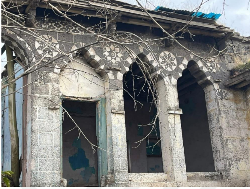
Fotoğraf 250. Konut 25'in Batı Cephesinde Yer Alan Pencere Nişleri ve Süslemeleri
