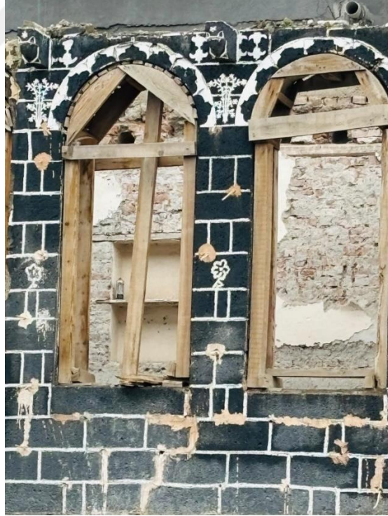
Fotoğraf 74. Konut 10'un Avluya Bakan Cephe Duvarının Pencere Detayı 2
