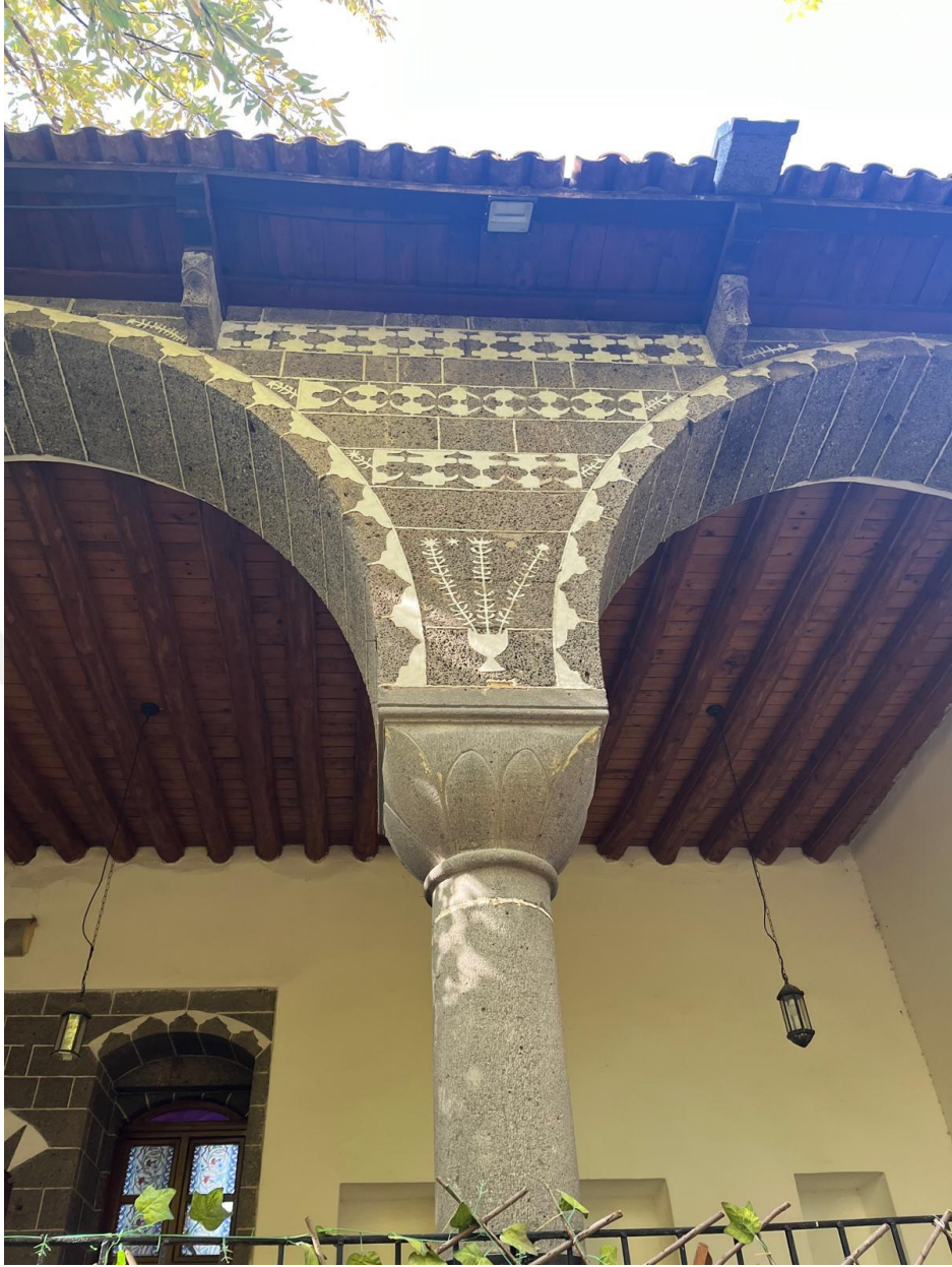
Fotoğraf 275. Konut 27'nin Batı Cephesindeki Eyvan Kemerinin Detayı
