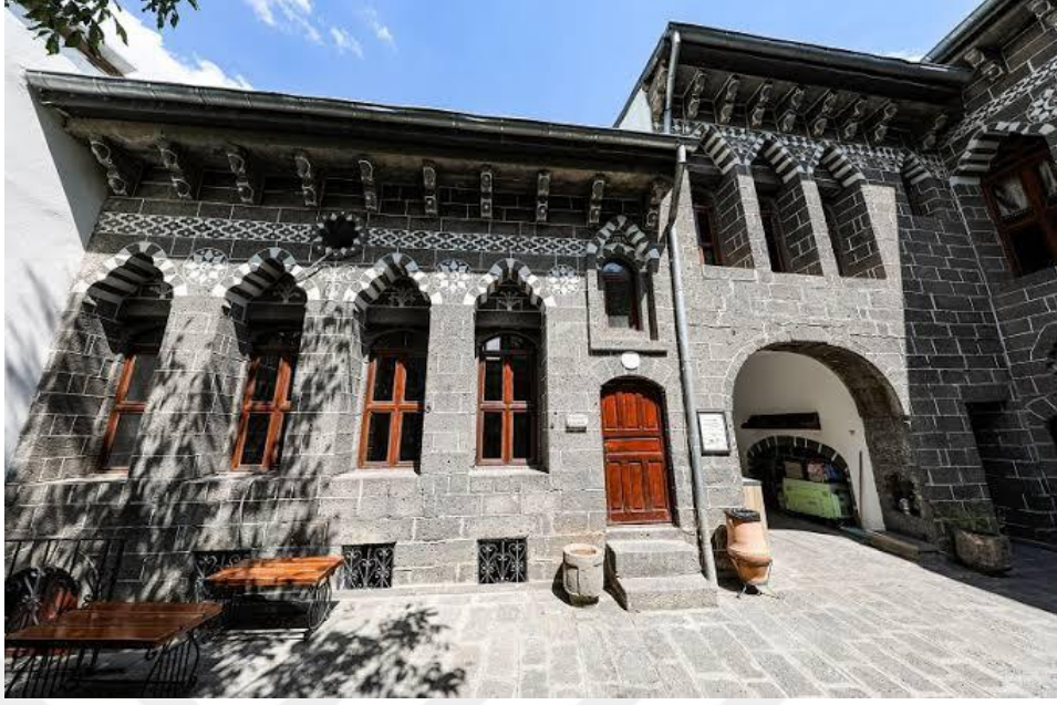
Fotoğraf 150. Konut 18'in Doğu Cephesinden Bir Görünüm
