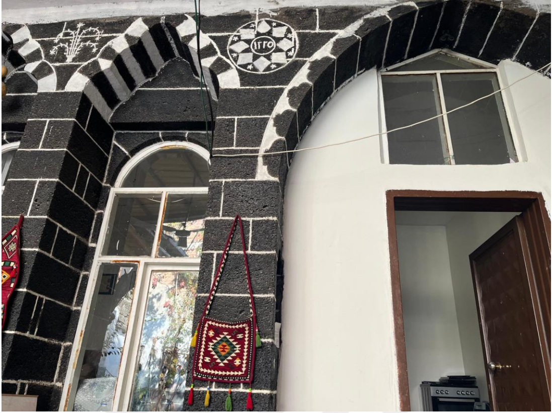
Fotoğraf 38. Konut 6'nın Güney Cephesinden Kapı ve Pencere Nişinden Bir Detay
