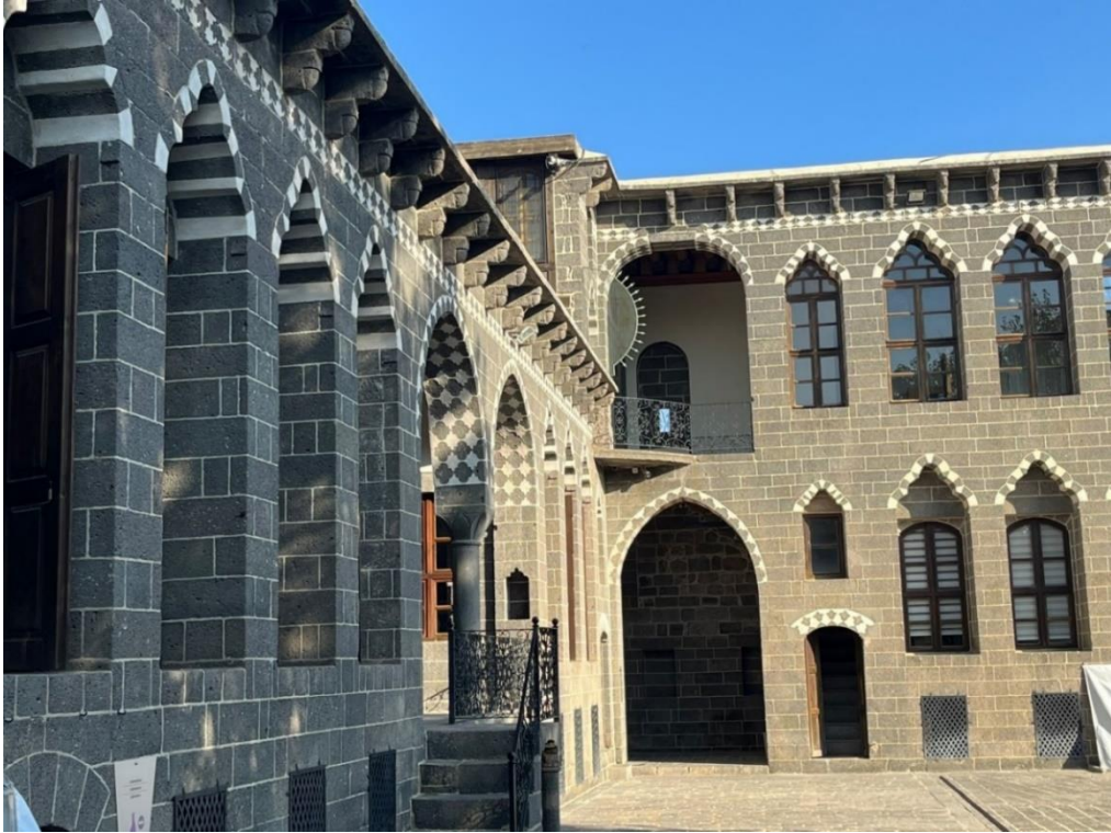
Fotoğraf 190. Konut 21'in Haremlik Bölümünden Doğu ve Kuzey Cepheden Bir Görünüm
