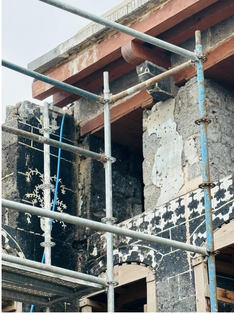
Fotoğraf 49. Konut 7'nin Doğu Cephesi ve Güney Cephesinin Kesiştiği Alan
