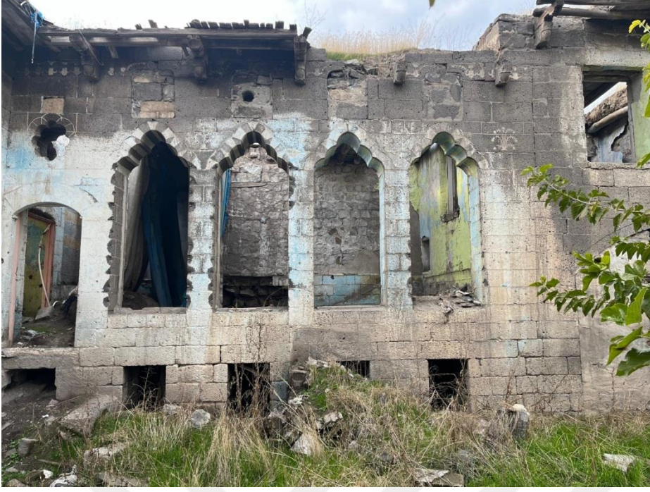
Fotoğraf 134. Konut 16'nın Kuzey Cephesinden Bir Görünüm
