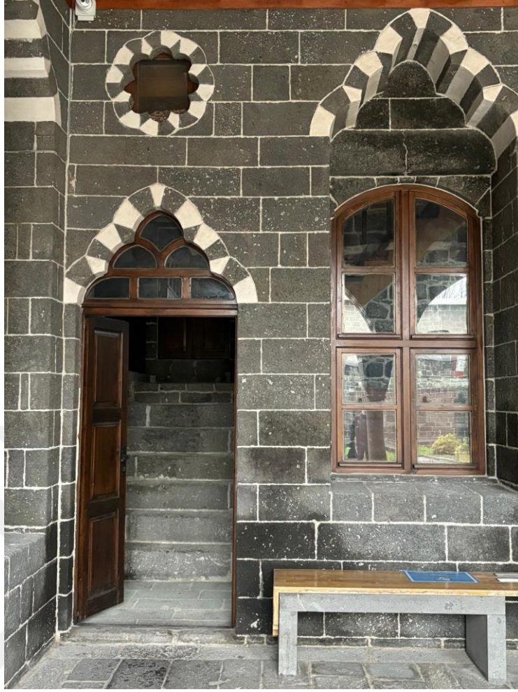
Fotoğraf 184. Konut 21'in Selamlık Bölümündeki Eyvan Üst Kata Geçişi Sağlayan Bölüm
