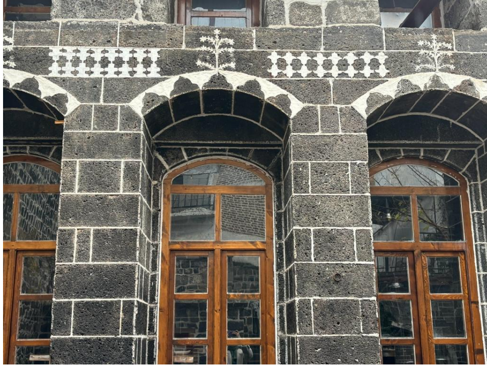
Fotoğraf 331. Konut 32'nin Doğu Cephesindeki Basık Kemerli Pencere Nişleri Üzerinde Çiçek Dalı Süslemeleri ve Haçvari Süsleme Detayı
