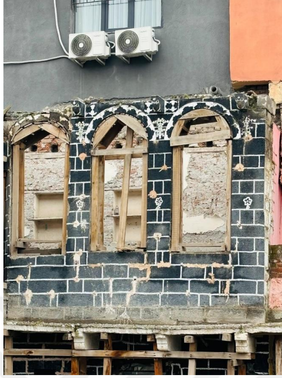
Fotoğraf 73. Konut 10'un Avluya Bakan Cephe Duvarının Pencere Detayı
