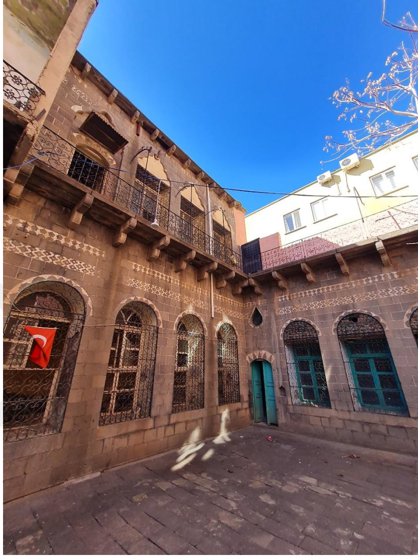
Fotoğraf 378. Siverek'te Cudi Paşa Konağından Kapı ve Pencereden Görünüm (Kaynak Mustafa Topalan)
