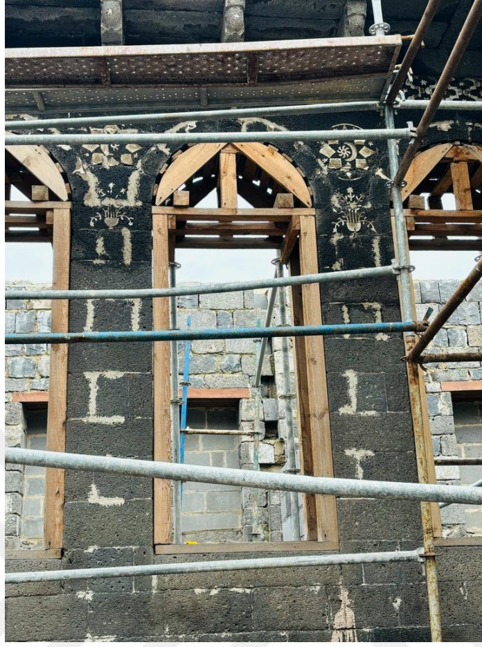
Fotoğraf 347. Konut 33'ün Doğu Cephesindeki Pencere Nişleri ve Arasındaki Süslemeler
