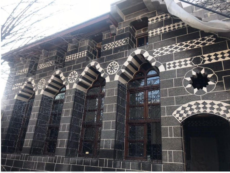
Fotoğraf 167. Konut 20'nin Güneydeki 4 Adet 5 Dilimli Penceresi ve Kapı Detayı
