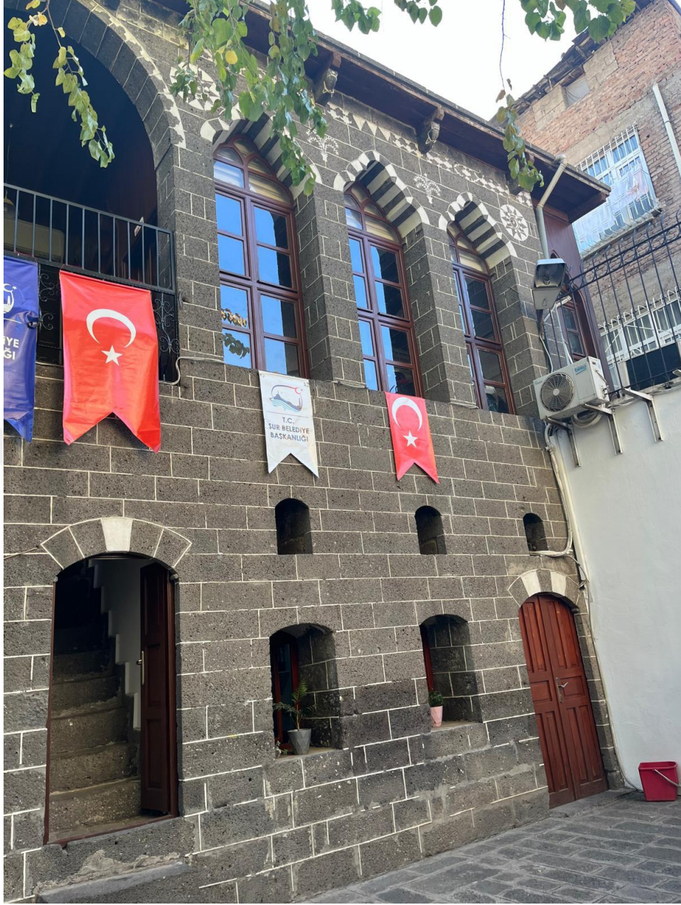
Fotoğraf 235. Konut 24'ün Güneybatının Cephe Duvarında Görünüm
