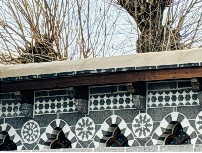
Fotoğraf 23. Konut 3'ün Güney Cephesindeki Pencere Kemer Süsleme Detayı
