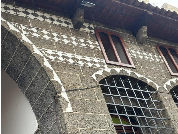
Fotoğraf 279. Konut 27'nin Batı Cephesindeki Yarım Daire Kemerli Pencere Nişi, Saçaklarda Haçvari Süsleme ve Şemse Motifli Süsleme Detayı
