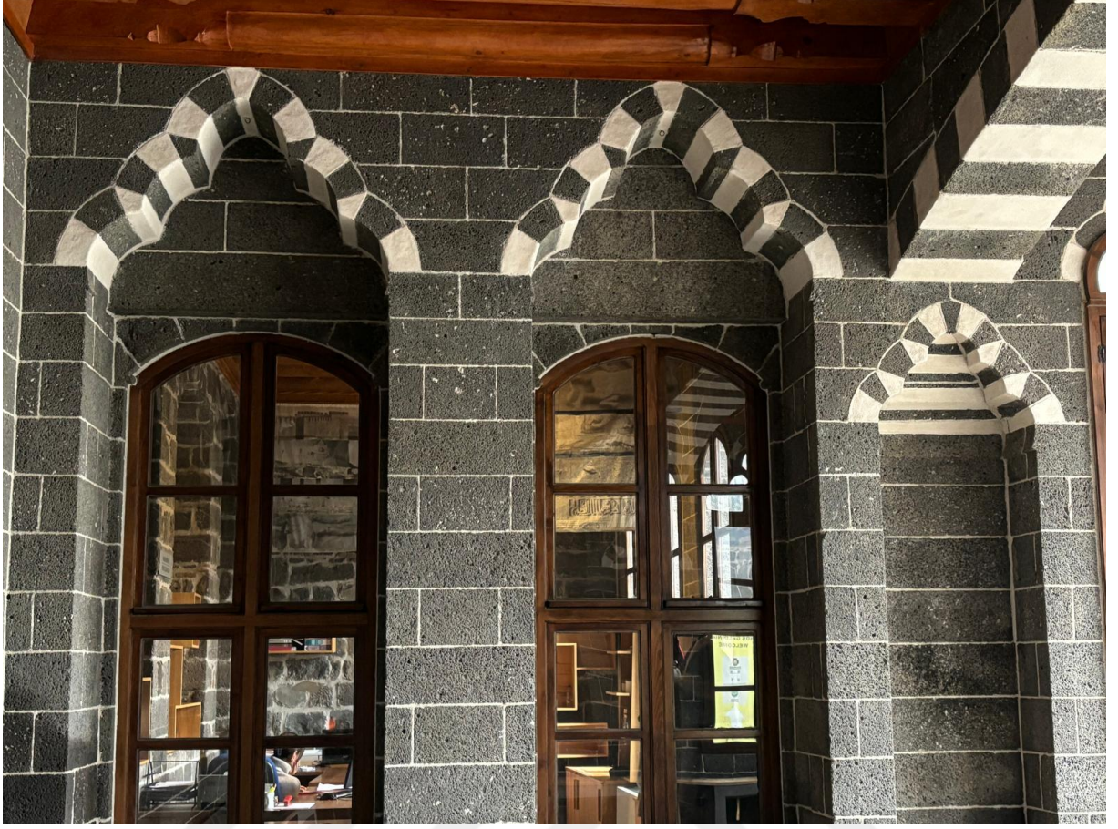
Fotoğraf 185. Konut 21'in Selamlık Bölümündeki Eyvanın Pencere Nişleri ve 5 Dilimli Duvar Nişi Detayı
