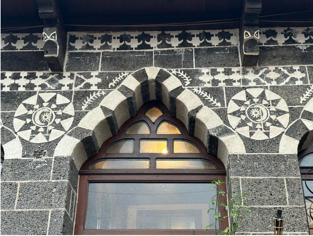
Fotoğraf 117. Konut 14'ün Kuzey Cephesindeki 5 Dilimli Pencere Nişi ve Cas Süsleme Detayı
