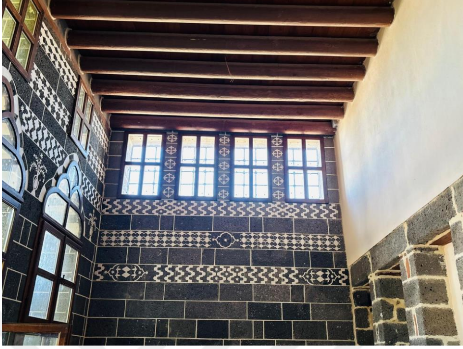
Fotoğraf 173. Konut 20'nin Güney Kanadındaki Odanın İç Cephesi
