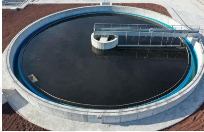
Görsel 2.4. Dengeleme havuzu
