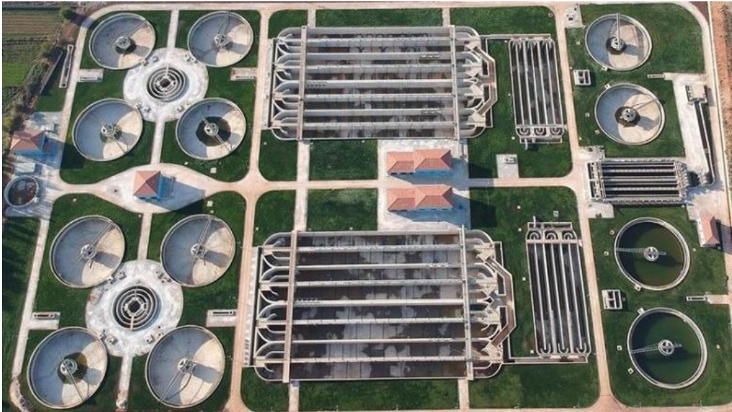
Görsel 1.1. İleri biyolojik atıksu arıtma tesisi
