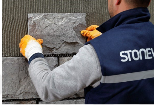
Şekil 2. 13: Doğrudan yüzeye yapıştırma ile kaplamaya örnek [39].
