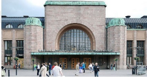
Şekil 2. 7: Helsinki Garı, Finlandiya [28].
