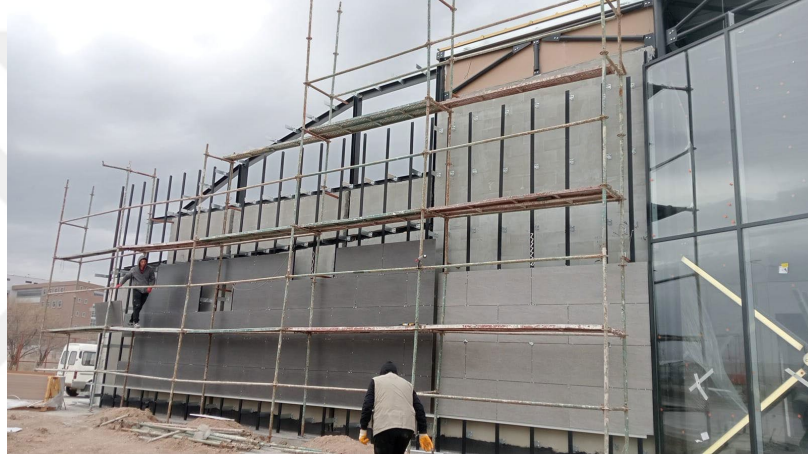
Şekil 3. 4: Braket ve düşey profiller ile seramik montajı [81].
