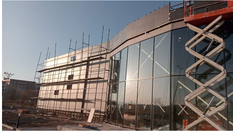
Şekil 3. 5: Havalandırmalı cephe montajı [81].
