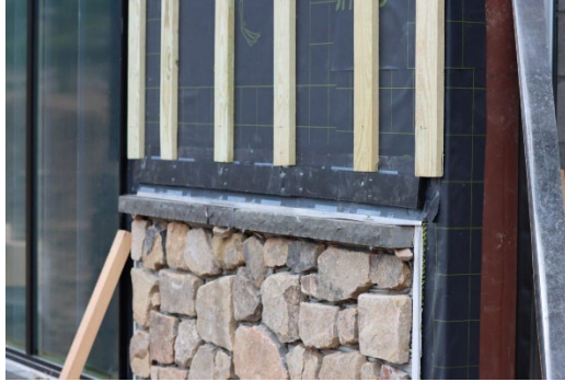
Şekil 2. 14: Ahşap altyapı ile havalandırmalı cepheye örnek [40].
