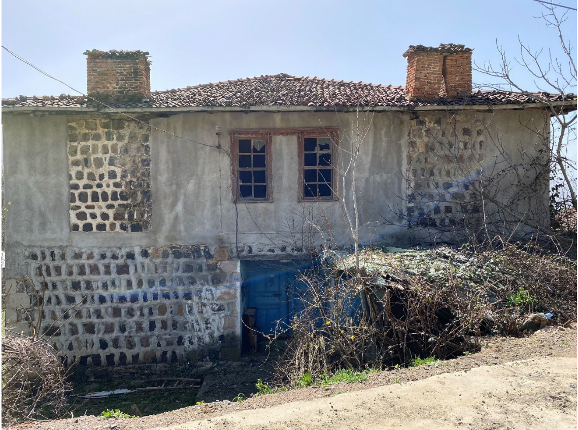
Şekil 4.3. Nüzhetiye Köyü'nde Bulunan Tescilli Yığma Taş Yapı
