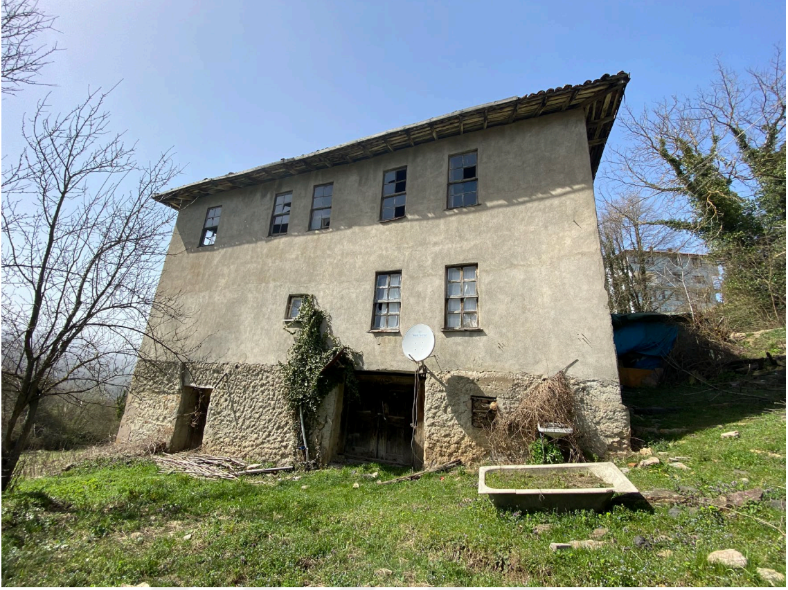
Şekil 6.1. Nüzhetiye Köyü’nde Bulunan Tescilli Yığma Taş Yapı
