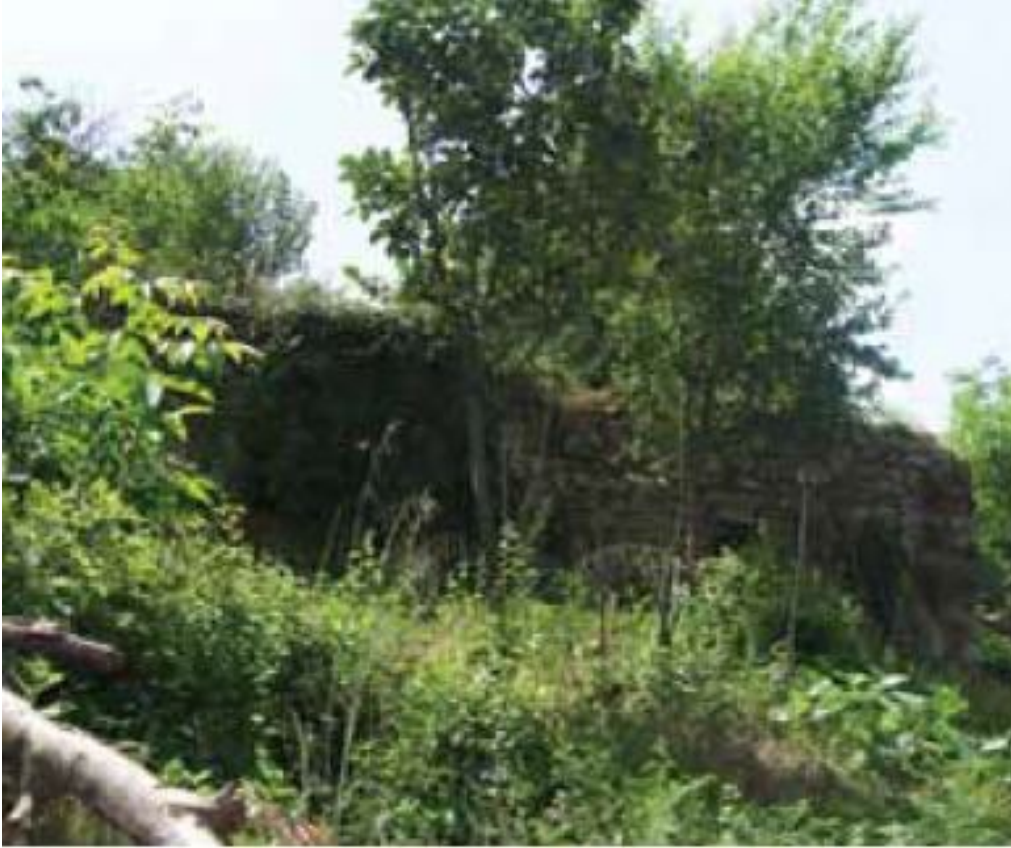
Şekil 6.23. Nüzhetiye Köyü'nde Bulunan Terk Edilmiş Bir Tescilli Yapı, 2013 (Köksal, 2013)
