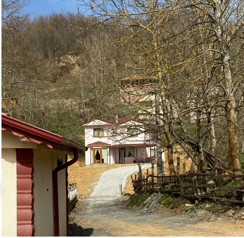
Şekil 6.26. Terk Edilmiş Yapının Yerine İnşa Edilen Yeni Yapı, 2024
