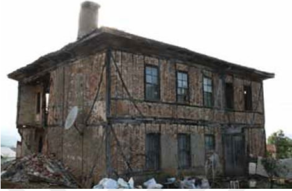
Şekil 6.21. Nüzhetiye Köyü’nde Bulunan Terk Edilmiş Bir Tescilli Yapı, 2013 (Köksal, 2013)
