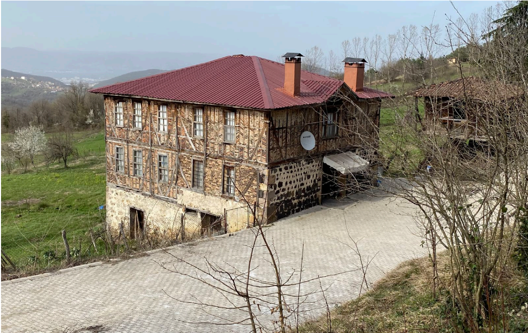
Şekil 6.6. Nüzhetiye Köyü’nde Tescilli Bir Yapı ve Muhdes Çatı Ekleri
