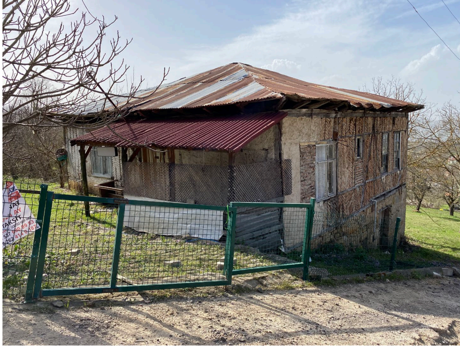
Şekil 6.4. Nüzhetiye Köyü'nde Tescilli Bir Yapı ve Muhdes Çatı Ekleri
