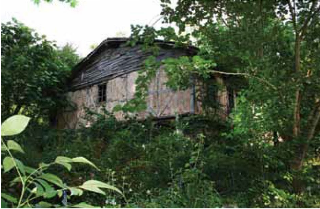
Şekil 6.25. Nüzhetiye Köyü’nde Bulunan Terk Edilmiş Bir Tescilli Yapı, 2013 (Köksal, 2013)
