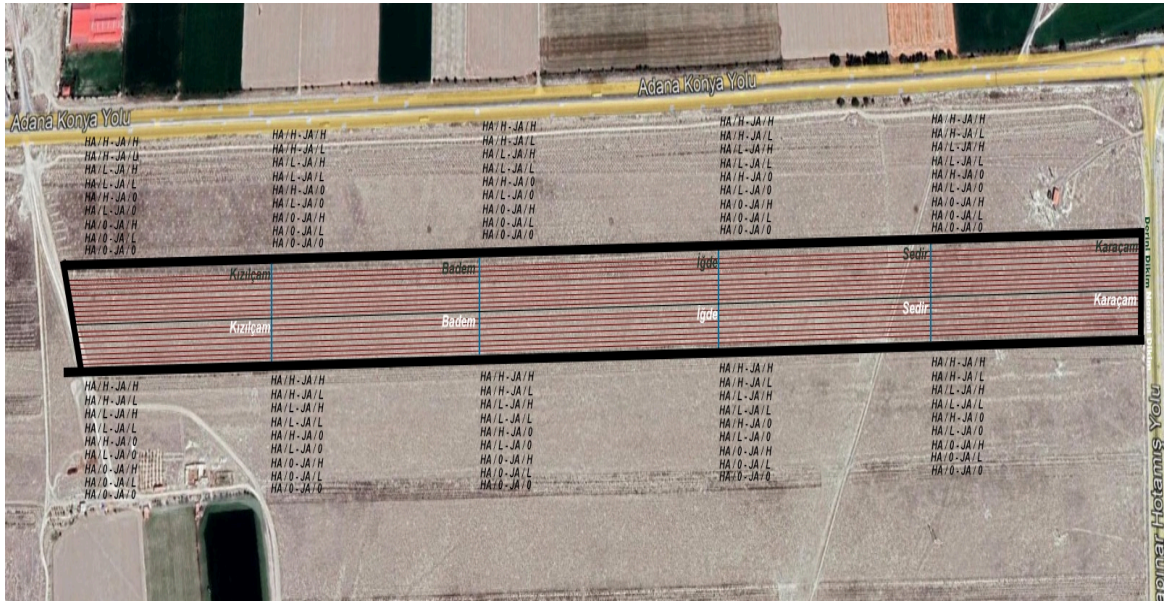
Şekil 2.7. Karapınar sahası işlem üniteleri.
