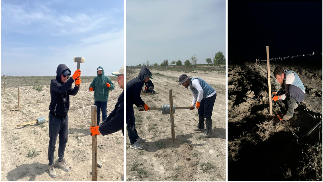
Şekil 2.6. Tel kazıklarının çakılması, tel çekimi ve tel gergi kontrolü.
