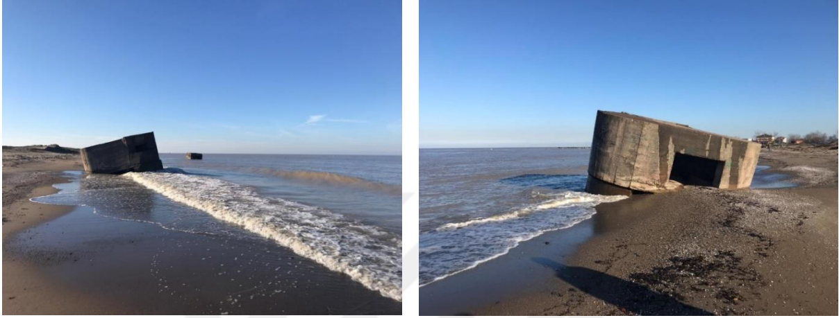
Şekil 1.4 Erozyon sonucu 2. Dünya savaşında askeri savunma amaçlı yapılan koruganlar.
