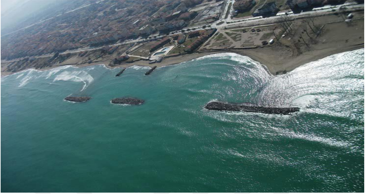
Şekil 1.9 Liman yakınındaki mahmuzlar ve erozyon durumu.
