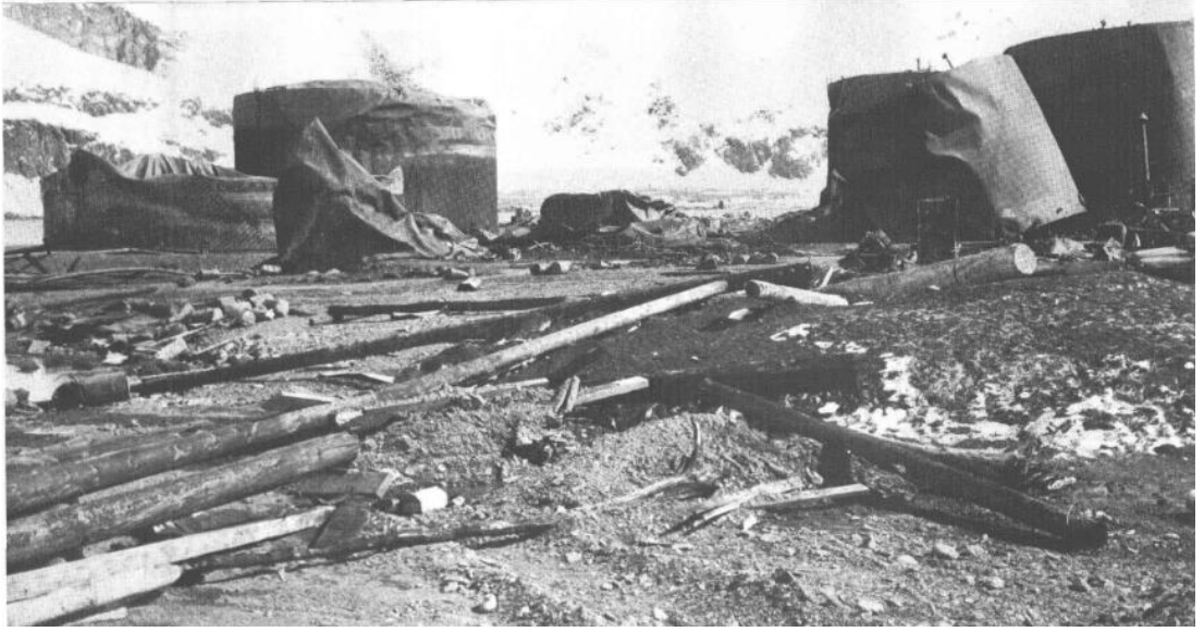
Şekil 2.2: Dalga ve yangın hasarından sonra petrol tank sahası (Alaska,1964).
