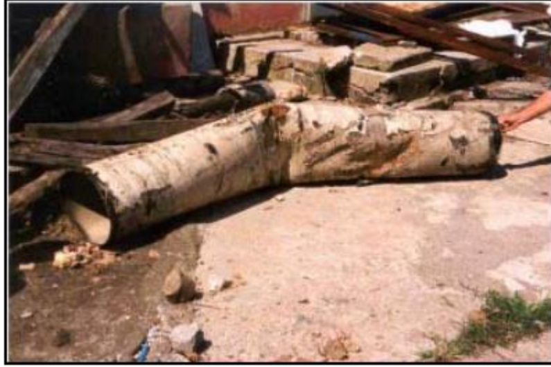
Şekil 2.8: Kocaeli depreminde boru hasarı (Kocaeli, 1999).
