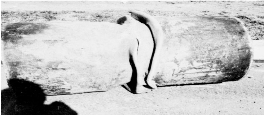
Şekil 2.3: San Fernando depreminden sonra doğalgaz boru hattında burkulma (Jennings, 1971).
