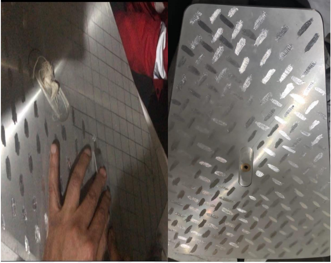
Şekil 4.10. Rehabilitasyon işlemi esnasında lokma raspalama işlemi ve raspalanmış hali
