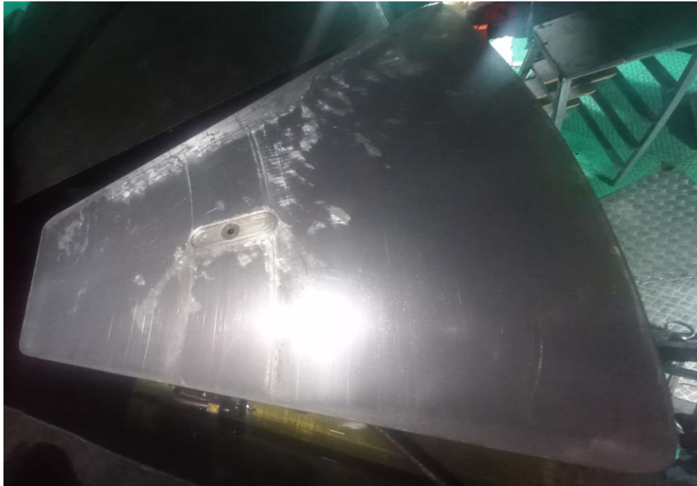
Şekil 4.8. Taşıyıcı yatak lokma pedleri rehabilitasyon öncesi görünümü
