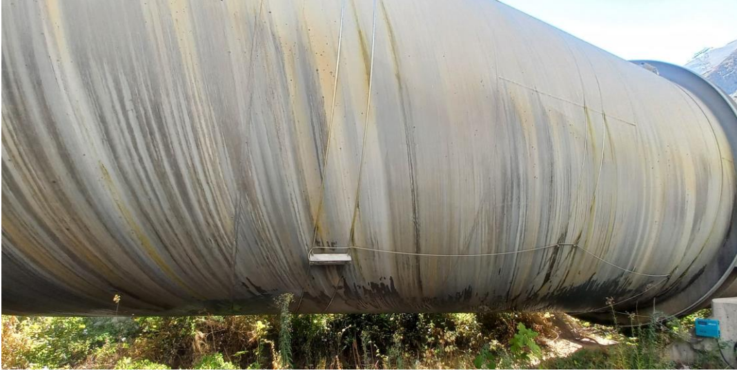
Şekil 2.11. Debimetre montajlı cebri boru
