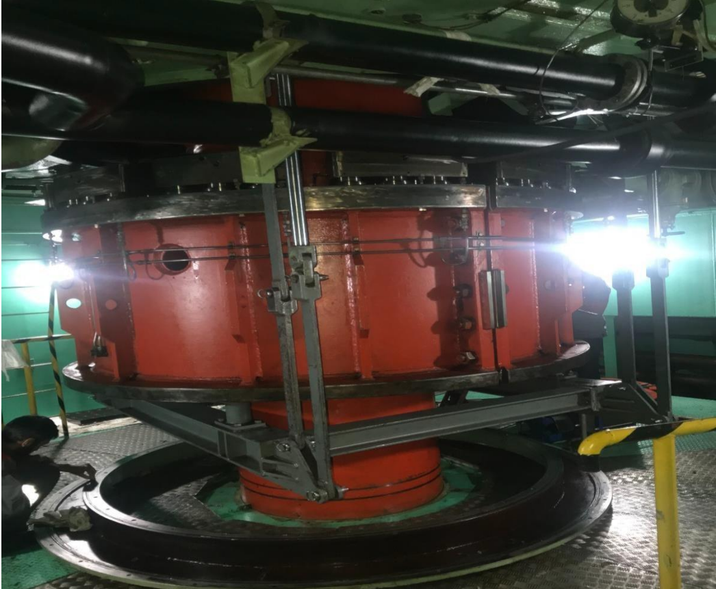
Şekil 4.1. Taşıyıcı yatak rehabilitasyon öncesi demontaj işlemi
