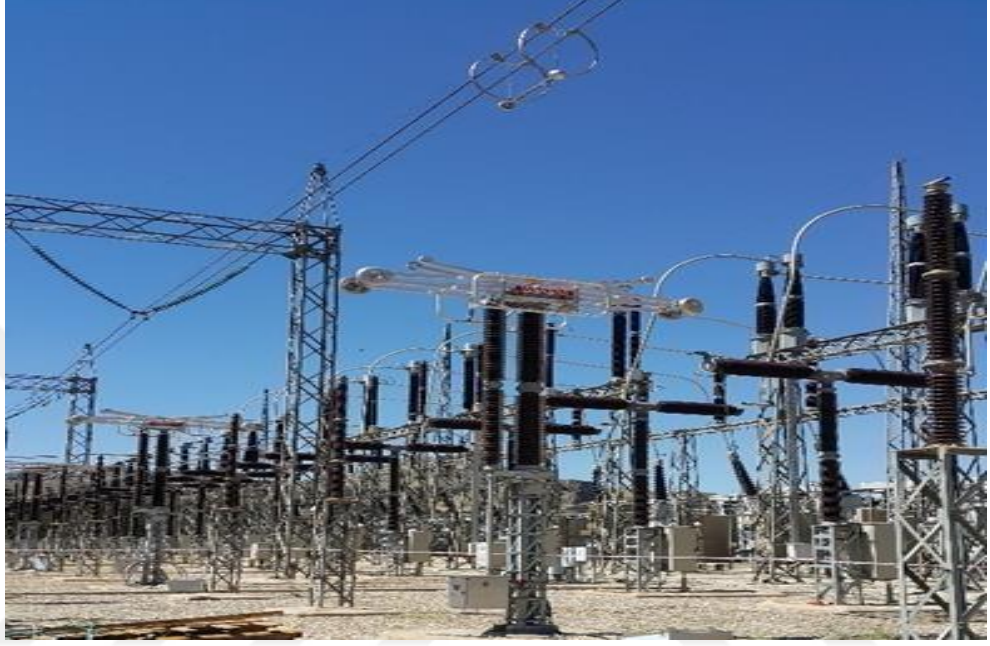
Şekil 2.7. Tam pantograf ayırıcı
