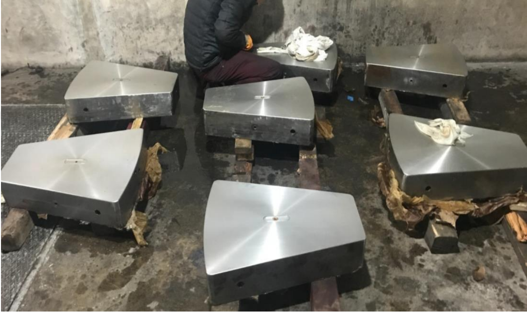
Şekil 4.9. Taşıyıcı yatak lokmaları rehabilitasyonda temizlenirken
