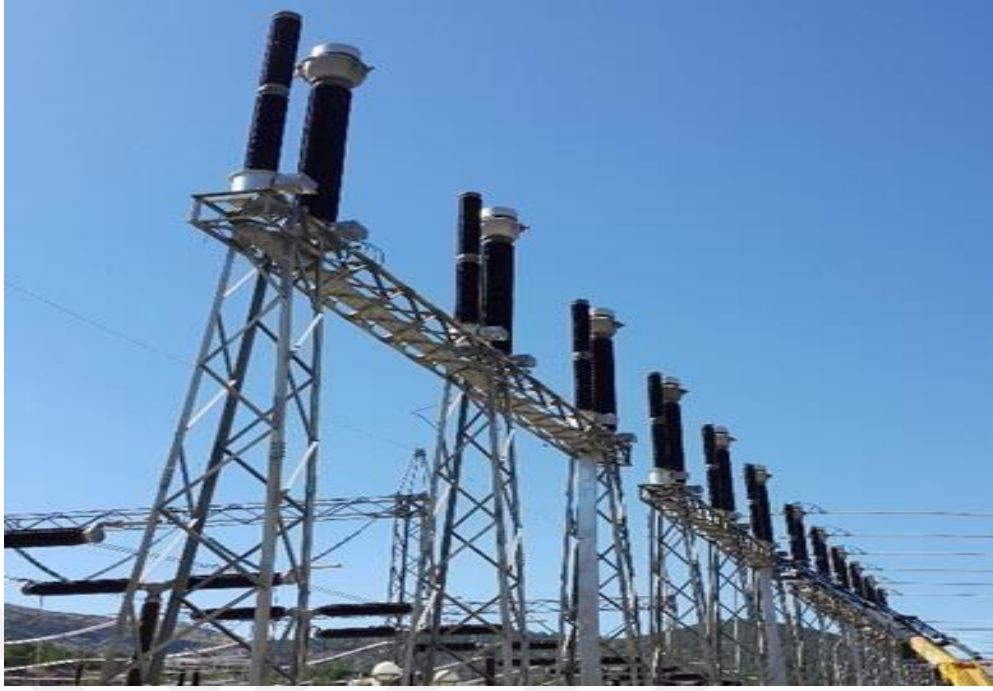
Şekil 2.8. Akım ve gerilim trafoları
