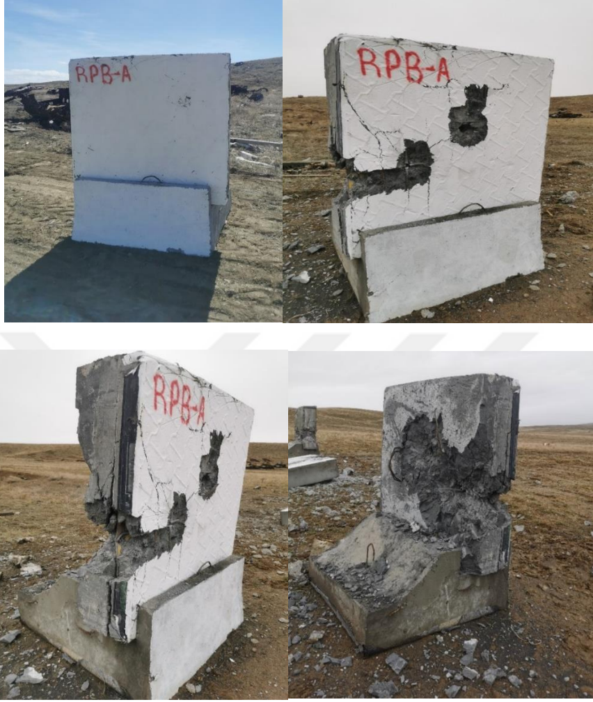
Şekil 4.24. Zırh takviyeli reaktif pudra betonunun (RPC-A) atış sonrası görünümü.
