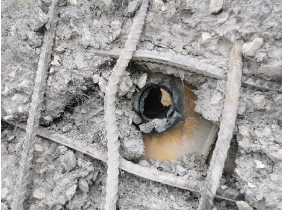
Şekil 4.22 (Devam) : Zırh Takviyeli C40 betonun atış sonrası görünümü
