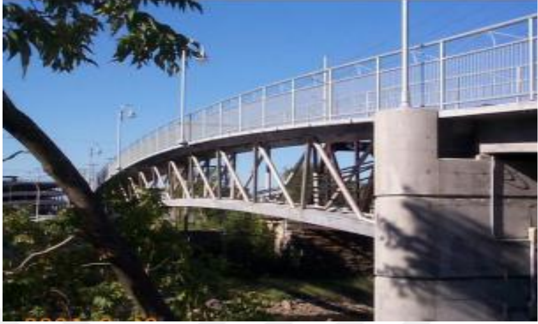
Şekil 2.1: RPC'nin ilk üretim ürünü Sherbrooke şehrindeki yaya köprüsü [7]
