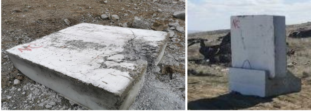
Şekil 4.20. C40 betonunun atış deneyi sonrası görünümü.
