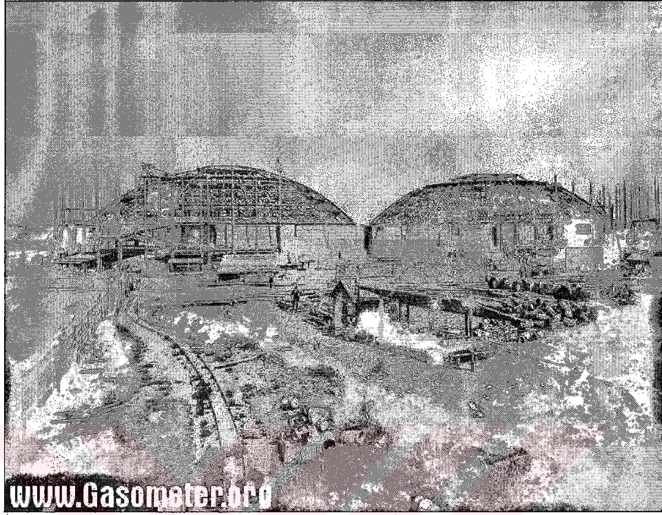
Resim.3.28 Tarihi şantiyeden görünüş – Kubbelerin yerleştirilmesi
