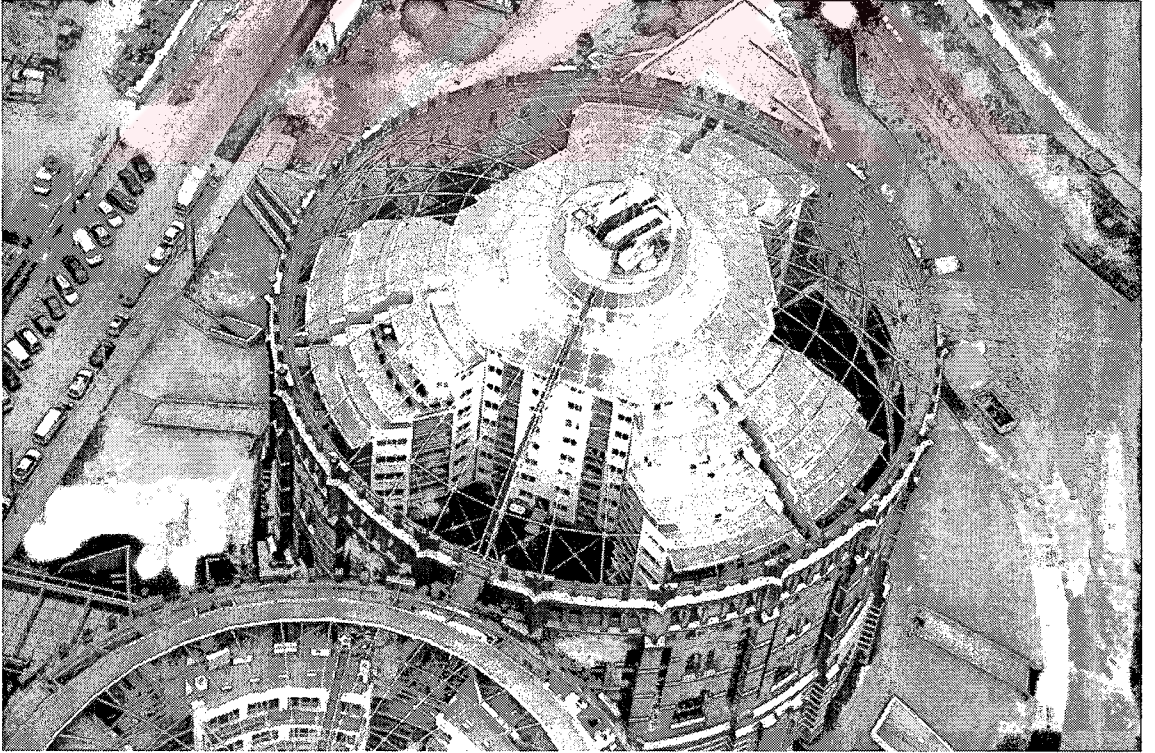
Resim.3.25 Gazometre D çatı ve avluya bakış
