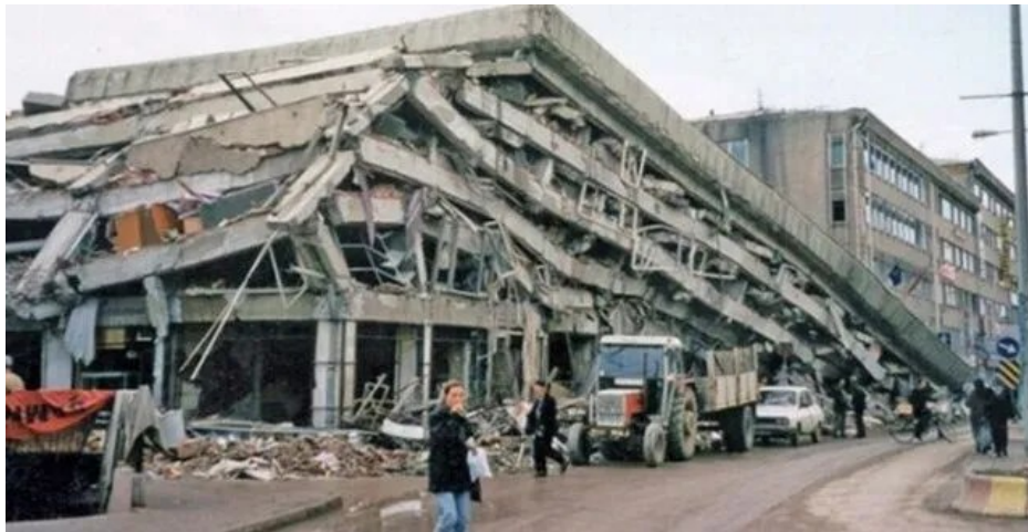
Şekil 2.5. Düzce Basmacılar Çarşısı, 1999 Düzce Depremi [32].
