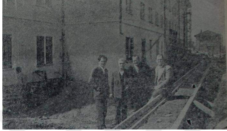
Şekil 3.14. Tekel Binasının Yapımı Sırasında Çekilen Fotoğraf [89].
