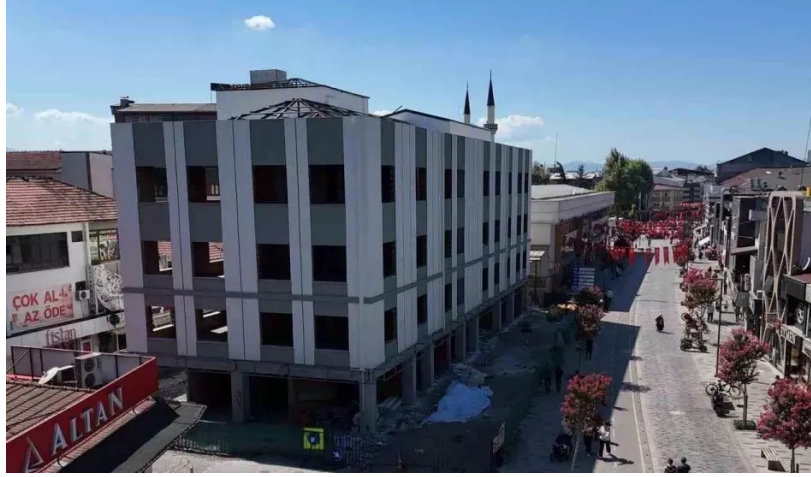
Şekil 2.6. Yıkılan Basmacılar Çarşısı Yerine Yapılan Kütüphane Binası [33].
