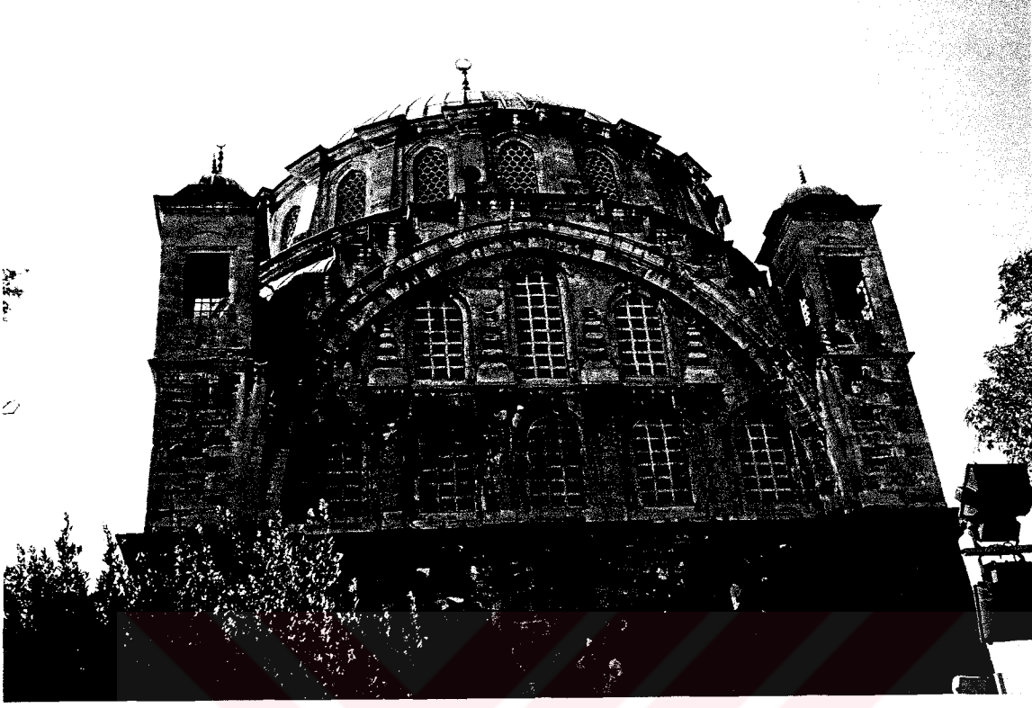
Şekil 6.33 Ayazma Camii güney cephesi
