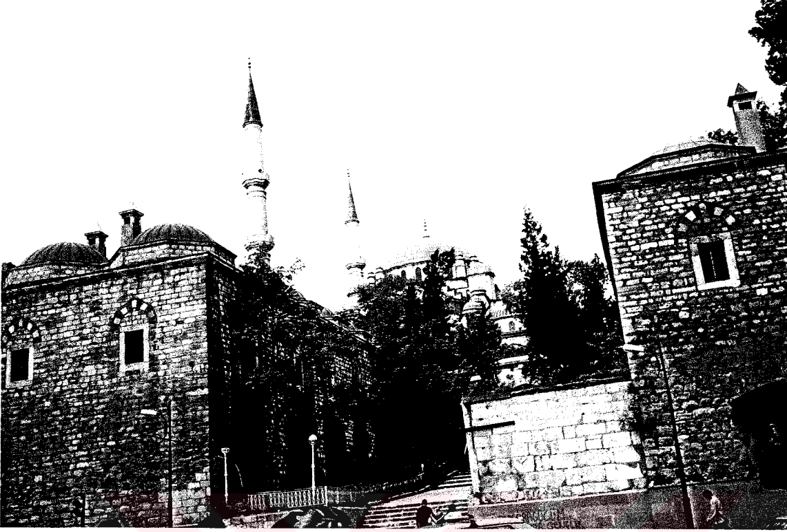
Şekil 6.21. Fatih Camii, genel görünüm
