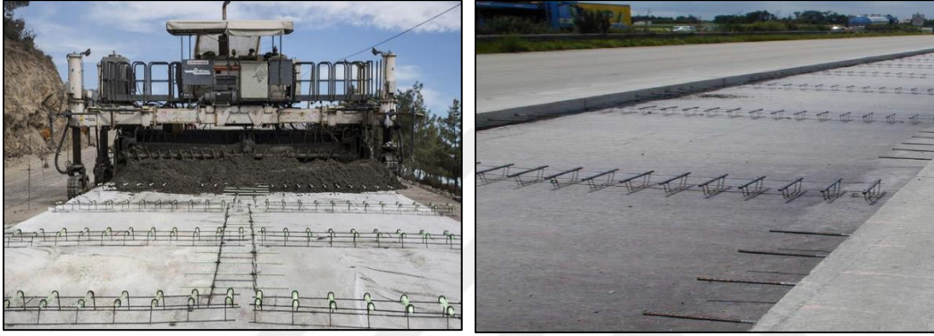
Resim 2.2. Derzli donatısız beton yol (Kaşak ve Komut, 2019)
