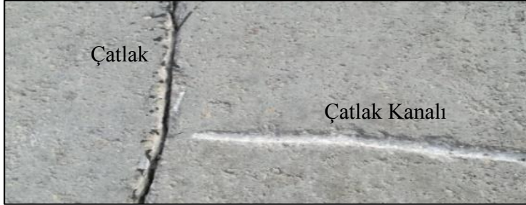
Resim 3.32. Çatlak kanallarının oluşturulması: Eskişehir, Ekim 2021
