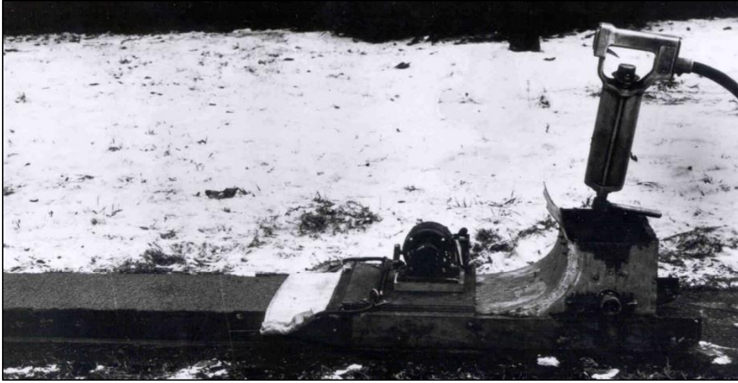
Resim 2.1. Iowa İlk pilot model kayar kalıplı serici (Smith, 1965)
