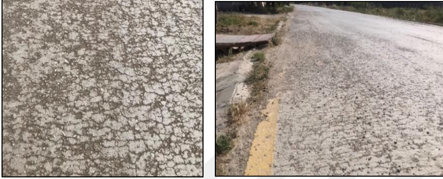
Resim 3.15. Harita şeklinde çatlama: Çanakkale, Haziran 2022
