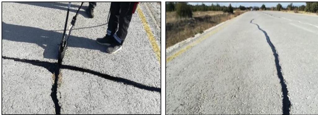
Resim 3.34. Dolgu malzemesinin uygulanması: Eskişehir, Ekim 2021
