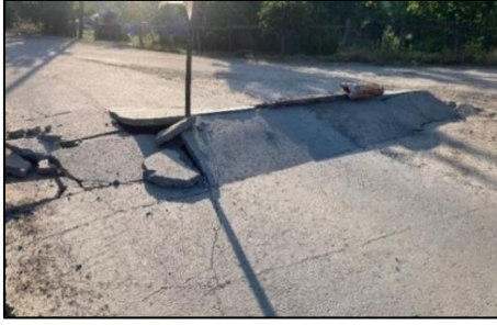
Resim 3.23. Yüksek şiddetli basınç patlaması örneği: Sakarya, Mayıs 2022
