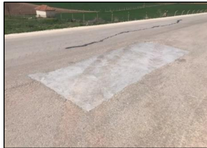
Resim 3.24. Düşük şiddetli yama bozulması örnekleri: Ankara, Ağustos 2022
