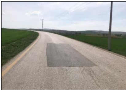
Resim 3.24. Düşük şiddetli yama bozulması örnekleri: Ankara, Ağustos 2022
