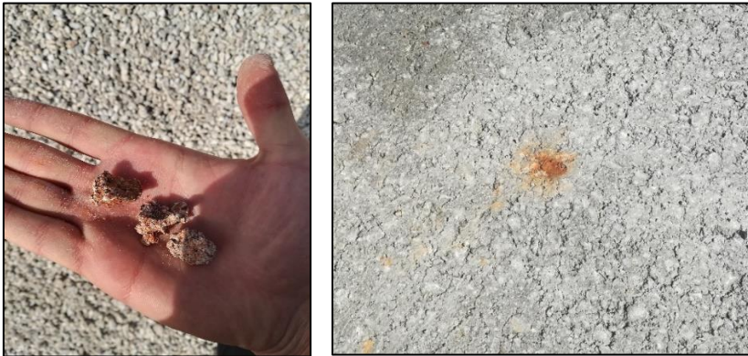
Resim 3.2. Kil toprağı ve oyukları: Çankırı, Kasım 2020
