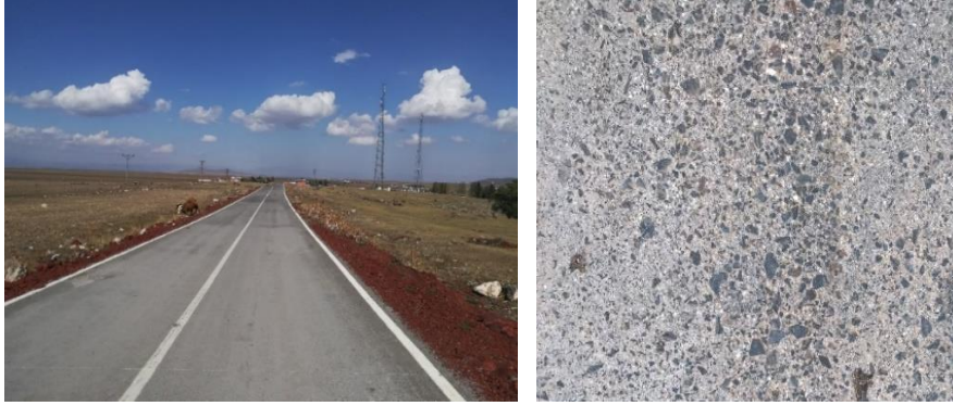
Resim 3.1. Agreganın cilalanması örneği: Kars, Eylül 2021
