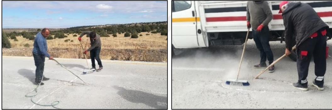
Resim 3.33. Çatlakların temizlenmesi: Eskişehir, Ekim 2021
