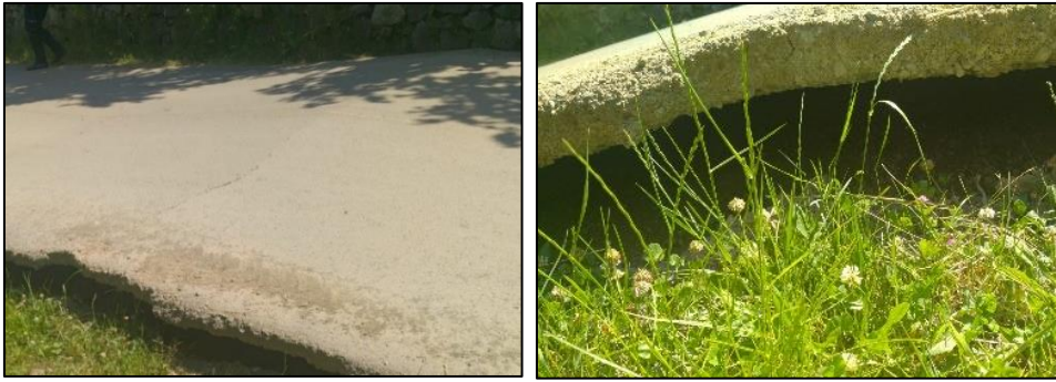
Resim 3.22. Basınç patlaması örnekleri: Sakarya, Mayıs 2022
