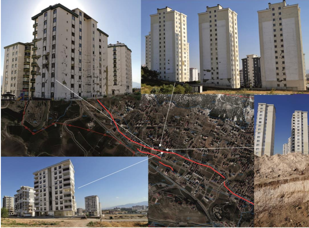
Şekil 40. KSÜ Aşağı Yerleşkesi'nin kuzeyinde Fay 2'ye oldukça yakın konumda bulunan ve ağır hasar nedeni ile sonradan yıkılan binaların görünümü.
