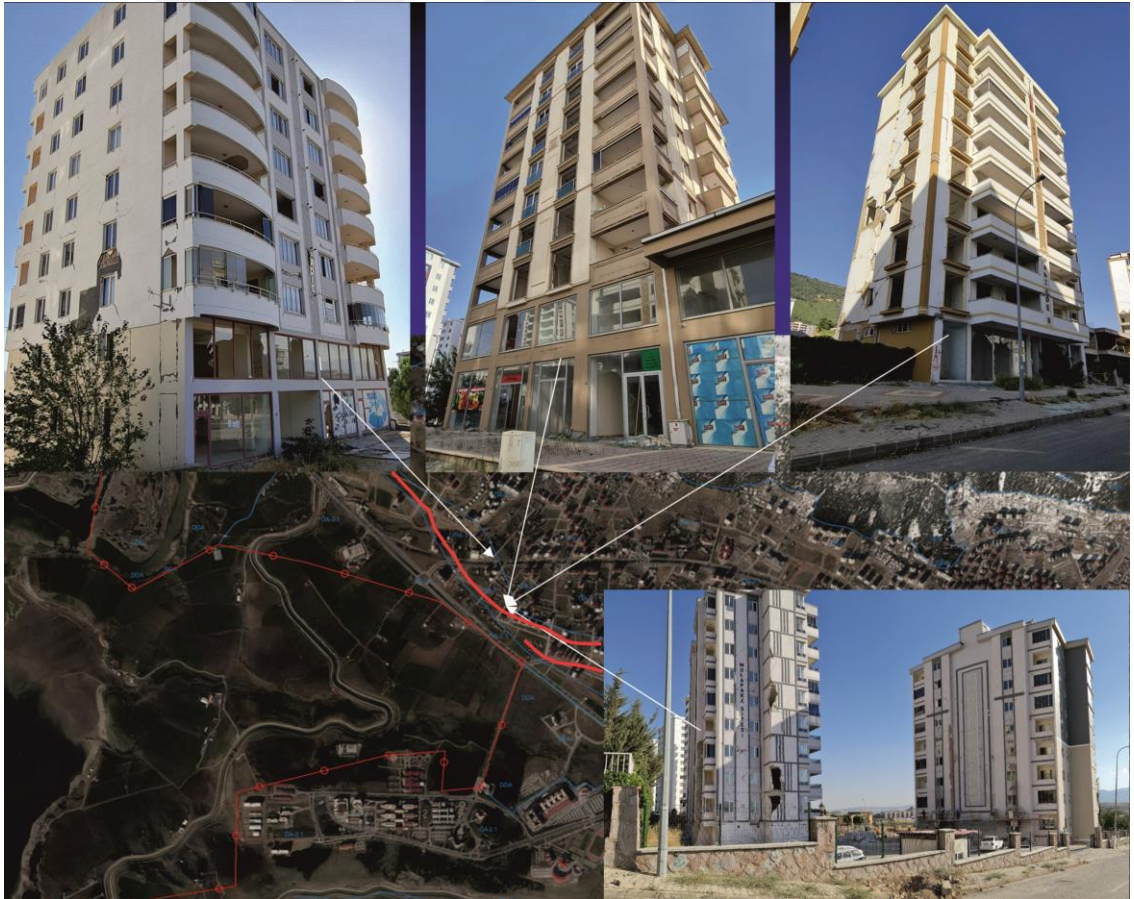
Şekil 37. KSÜ Avşar Yerleşkesi'nin hemen kuzeyinde Fay 2'ye oldukça yakın konumda bulunan binalardaki az-orta-ağır hasara ilişkin görünüm.
