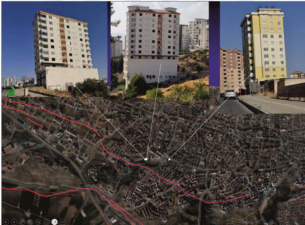
Şekil 41. Fay 2'nin orta kesiminde faya oldukça yakın konumda bulunan ağır hasarlı binaların görünümü
