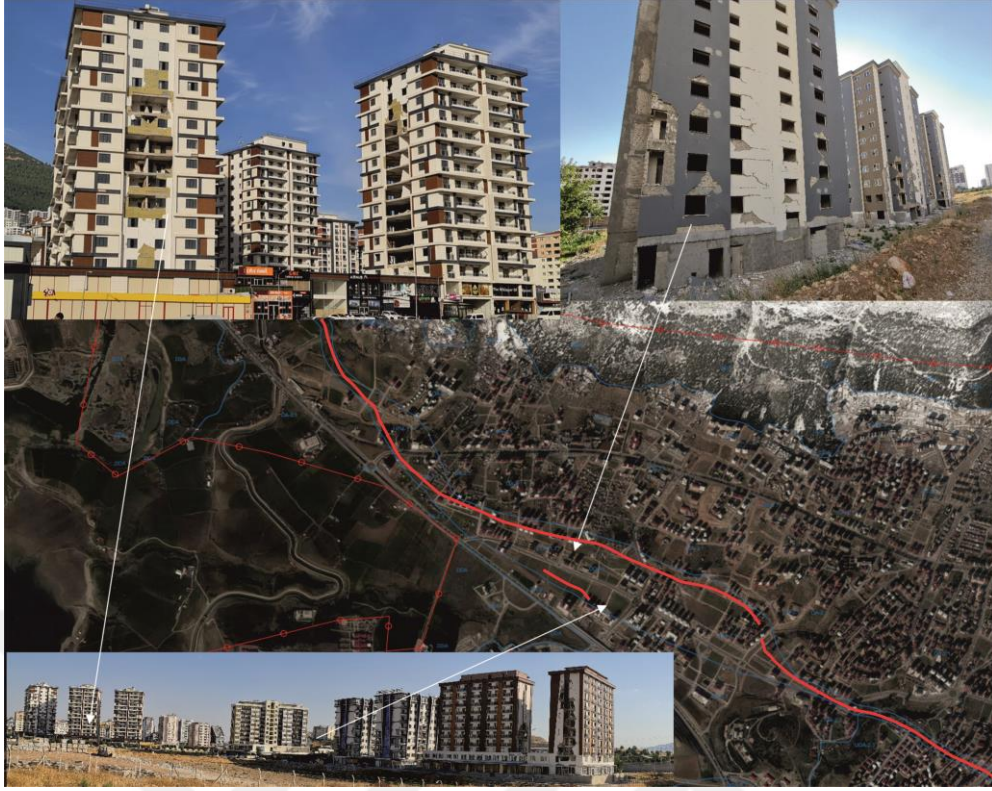
Şekil 38. KŞÜ Avşar Yerleşkesi'nin kuzeyinde Fay 2'ye oldukça yakın konumda bulunan binalardaki orta-ağır hasara ilişkin görünüm.
