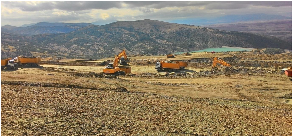
Şekil 4.75 Heyelan sahası kazı çalışmaları görünümü-7
