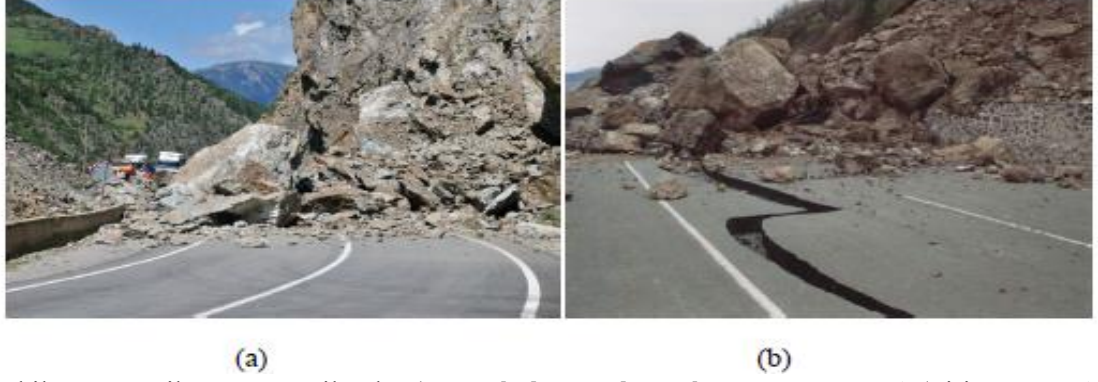
Şekil 3.3. Devrilme türü yenilmeler (a- Tirebolu-Torul DY, b- Hopa-Sarp DY) (Şirin, A 1995)
