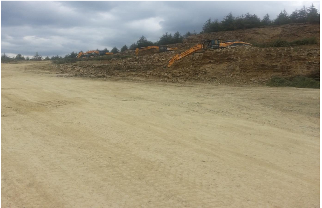
Şekil 4.72. Heyelan sahası kazı çalışmaları görünümü-3
