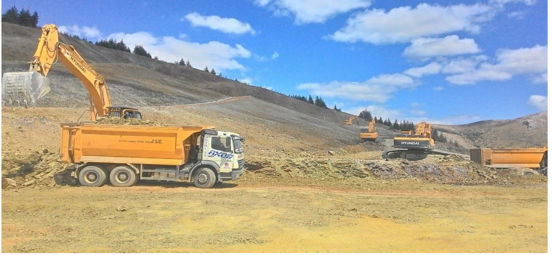
Şekil 4.74. Heyelan sahası kazı çalışmaları görünümü-6
