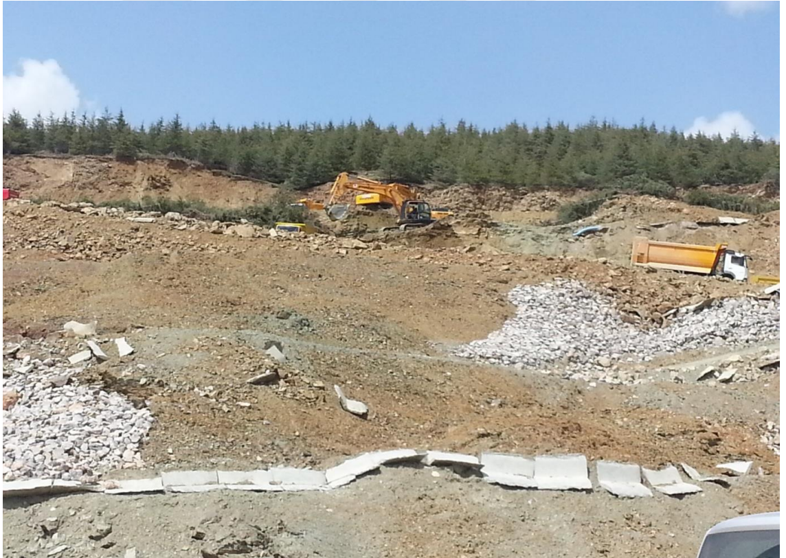
Şekil 4.70. Heyelan sahası kazı çalışmaları görünümü-1
