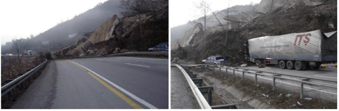
Şekil 3.8. Arıdurak tüneli çıkışı kaya heyelanı (ötelenmeli kaya kayması (heyelanın yola verdiği hasar-trafik riski görünümüleri) (Şen ,S 2009)
