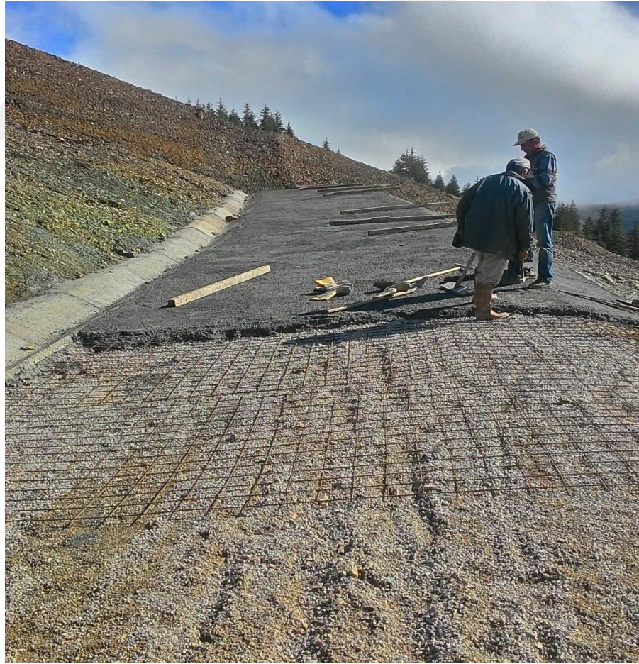
Şekil 4.93. Beton kaplamalı tek kat hasır çelik detayı uygulama görünümü-4
