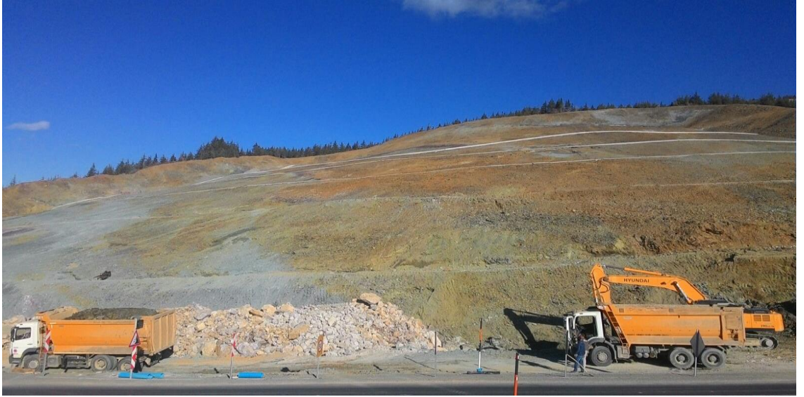
Şekil 4.78. Heyelan sahası kazı ve istifli taş dolgu çalışmaları görünümü-2
