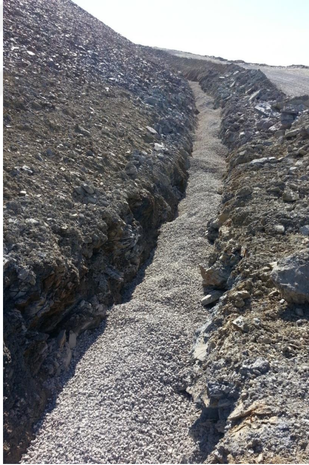
Şekil 4.86. Standart yeraltı drenaj uygulama görünümü-2
