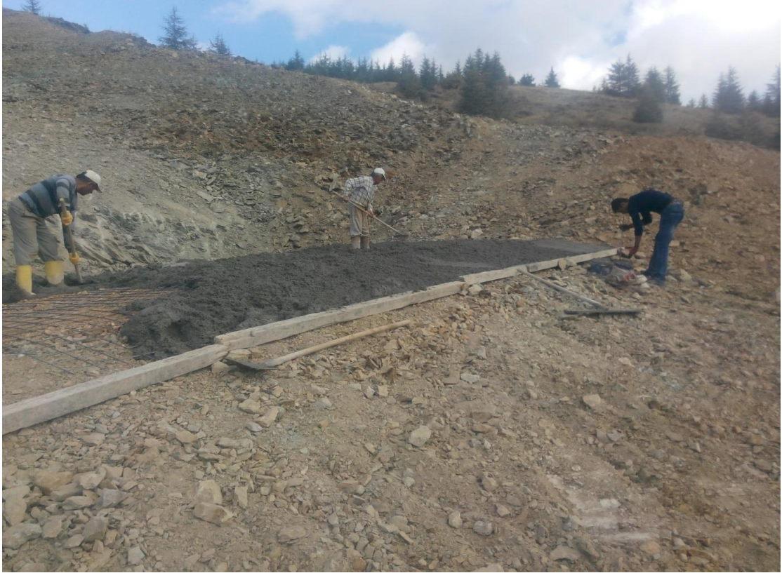
Şekil 4.91. Beton kaplamalı tek kat hasır çelik detayı uygulama görünümü-2
