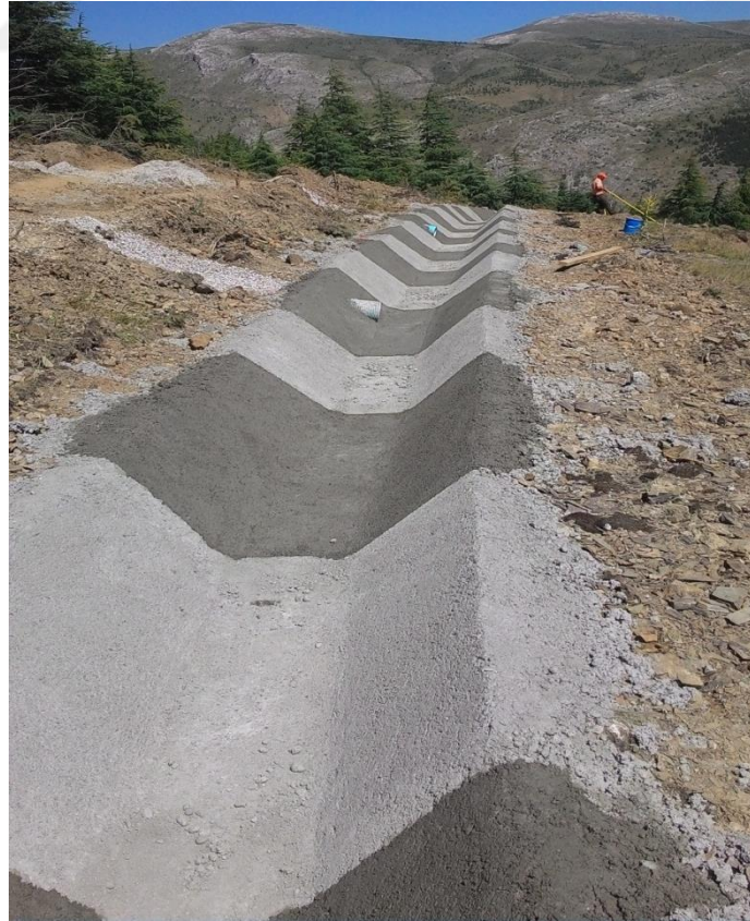
Şekil 4.96. Beton kaplamalı palye hendeği uygulama görünümü-2
