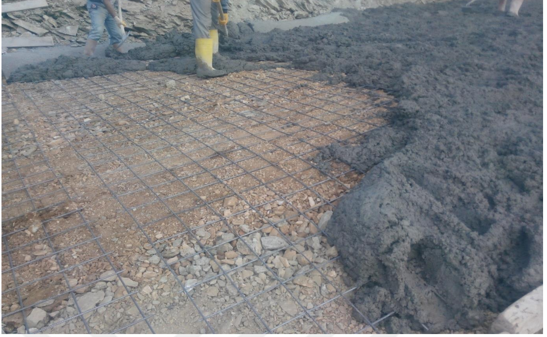
Şekil 4.92. Beton kaplamalı tek kat hasır çelik detayı uygulama görünümü-3
