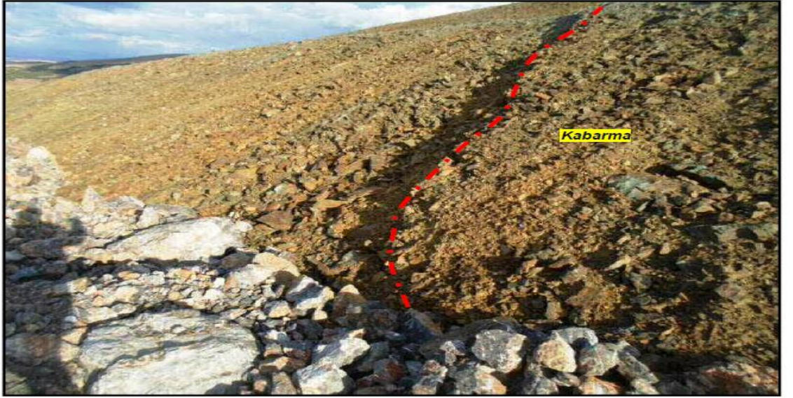
Şekil 4.12. Heyelan sahasında meydana gelmiş kabarmalardan genel görünüm
