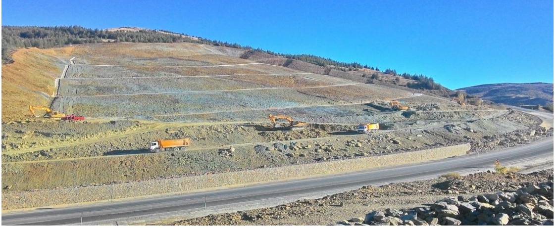
Şekil 4.76. Heyelan sahası kazı çalışmaları görünümü-8
