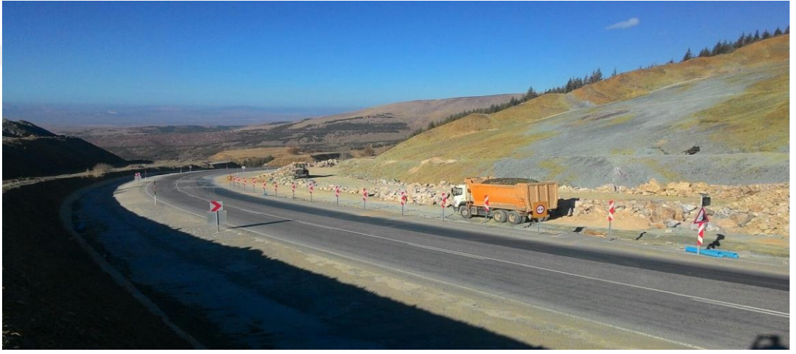
Şekil 4.77. Heyelan sahası kazı ve istifli taş dolgu çalışmaları görünümü-1
