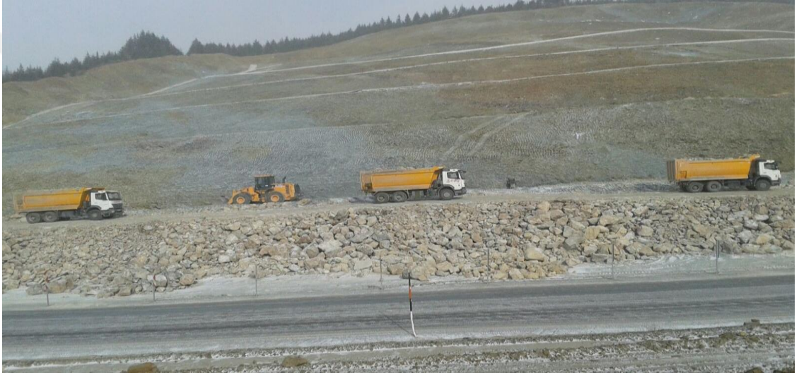
Şekil 4.80. Heyelan sahası istifli taş dolgu çalışmaları görünümü-1
