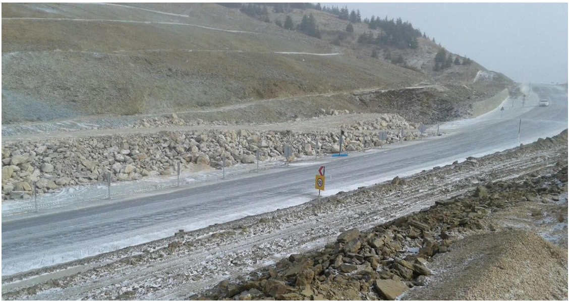
Şekil 4.81. Heyelan sahası istifli taş dolgu çalışmaları görünümü-2
