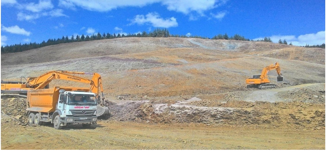
Şekil 4.73. Heyelan sahası kazı çalışmaları görünümü-5
