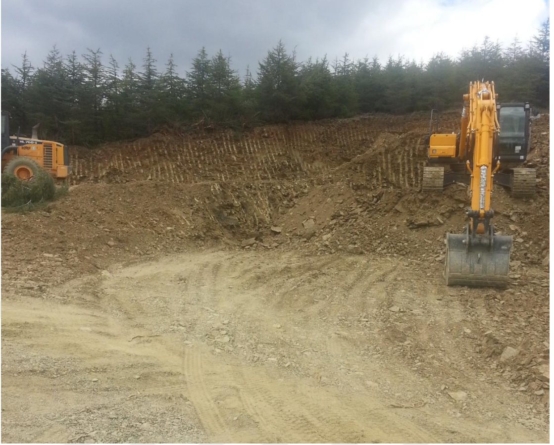
Şekil 4.71. Heyelan sahası kazı çalışmaları görünümü-2
