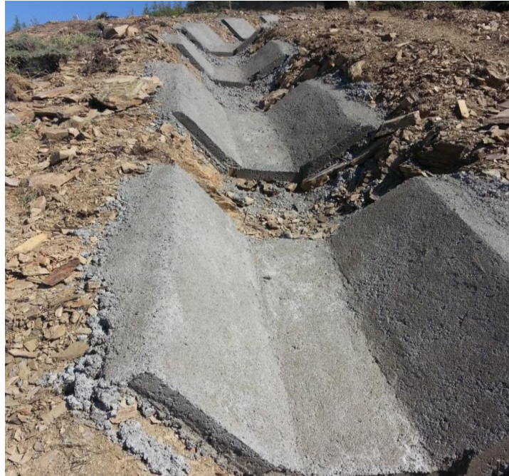
Şekil 4.98. Beton kaplamalı kafa hendeđi uygulama görünümü-2
