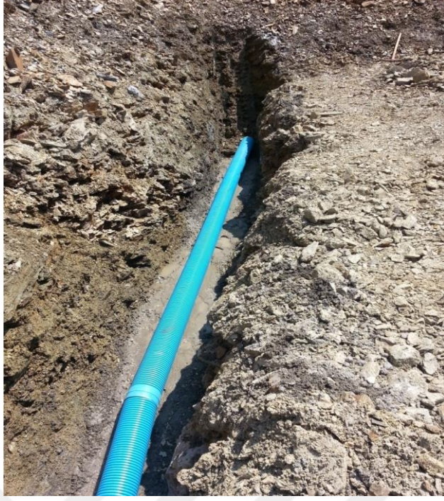
Şekil 4.85. Standart yeraltı drenaj uygulama görünümü-1
