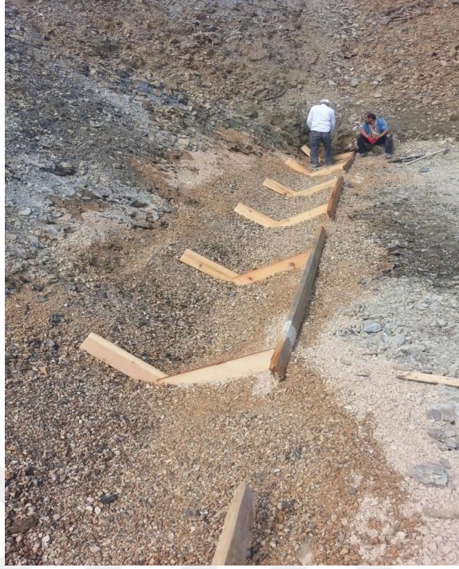
Şekil 4.95. Beton kaplamalı palye hendeği uygulama görünümü-1
