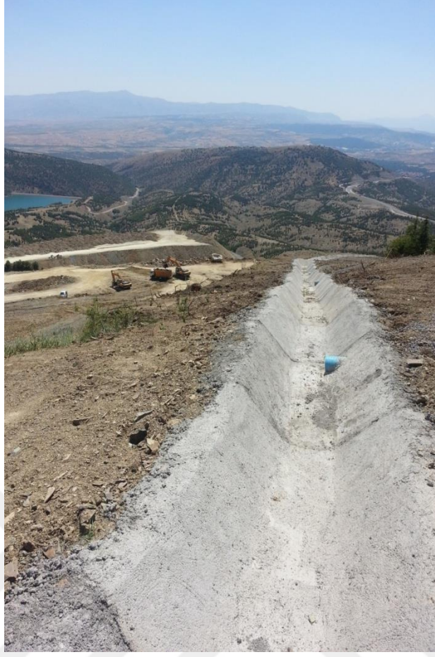
Şekil 4.99. Beton kaplamalı kafa hendeği uygulama görünümü-3
