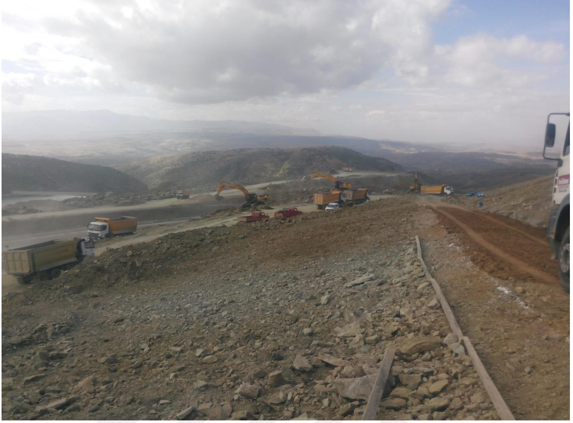
Şekil 4.90. Beton kaplamalı tek kat hasır çelik detayı uygulama görünümü-1
