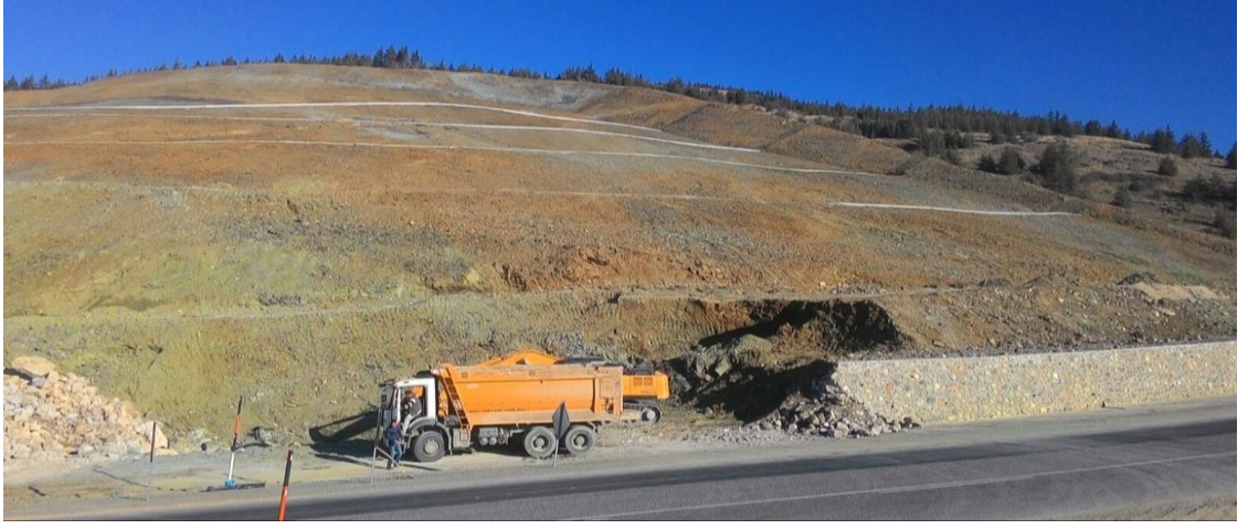
Şekil 4.79. Heyelan sahası kazı ve istifli taş dolgu çalışmaları görünümü-3
