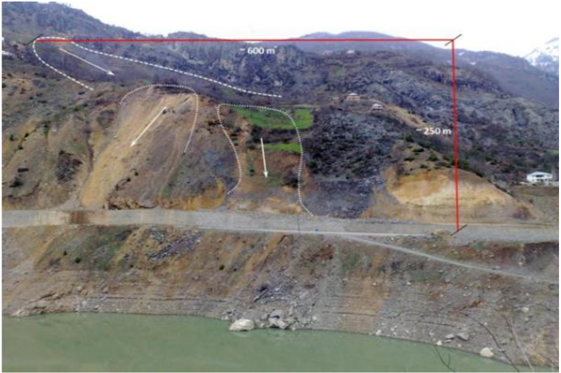
Şekil 3.9. Tirebolu-Torul Devlet Yolu (877-02) Km:30+000 Süme Heyelanı (karmaşık yapıda ardışık gelişen dairesel kayma şeklindeki heyelan örneği) (Şirin, A, 1995)
