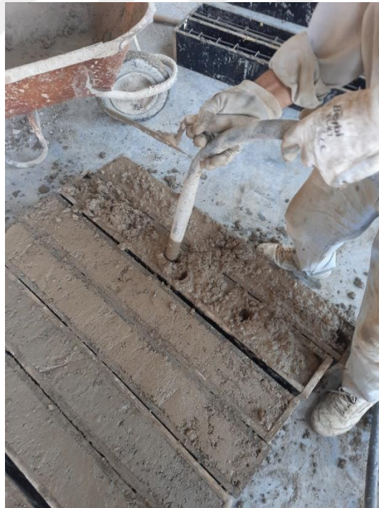
Şekil 4.9. Vibratörle harcın kalıplara yerleştirme işlemi
