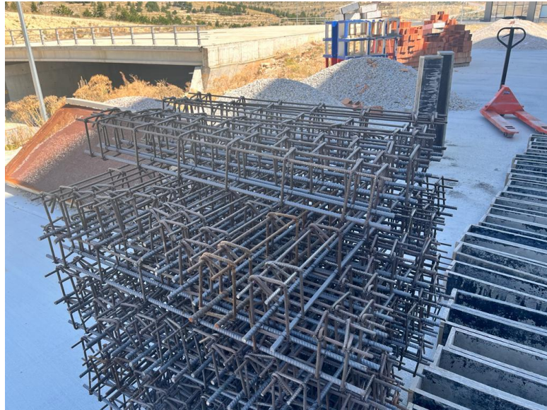
Şekil 4.7. Büyük kiriş numuneler için hazırlanan donatılar
