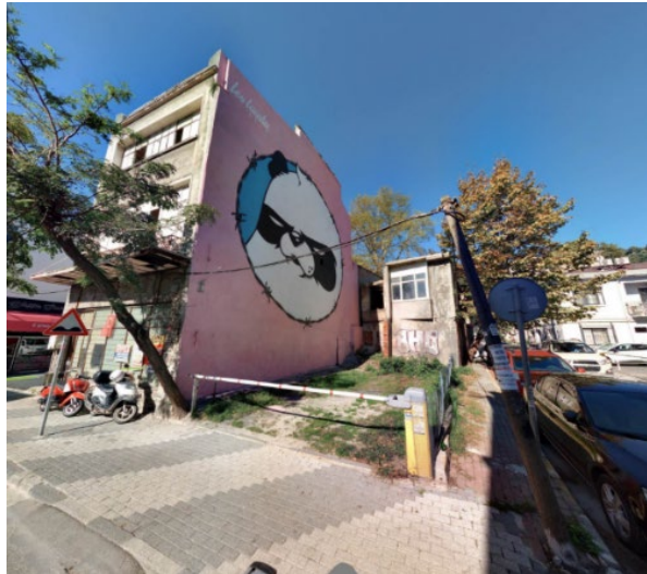
Şekil 3.38 : Sarıyer, 597 ada, 6 parsel, sokak görüntüsü
