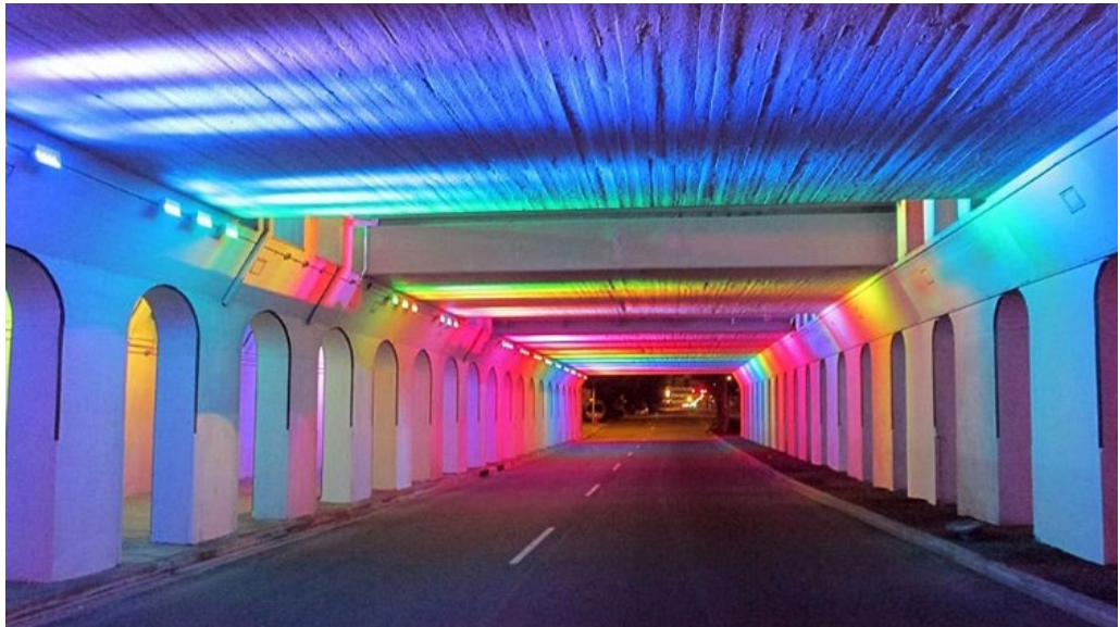
Şekil 2.50 : Geçit, Birmingham, Alabama (Url-34).
