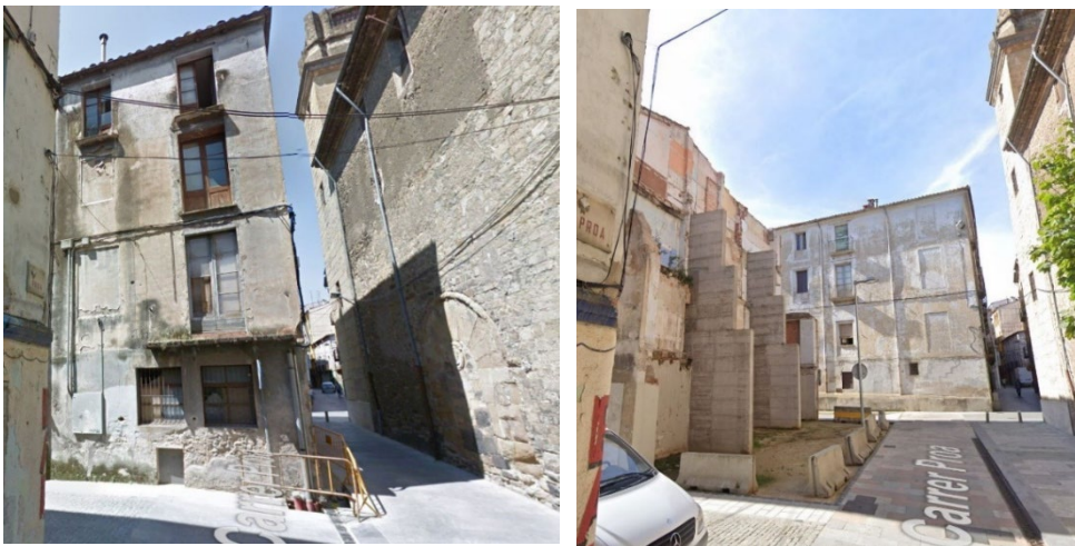
Şekil 2.40 : Parselde yer alan bina yıkılmadan önce ve yıkıldıktan sonraki görüntüler (Google Earth,2023).
