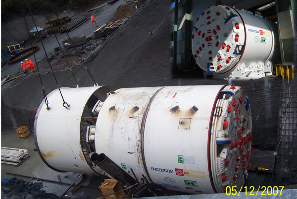
Şekil 5.1 : Kazıda kullanılan TBM'in fabrika ve sahada montajı.
