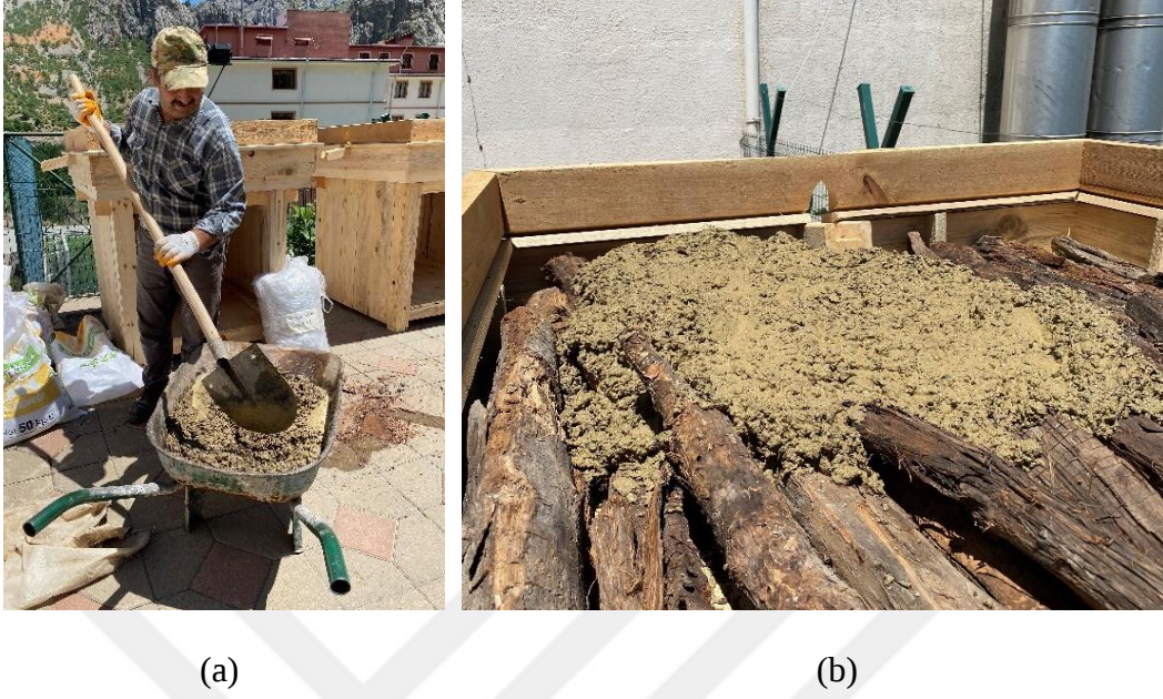
Şekil 6.16 a) Yaşkuru toprağının hazırlanması, b) Yaşkurunun merteklerin üzerine serilmesi
