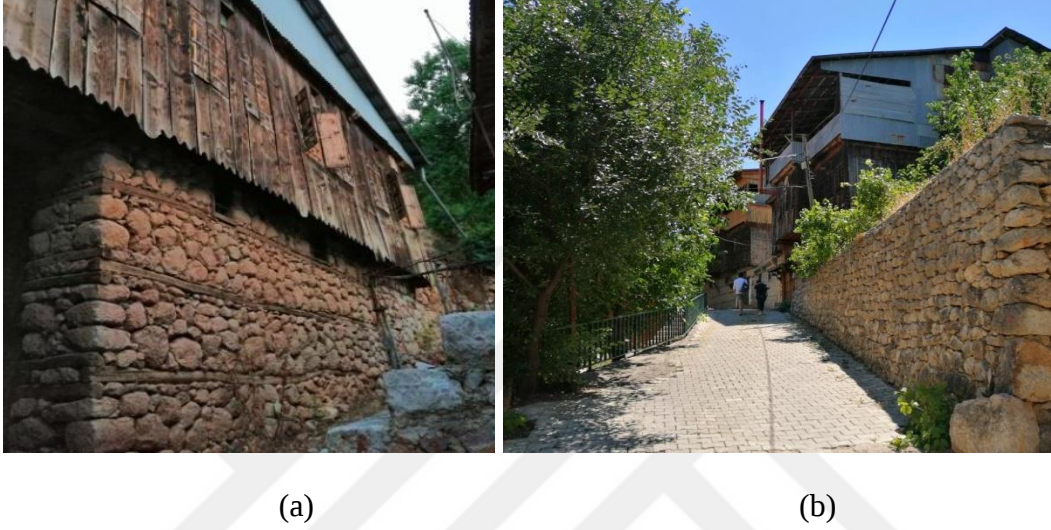
Şekil 3.21 a) Kemaliye evinin taş duvarı, b) Kemaliye evinin seki duvarı
