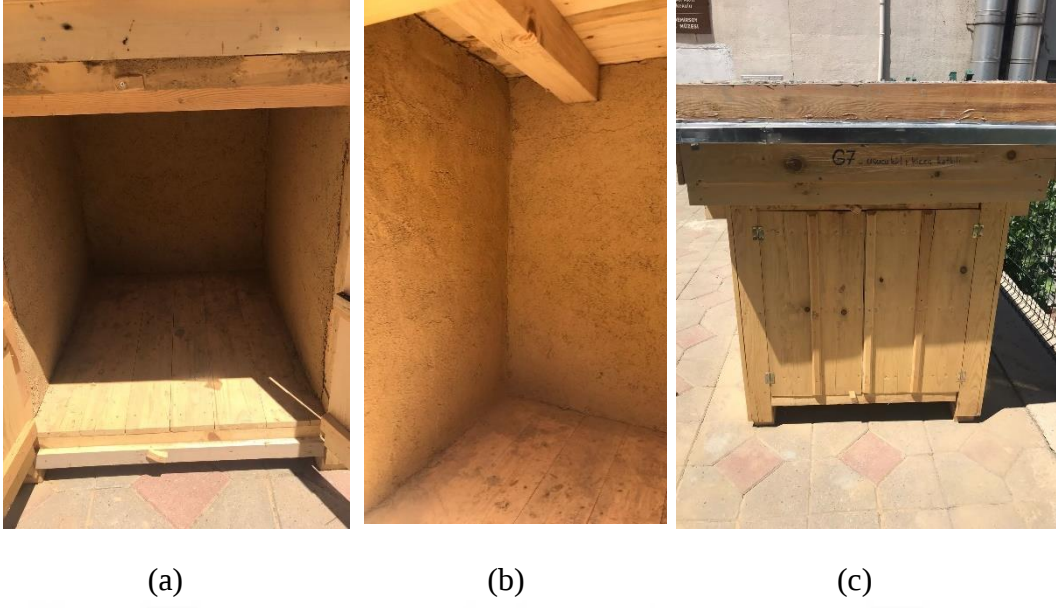
Şekil 6.13 a) Dam modellerinin zemin döşemesi, b) Dam modellerinin duvar dolgusu, c) Dam modellerinin kapısı
