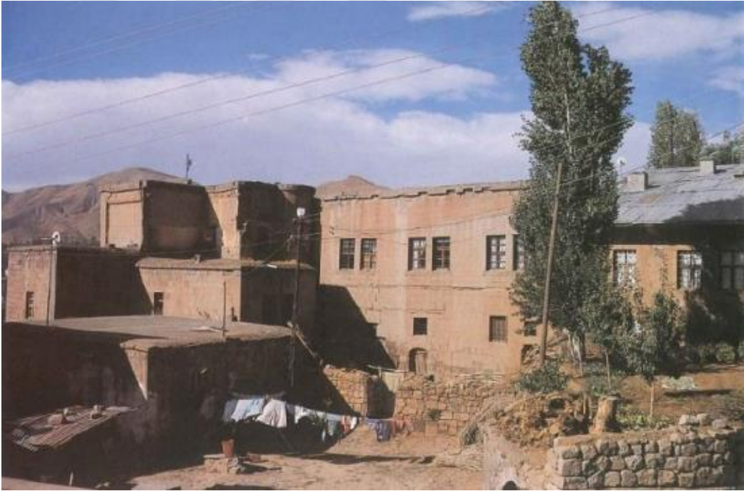
Şekil 2.25 Bitlis Müftüler Evi'nden görünüş [13]
