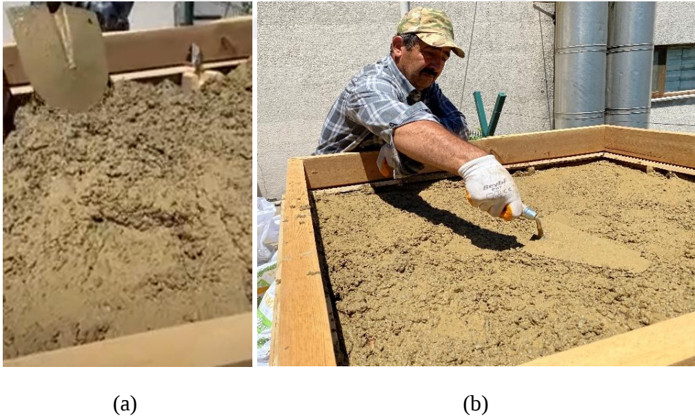
Şekil 6.17 a) Yaşkurunun fitil seviyesine çıkarılması, b) Yaşkurunun dama serilip düzeltilmesi
