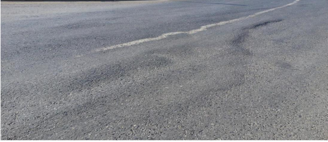
Şekil 11. Ondülasyon yol örneği
