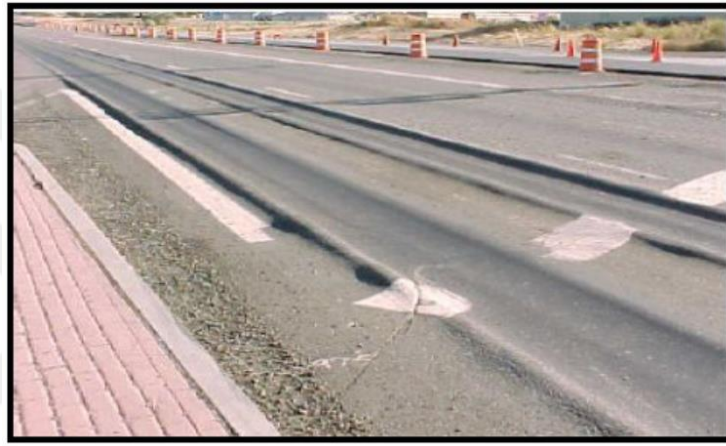
Şekil 10. Tekerlek izi oturması yol örneği (Avcı 2009)
