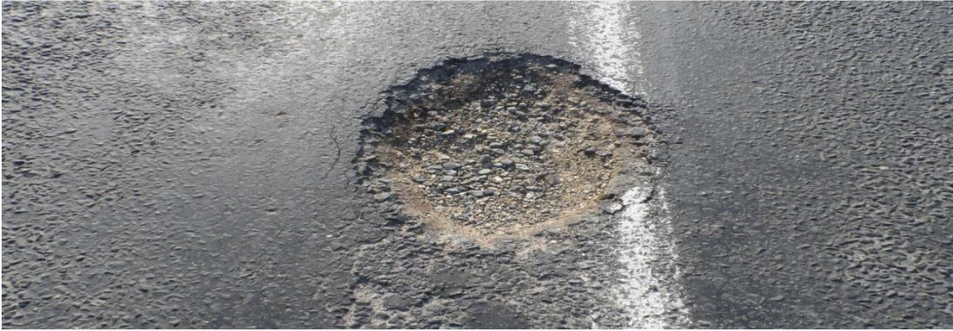
Şekil 12. Çukur yol örneği
