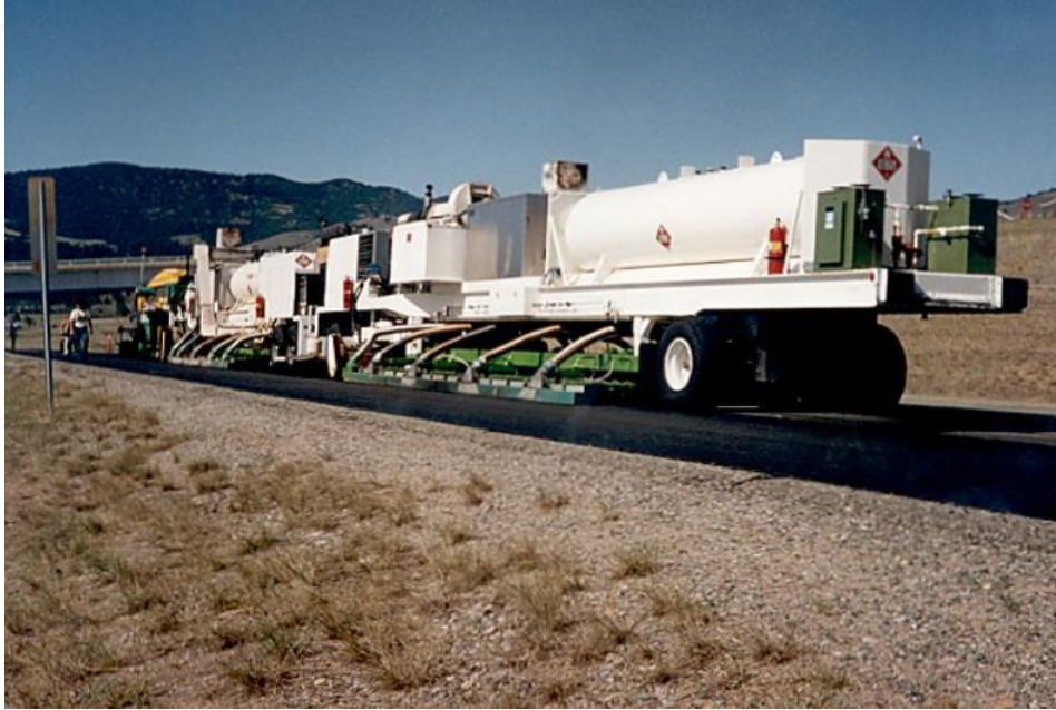
Şekil 16. Yerinde sıcak geri dönüşüm uygulamalarından örnek (Salta 2010)
