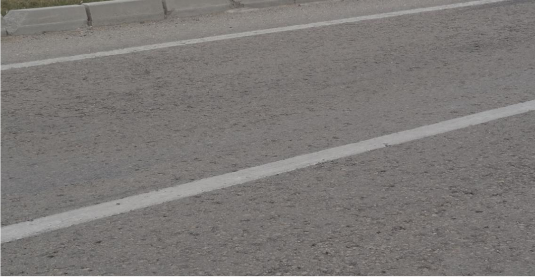
Şekil 13. Segregasyon soyulma sökölme yol örneđi(Ertaş 2019)
