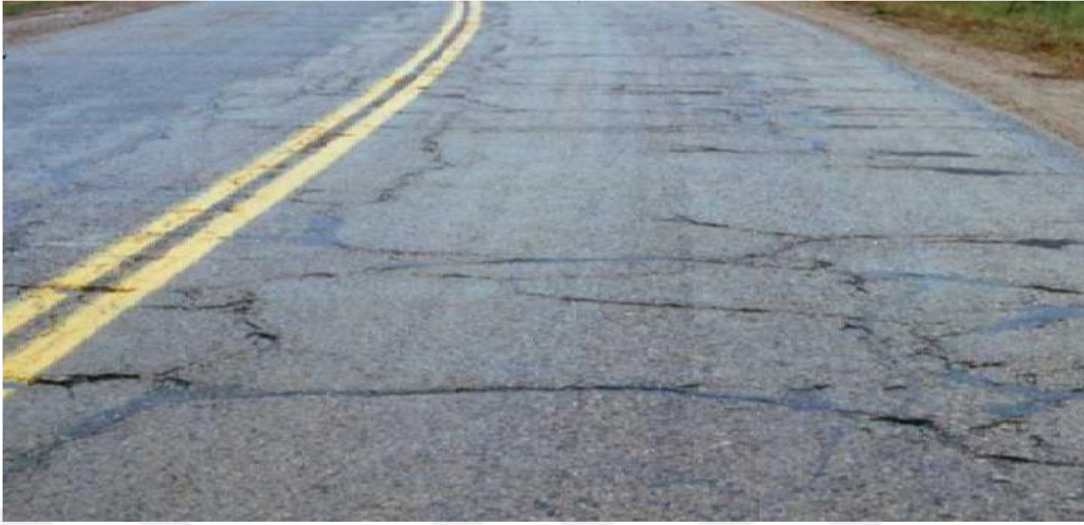
Şekil 8. Blok çatlakları
