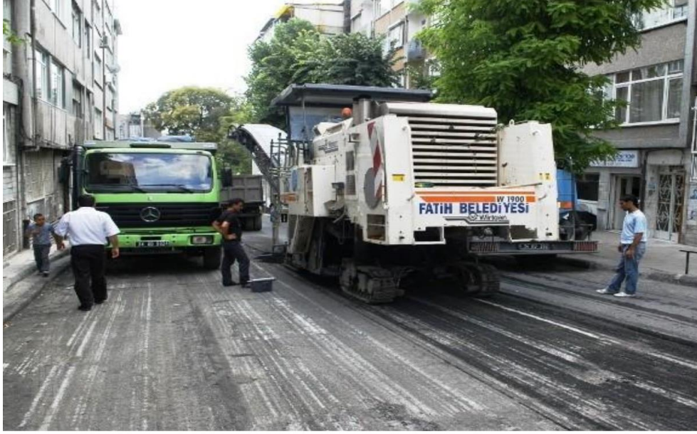
Şekil 14. Soğuk Düzeltme işlemi sonrası yol yüzeyi(Kaya 2011)
