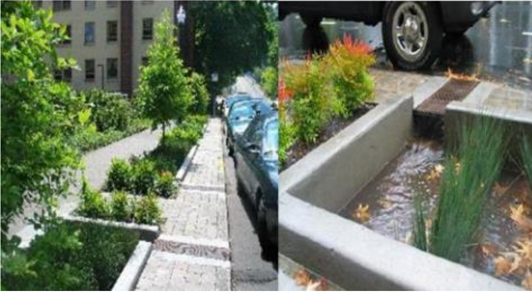
Şekil 2.12 Portland, Oregon'da uygulanan biyolojik hendekler (Serdar Yakut ve Erdem Kaya, 2020).
