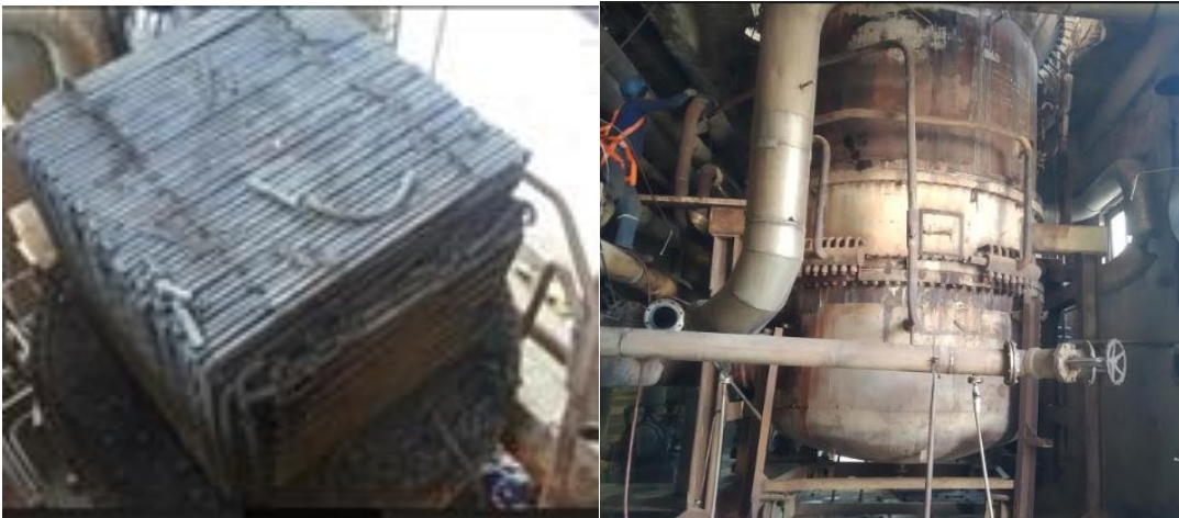
Şekil 4.1. Revizyon öncesi eski reaktör kare şeklinde sarımlı serpantinler.
