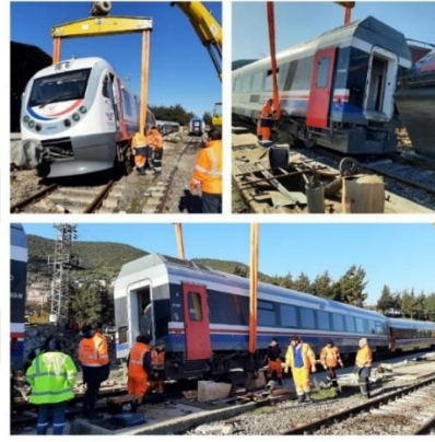
Fotoğraf 3.47 Devrilen demiryolu araçlarının onarım çalışmaları
