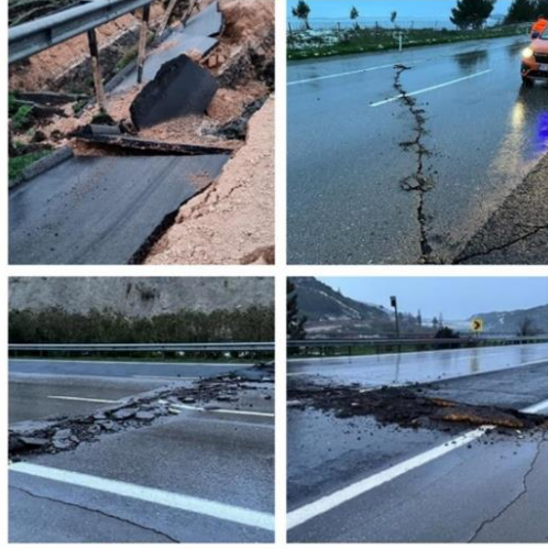
Fotoğraf 3.1 Tarsus- Adana- Gaziantep otoyolunda hasar
