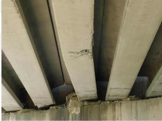
Fotoğraf 3.16 Yanal/dikey eğilme ve orta açıklıkta iç kiriş hasarı
