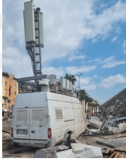
Fotoğraf 3.109 Artçı depremler nedeniyle hasar gören mobil baz istasyonu
