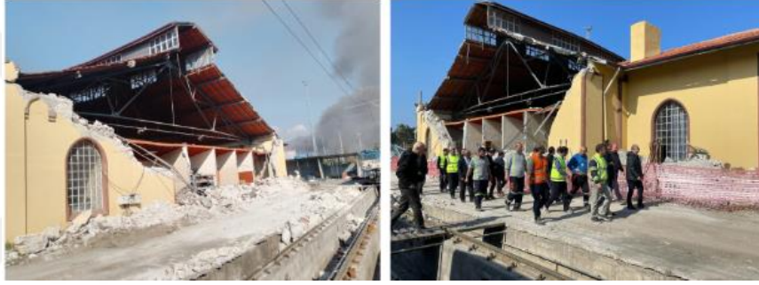
Fotoğraf 3.44 Hasar gören istasyon binası
