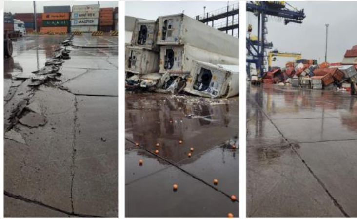
Fotoğraf 3.56 İskenderun Limanında gözlemlenen hasarlar
