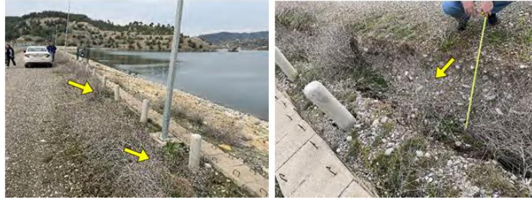
Fotoğraf 3.80 Kılavuzlu barajı kretinin yanal yayılması
