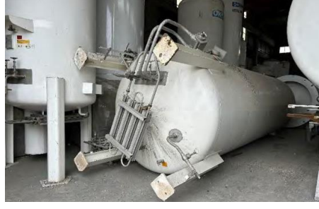
Fotoğraf 3.103 Sabitlenmemiş dikey tankın devrilmesi
