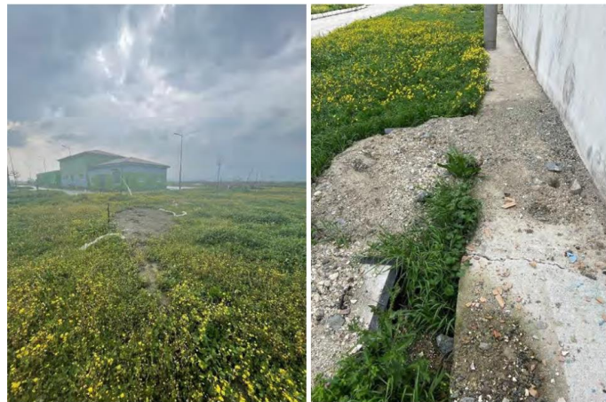
Fotoğraf 3.71 Narlıca atıksu arıtma tesisi çevresinde sıvılaşma püskürmesi
