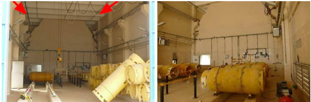
Fotoğraf 3.68 Dolgu duvarda kısmi yıkılma hasarı
