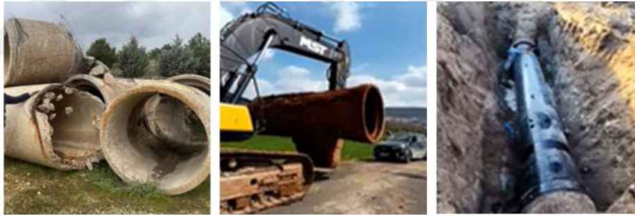
Fotoğraf 3.58 Hasarlı öngerilmeli beton boruların çelik borularla değiştirilmesi
