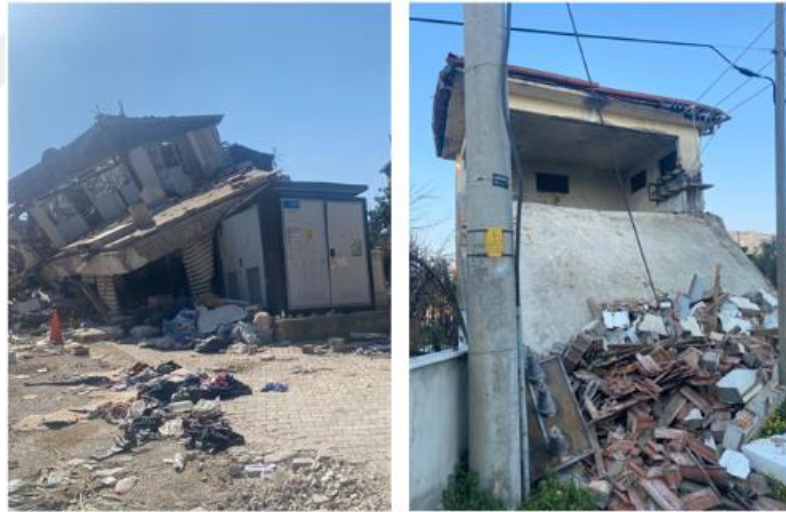
Fotoğraf 3.82 Trafo merkezi binalarında gözlemlenen hasarlar
