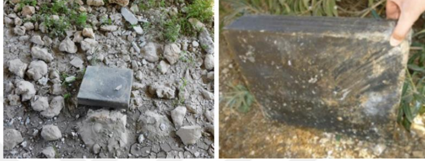
Fotoğraf 3.35 Zemine düşmüş elastomerik yastıklar
