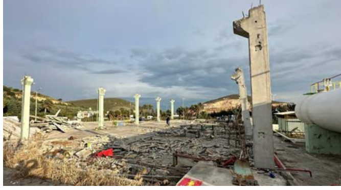
Fotoğraf 3.100 Antakya'da prekast üretim binasının çökmesi
