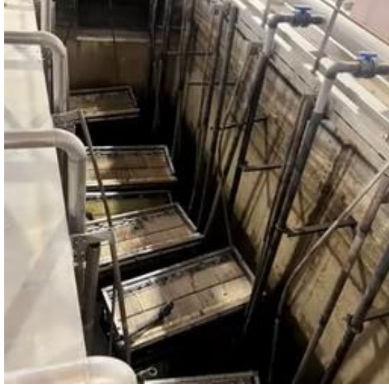
Fotoğraf 3.75 Bağlantı yerlerinden çıkan membranların su üstünde yüzmesi
