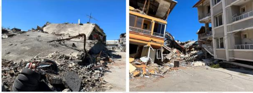
Fotoğraf 3.95 Antakya’da yıkılan binaların altında kalan elektrik direkleri
