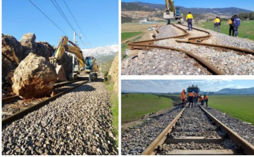
Fotoğraf 3.48 Demiryolu hatlarında onarım çalışmaları
