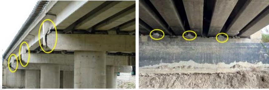
Fotoğraf 3.29 Yanal destek kanadı hasarı ve deprem takozu hasarı
