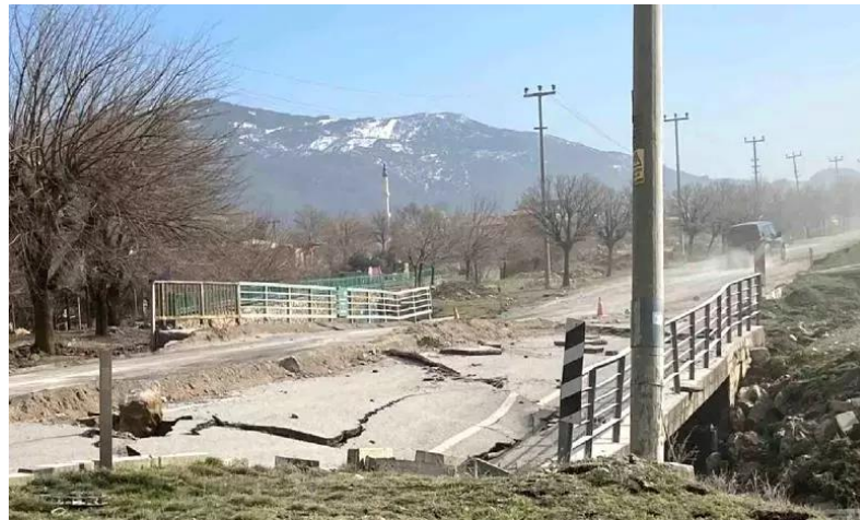
Fotoğraf 3.22 Şekeroba Köprü tabliyesinde meydana gelen göçme
