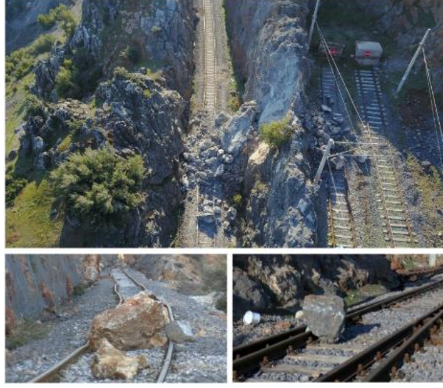
Fotoğraf 3.43 Demiryolu raylarına yuvarlanan kayalar
