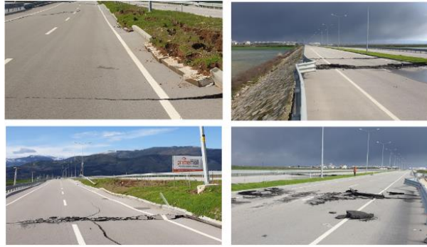
Fotoğraf 3.51 Hatay Havalimanı bağlantı yolunda gözlemlenen hasarlar
