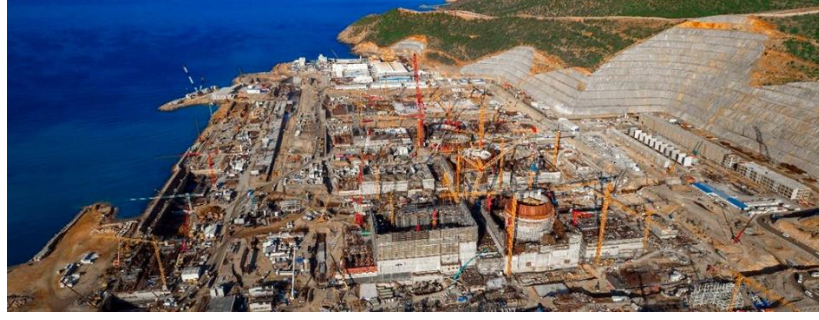
Fotoğraf 3.79 Mersin ilindeki inşaatı devam eden Akkuyu Nükleer Güç Santrali
