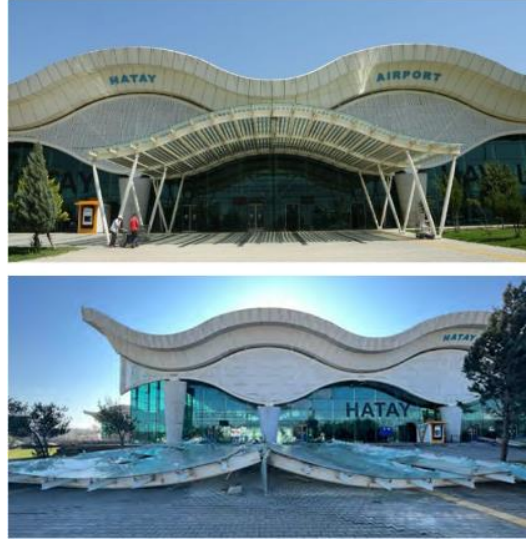
Fotoğraf 3.53 Hatay Havalimanı giriş kanopisin öncesi ve sonrası durum karşılaştırması
