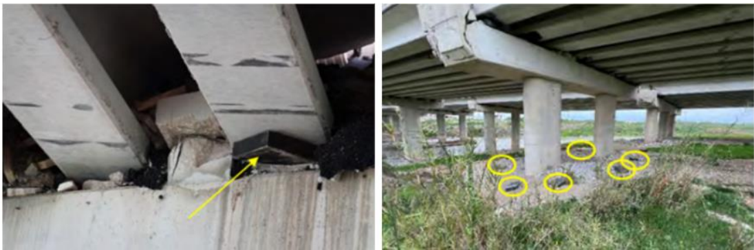
Fotoğraf 3.33 Elastomerik yastıkların yer değiştirmesi
