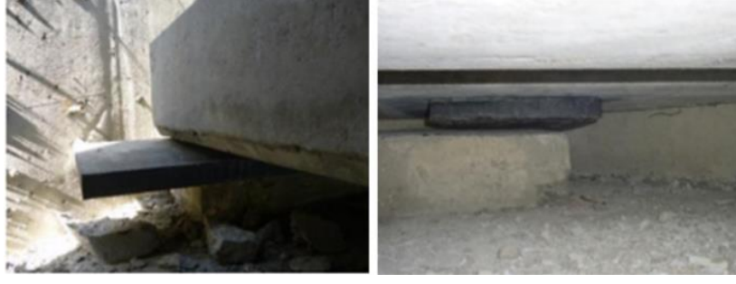
Fotoğraf 3.34 Elastomer yastıkların yerinden oynaması
