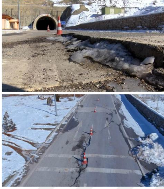
Fotoğraf 3.37 Tünel girişinde gözlemlenen hasarlar
