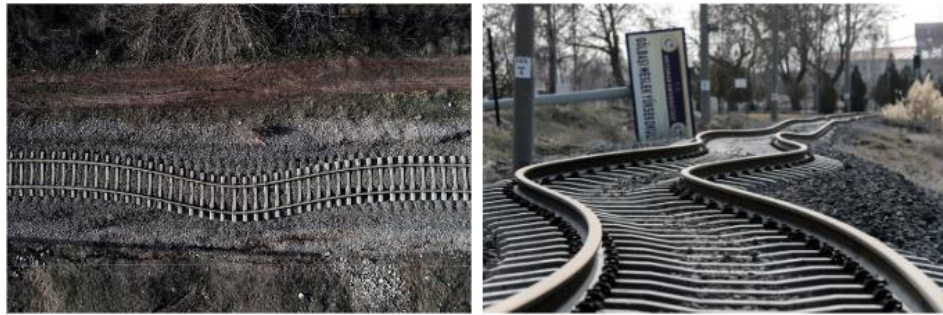
Fotoğraf 3.42 Demiryolu raylarında gözlemlenen deformasyonlar
