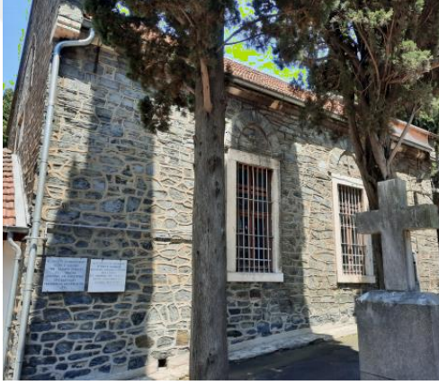
c. Ayios Eleftherios Kilisesi'nin güney cephesi, 2023 (Tolga Değerlier)
