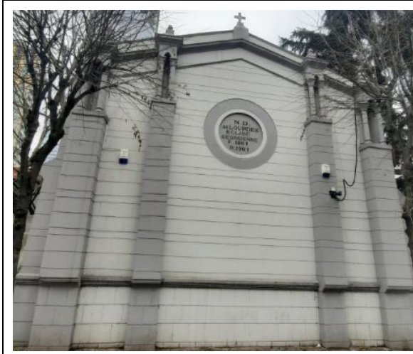
a. Notre Dame de Lourdes Kilisesi'nin dođu cephesi, 2023 (Tolga Deđerlier)
