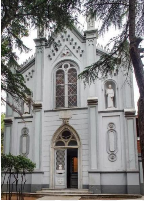
a. San Pasifico Kilisesi (Hasan Kuruyazıcı, Adalar'da Tanrı'nın Evleri , 2014, s.133.)
