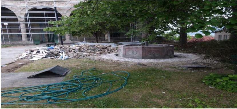
Fotoğraf 3- Mevcut havuzun yıkımı
