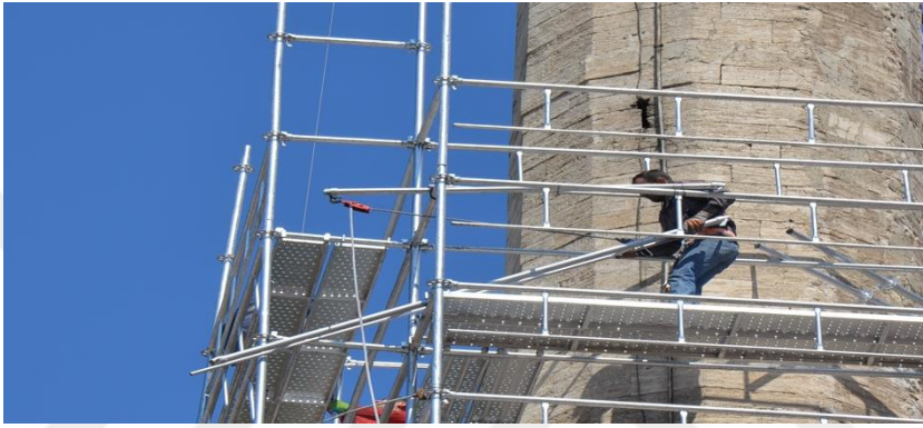
Fotoğraf 2- Minare iskelesinin kurulumu
