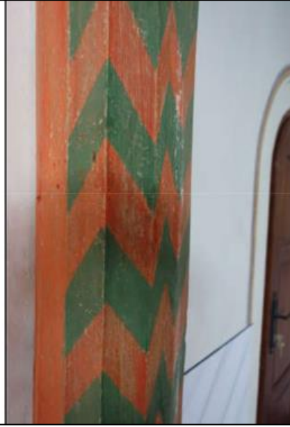
Fotoğraf 2- Mahfilin ahşap dikmeleri, bağlantı kirişleri ve korkuluklarına uygulanmış yeni ve niteliksiz boyaların kaldırılması
