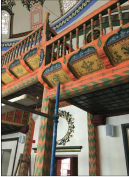
Fotoğraf 2- Mahfilin ahşap dikmeleri, bağlantı kirişleri ve korkuluklarına uygulanmış yeni ve niteliksiz boyaların kaldırılması
