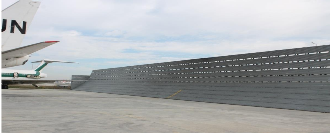
Şekil 58. Motor Testlerinin Yapıldığı Bremze Alanı
