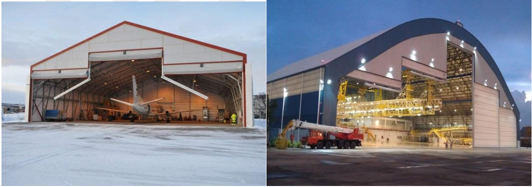
Şekil 10. Uçak bakım hangarları
