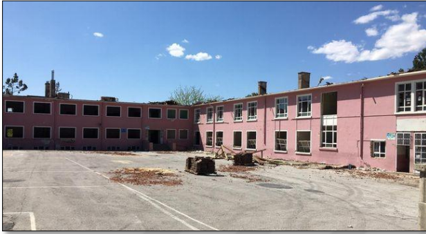
Resim 7.1. Sümer İlkokulu (Yapının kontrollü yıkımı yapılırken) (URL11).
