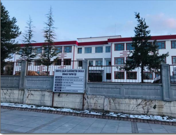
Resim 7.4. Diniye Çalık İlkokulu yeniden tasarımı yapılan binanın son hali (Yazar tarafından eklenmiştir).
