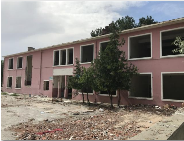
Resim 7.2. Sümer İlkokulu (Yapının kontrollü yıkımı yapılırken) (URL 11).
