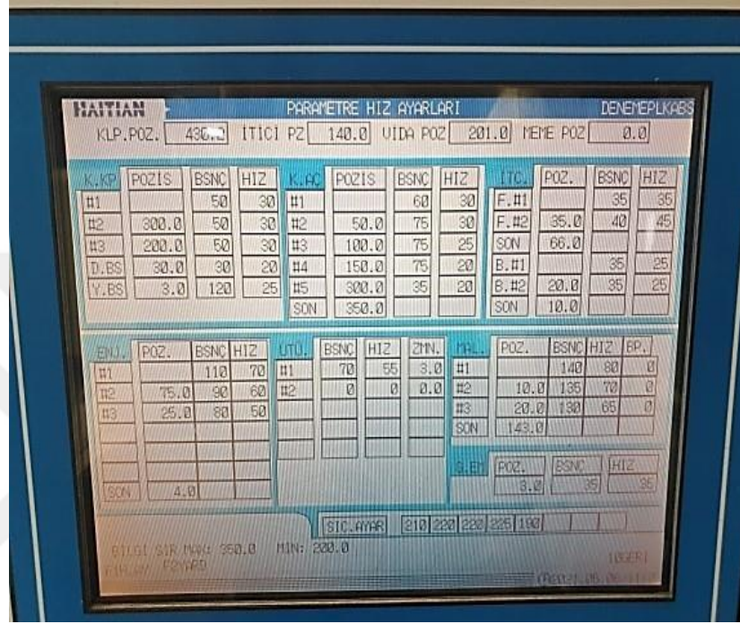
Şekil 3.4 : Enjeksiyon makinesi kontrol paneli.
