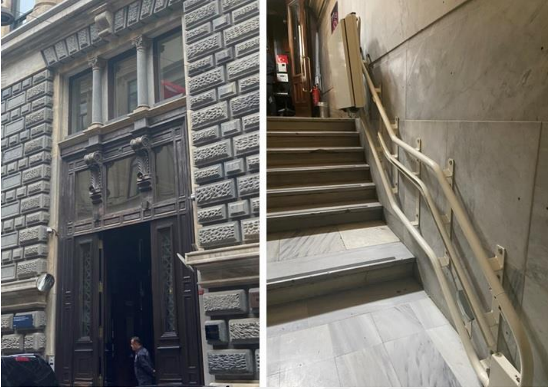
Şekil 107 Salt Galata girişi ve engelli merdiven asansörü (Davutoğlu D., 2022)
