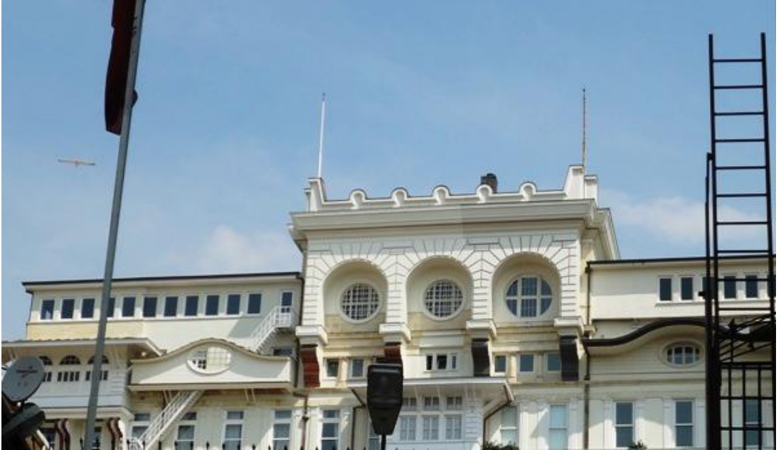
Şekil 19 Salt Galata'nın Güney Cephesi (degisti.com, 2022)
