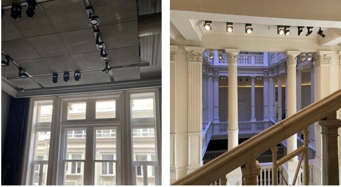
Şekil 140 Panavision marka raylı sistem aydınlatmalar (Davutoğlu D., 2022)
