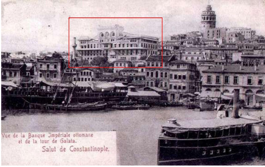
Şekil 10 Osmanlı Bankasının güney cephesinin Osmanlı Dönemindeki görünümü (degisti.com, 2022)
