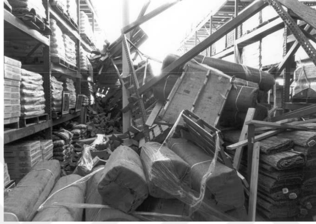
Şekil 2.18: Çapraz koridor doğrultusundaki yapı malzemelerinin uğradığı hasar (FEMA-460, 2005).
