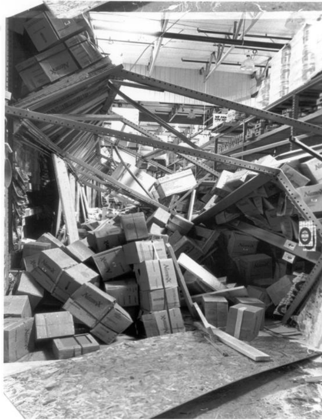
Şekil 2.17: Çapraz koridor doğrultusundaki seramiklerin uğradığı hasar (FEMA-460, 2005).
