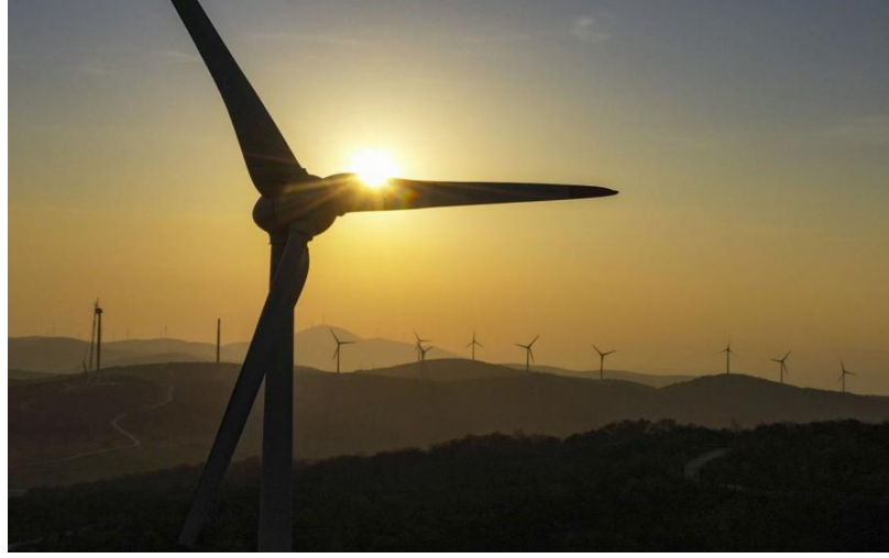
Şekil 2.12. SOMA rüzgâr enerji santralinden bir kesit (Polat Enerji, 2022)
