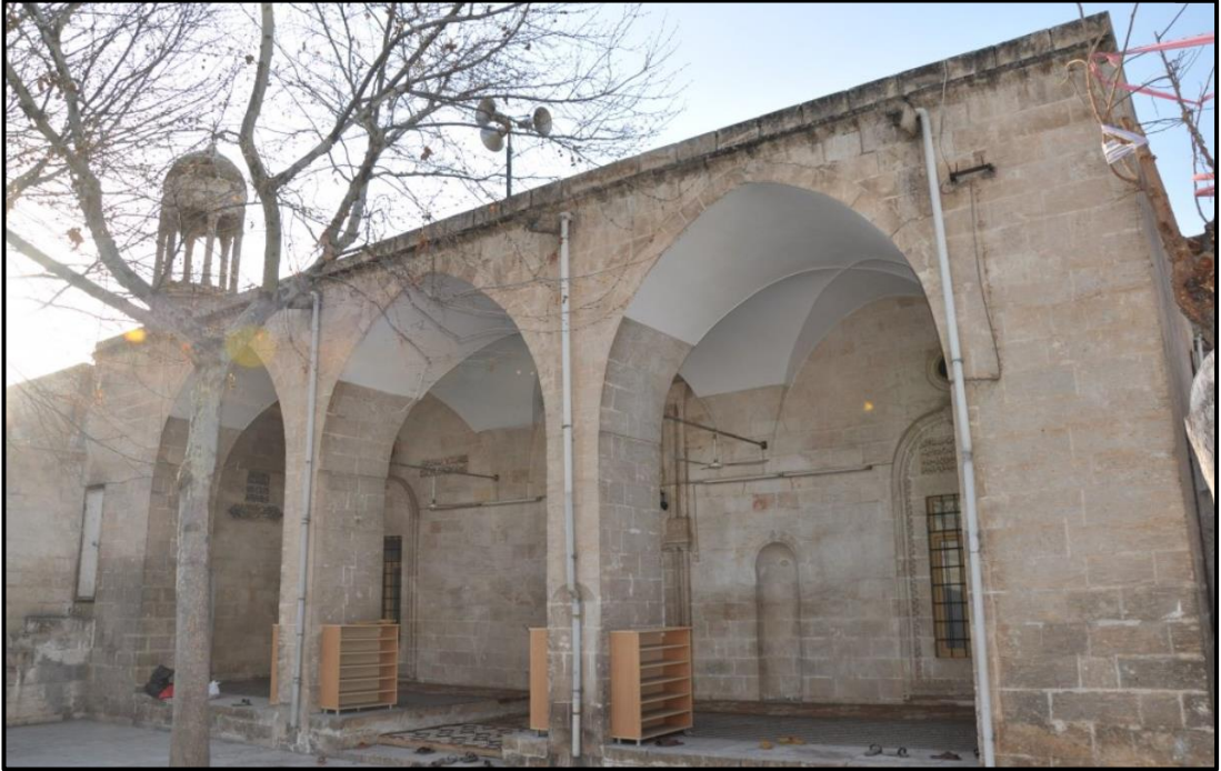
Şekil 3.25 Eski Ömeriye Camii (Cevhermimarlık, 2016)
