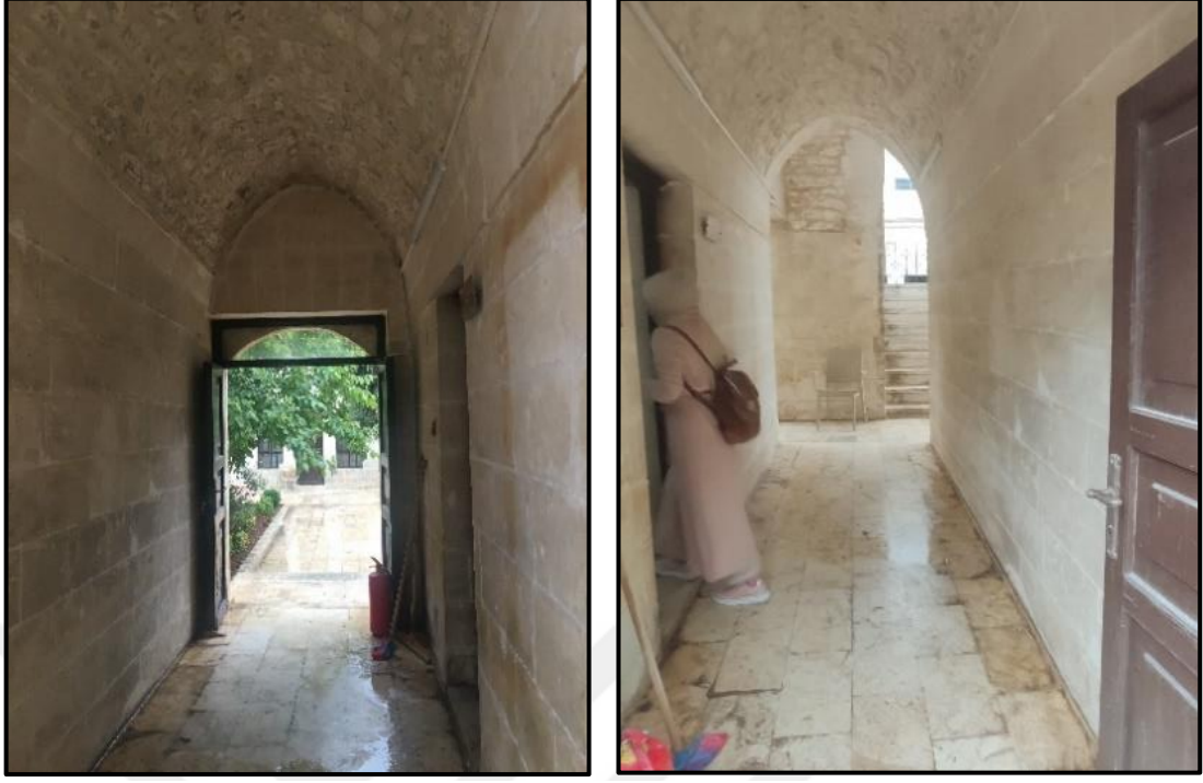
Şekil 4.45 ZK-13 Mutfak ile ZK-14 Yönetim arasından geçen ve avlular arasında bağlantı sağlayan beşik tonozlu koridor (Yazar Arşivi, 2022)
