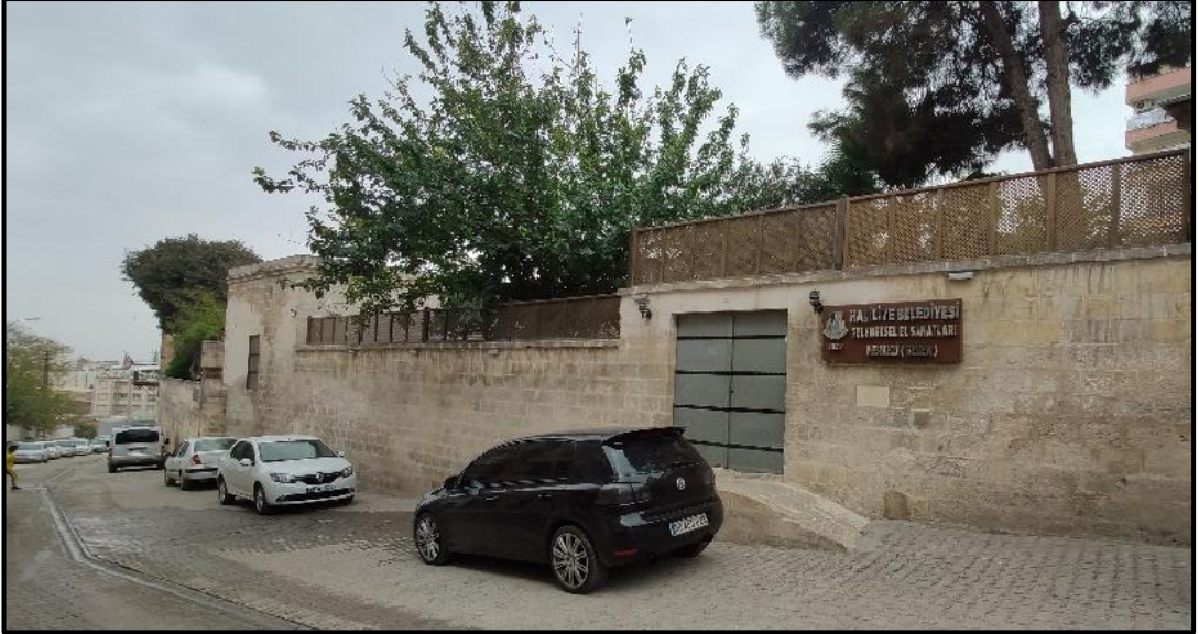
Şekil 4.114 Günümüzde yapının doğu cephesinde bulunan ana giriş kapısı (Yazar arşivi, 2022)
