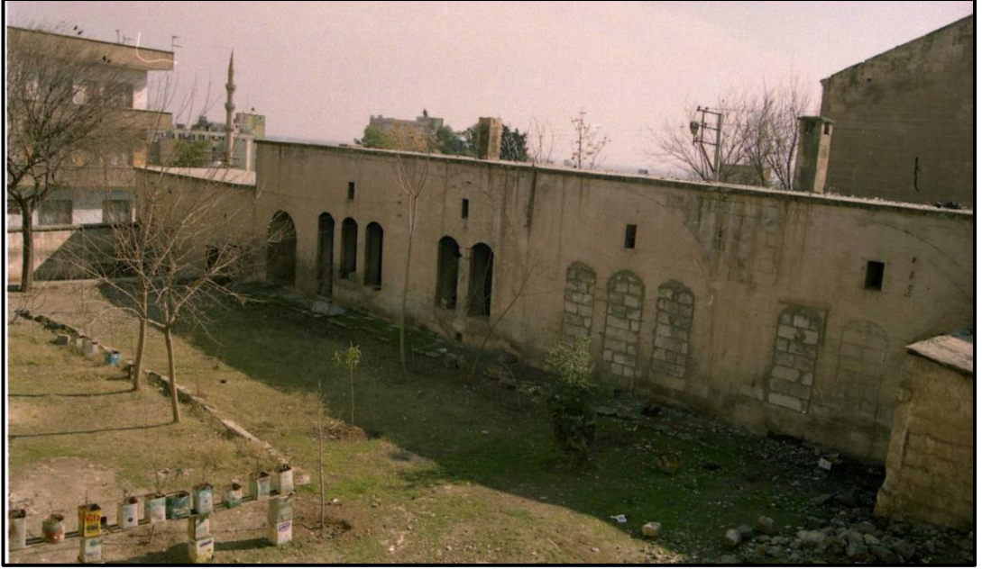
Şekil 4.120 Yapının güneyindeki kütlenin cephesinin 2002'de yapılan restorasyon çalışmasından önce çekilen fotoğrafı (S. Sabri Kürkçüoğlu arşivinden,2022)
