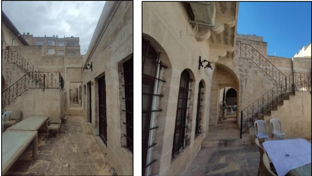
Şekil 4.34 Avluyu bölen merdiven ve geçiş kapıları (Yazar arşivi, 2022)
