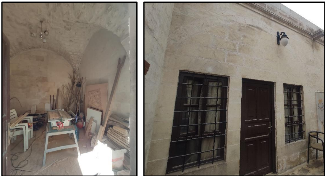
Şekil 4.38 ZK-10 ahşap atölyesi depo iç ve dış mekan fotoğrafları (Yazar arşivi, 2022)
