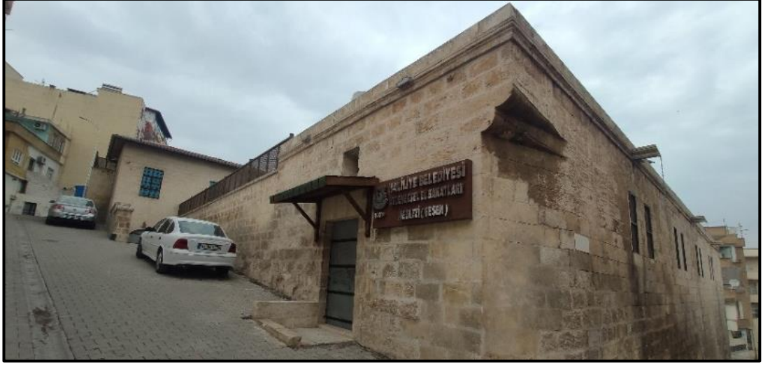
Şekil 4.115 Yapının batı cephesinde bulunan ve sonradan açılan kapı (Yazar arşivi, 2022)
