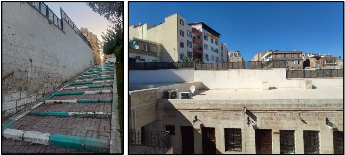
Şekil 4.77 Yapının kuzeyinde bulunan merdivenli sokak ve yapıyı çevreleyen betonarme yapılar (Yazar arşivi,2022)
