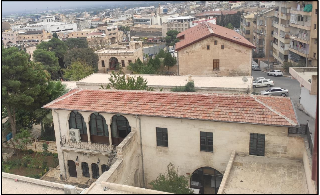
Şekil 4.85 Yapının iki katlı bölümünün üst örtüsü (Yazar arşivi, 2022)
