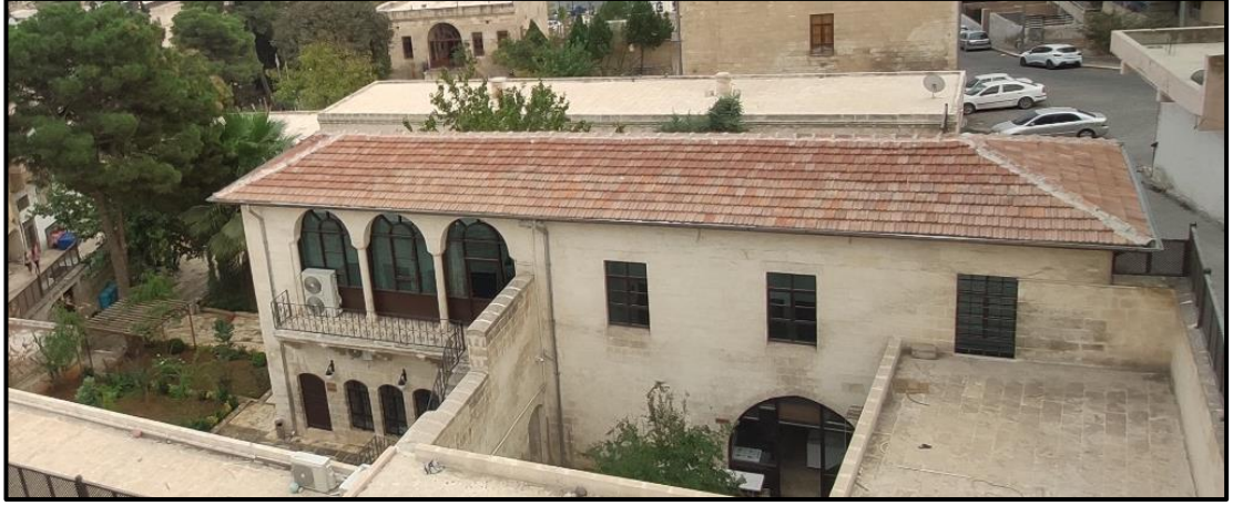
Şekil 4.62 Yapının iki katlı bölümünün kuzey cephesi ve çatısı (Yazar arşivi, 2022)
