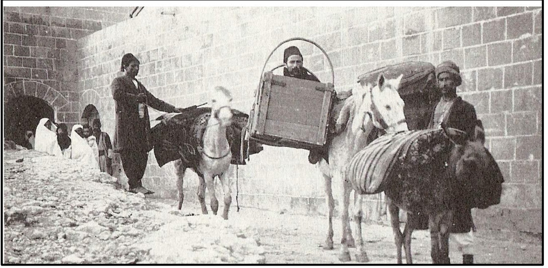
Şekil 4.113 Yapının batı avlu duvarında bulunan kapı, 1912 (Kieser ,2013)
