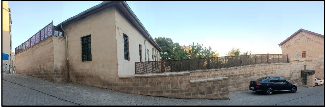
Şekil 4.74 Yapının batı cephe fotoğrafı (Yazar arşivi, 2022)
