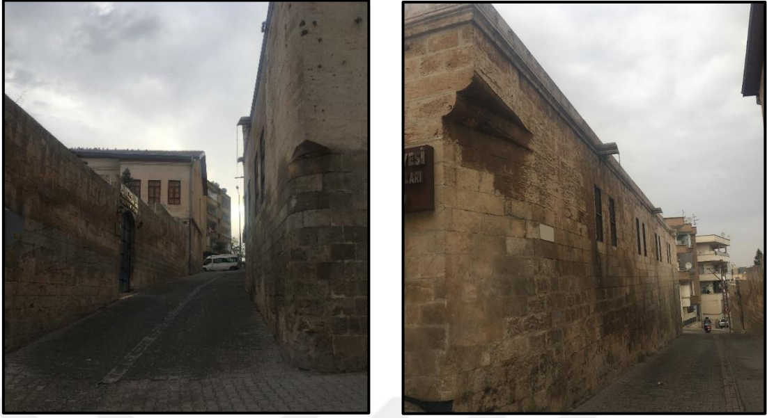
Şekil 4.68 Yapının Güneyindeki sokağa bakan cephesinde bulunan köşe pahları (Yazar arşivi, 2022)
