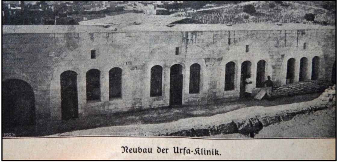
Şekil 4.111 Yapının güneyinde bulunan kütlenin yapı hastaneye çevrilirken çekilen fotoğrafı, 1901 (A.Cihat Kürkçüoğlu arşivi, 2022).
