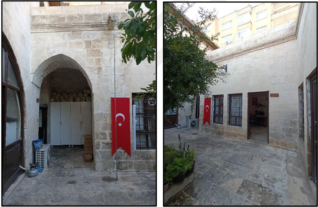
Şekil 4.65 Doğu avlu cephesi (Yazar arşivi, 2022)
