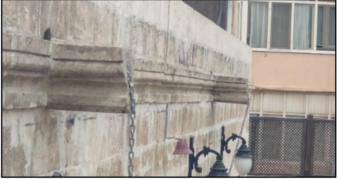
Şekil 4.66 Avluya bakan cephede yapıya ait taş silme ve çörtenler (Yazar arşivi, 2022)
