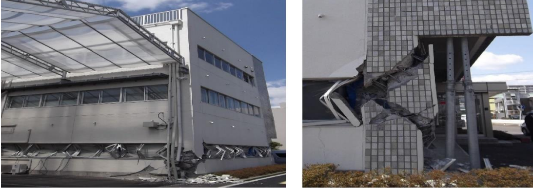
Şekil 1.3 : 2011 Tohoku (Japonya) depreminde betonarme binalarda gözlemlenen hasarlar (Aydan ve Tano, 2011).
