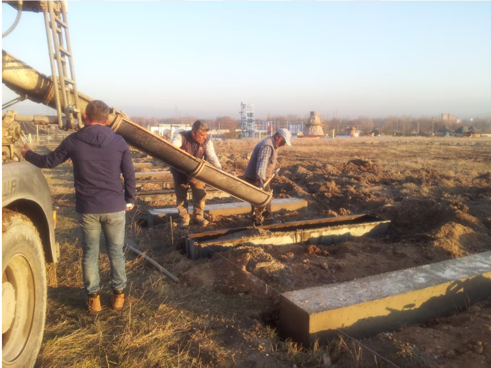
Şekil 3.1. Çelik konstrüksiyonların montajı için hazırlanan beton kalıplar.
