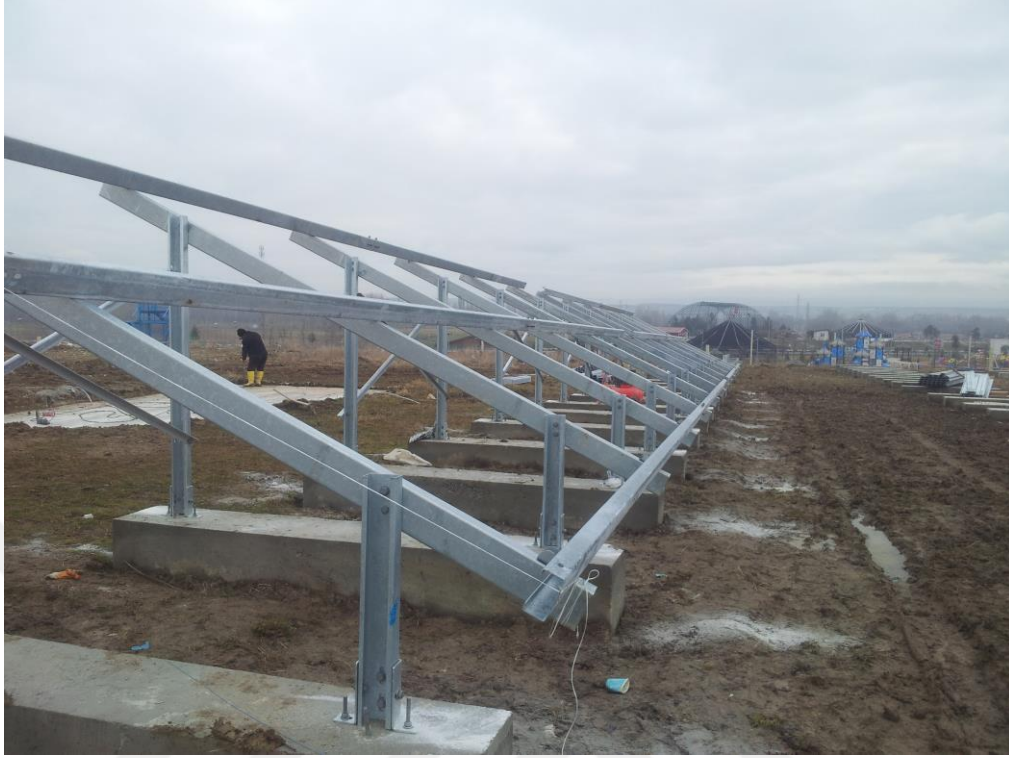
Şekil 3.2. Çelik konstrüksiyon montajları.
