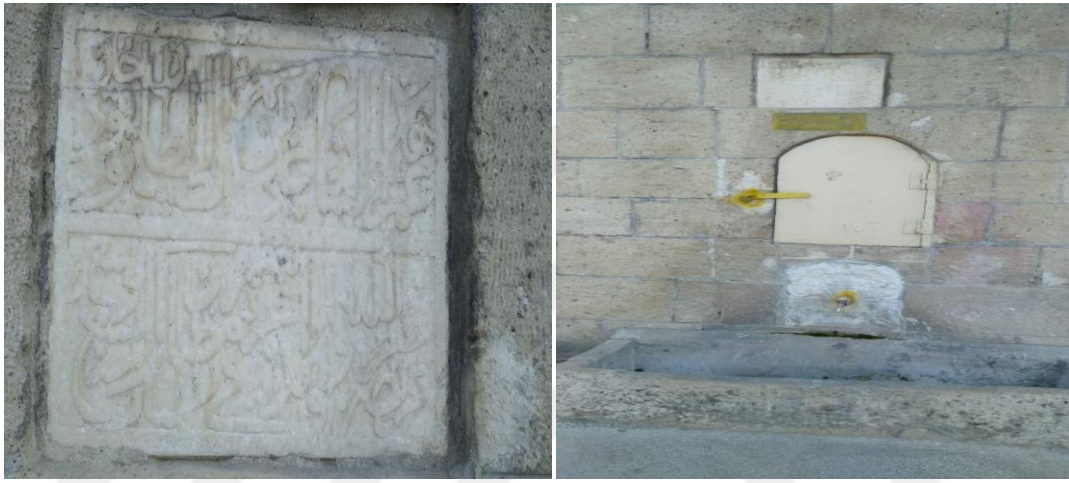
Şekil 3. 2 Çeşme Damı Çeşmesi
