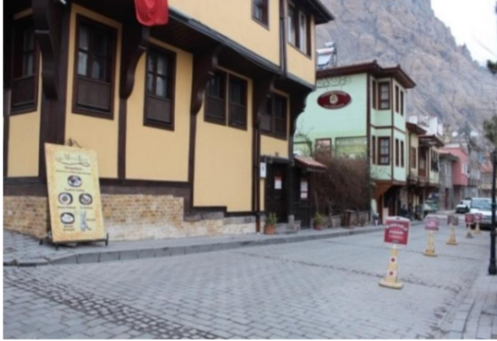
Resim 3.16. Mihrioğlu Konak Restoran çevresindeki yapılar [70]
