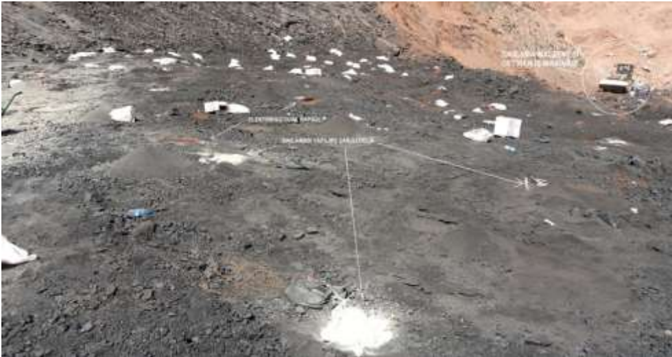
Şekil 3.13. Kömür Atım alanı delik şarj çalışmaları sonrası görüntüsü
