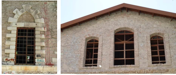
Şekil 3.10. Kuzey Cephe Pencere Görünümü
