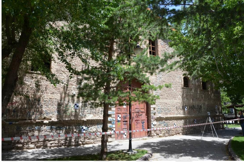
Şekil 3.30. Güney Cephe Görünümü
