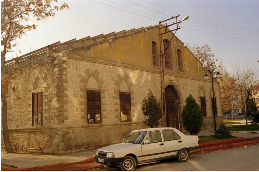
řekil 3.4. Tantavi Ambarı Restorasyon ncesi n Cephe Grnř
