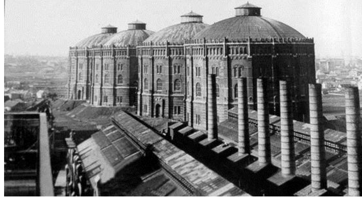
Şekil 2.26. Viyana Gazometreleri Eski Görünüşü 1995
