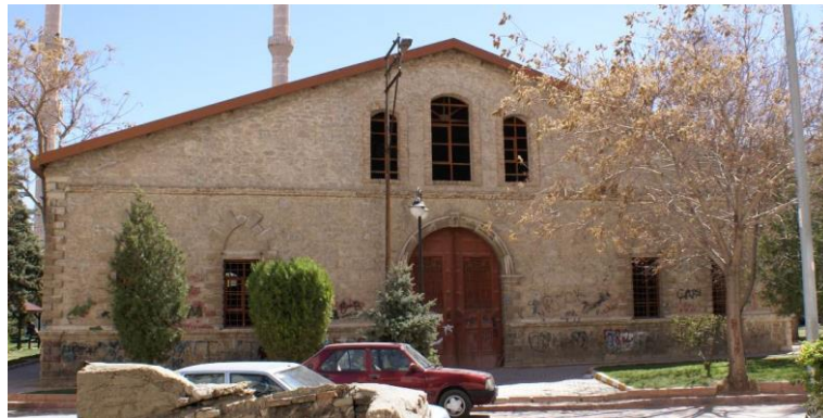
Şekil 3.24. Tantavi Ambarı Binası
