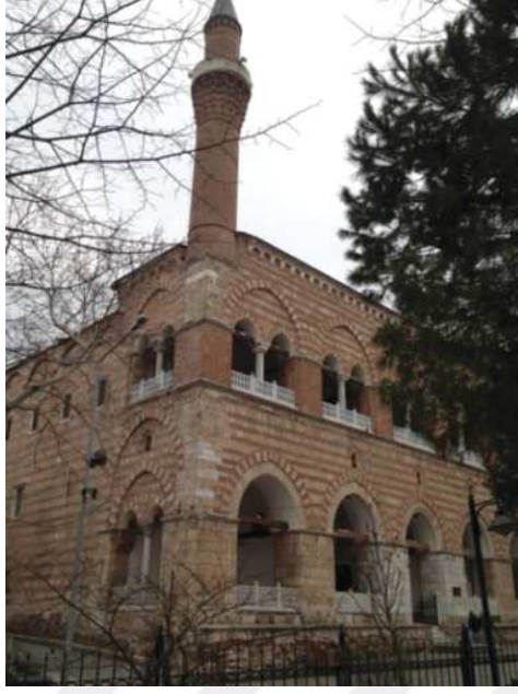
Fotoğraf 213: Bursa Hüdavendigâr İmaretî Kuzeydoğu Görünüm
