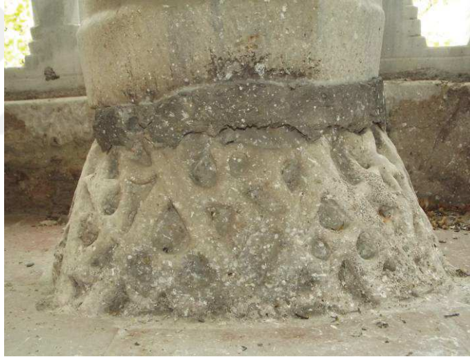
Fotoğraf 28: Bursa Hüdavendigar İmareti Üst Kat Revakında Bulunan Sütun Kaidesi
